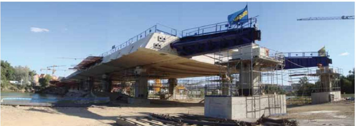
Fig. 4 P3M. Empuje del tablero
