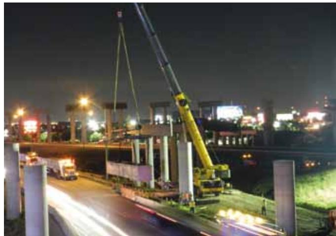
Fig. 14. Dintel mixto: sección y proceso de instalación
