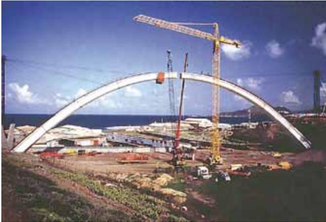
Fig. 2 VT. Montaje del arco, próximo al cierre en clave
