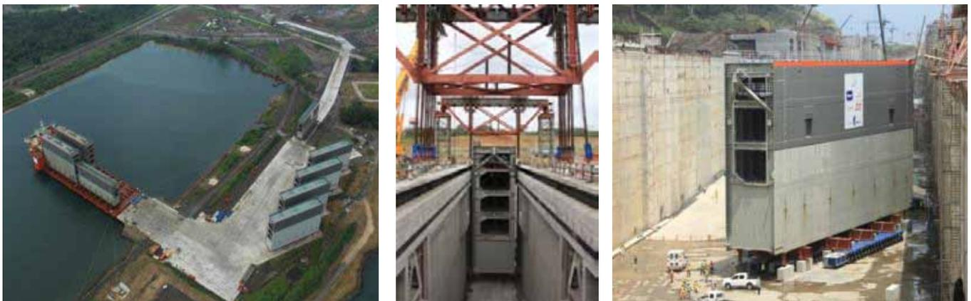
Fig. 16. Transporte e instalación de compuertas
