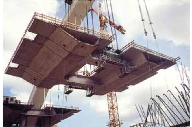
Fig. 3 VT. Izado de una dovela de tablero desde el arco
