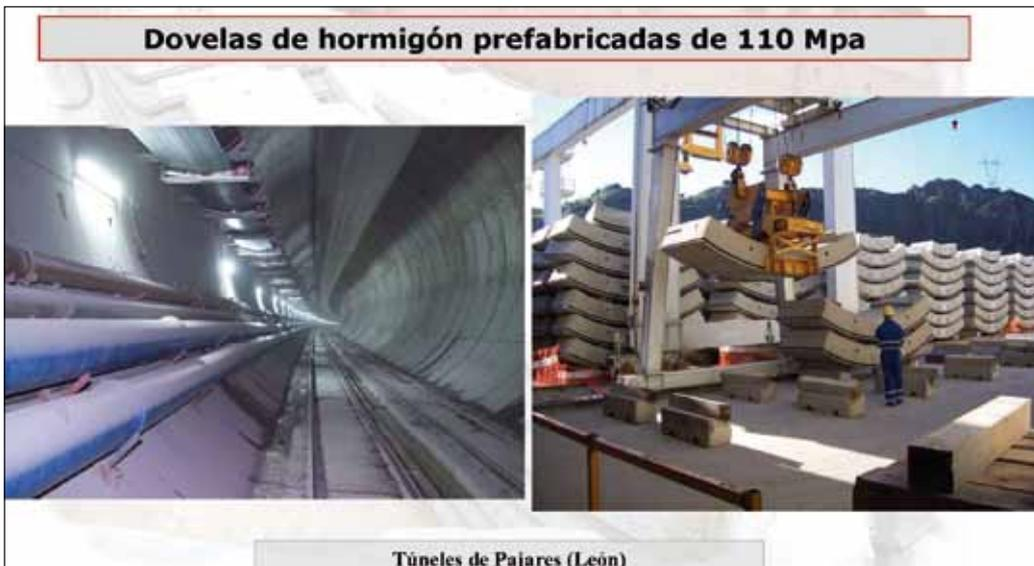
Fig. 17. Dovelas prefabricadas de hormigón de altas prestaciones
