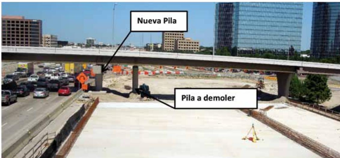
Figura 21. Enlace DNT. Movimiento de pilas
