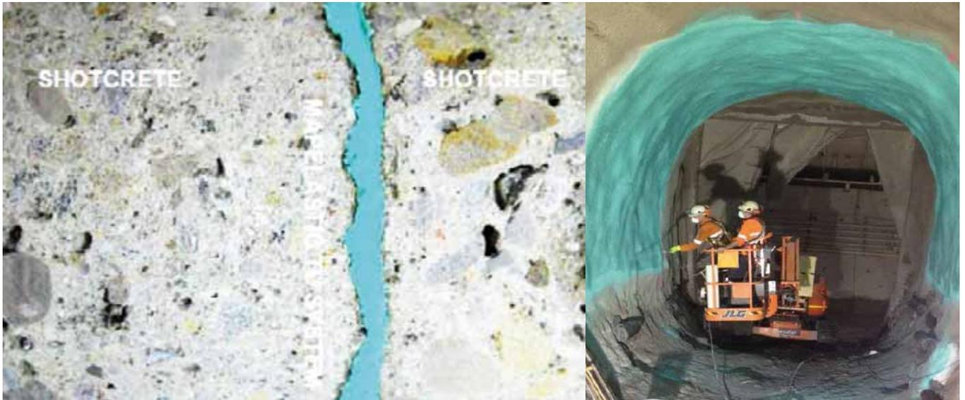
Fig. 9. Membrana proyectada con detalle de su instalación
