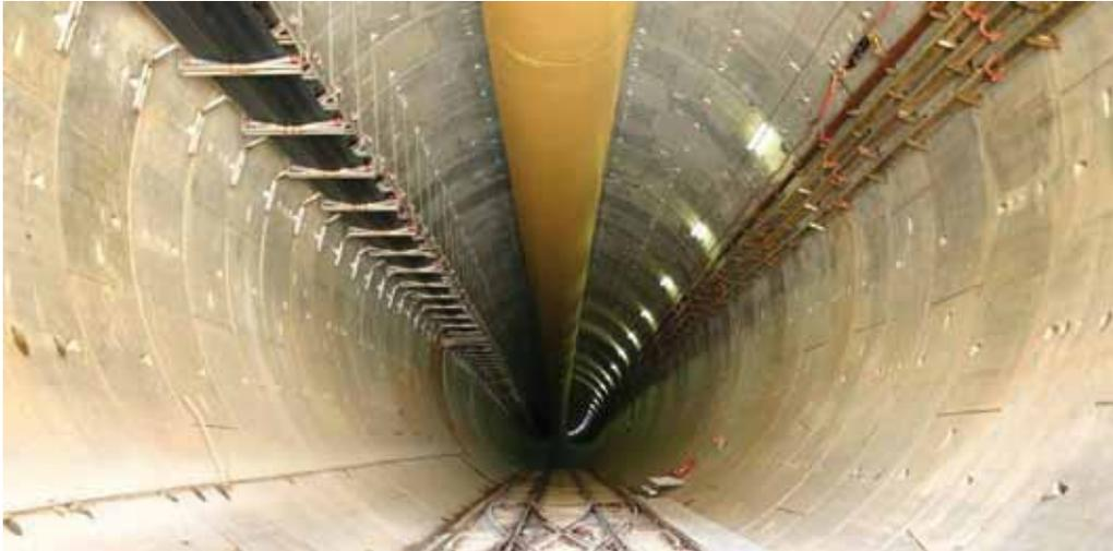
**Fig. 13. Desescombro mediante cinta continua**
