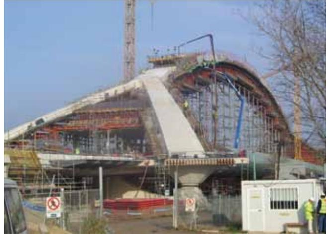
Fig. 5 P3M. Cimbra, ferrallado y hormigonado arco
