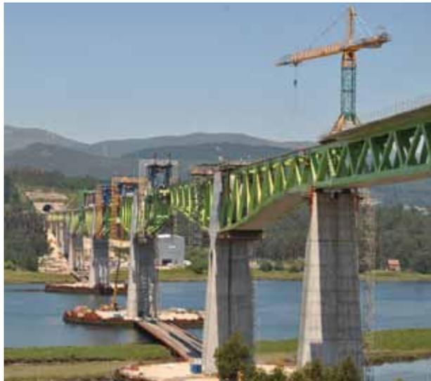
**Fig. 6 PFU. Vista carros y plataformas sobre tablero en voladizo, y grúa torre sobre tablero en primer plano**
