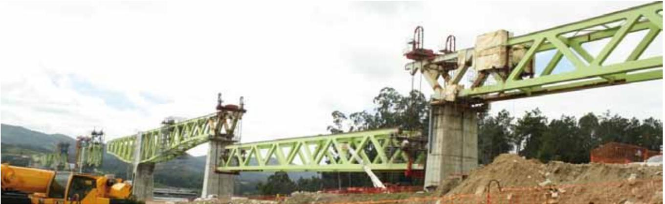
Fig. 3 PFU. Vista del izado del vano 10 (entre P9 y P10)
