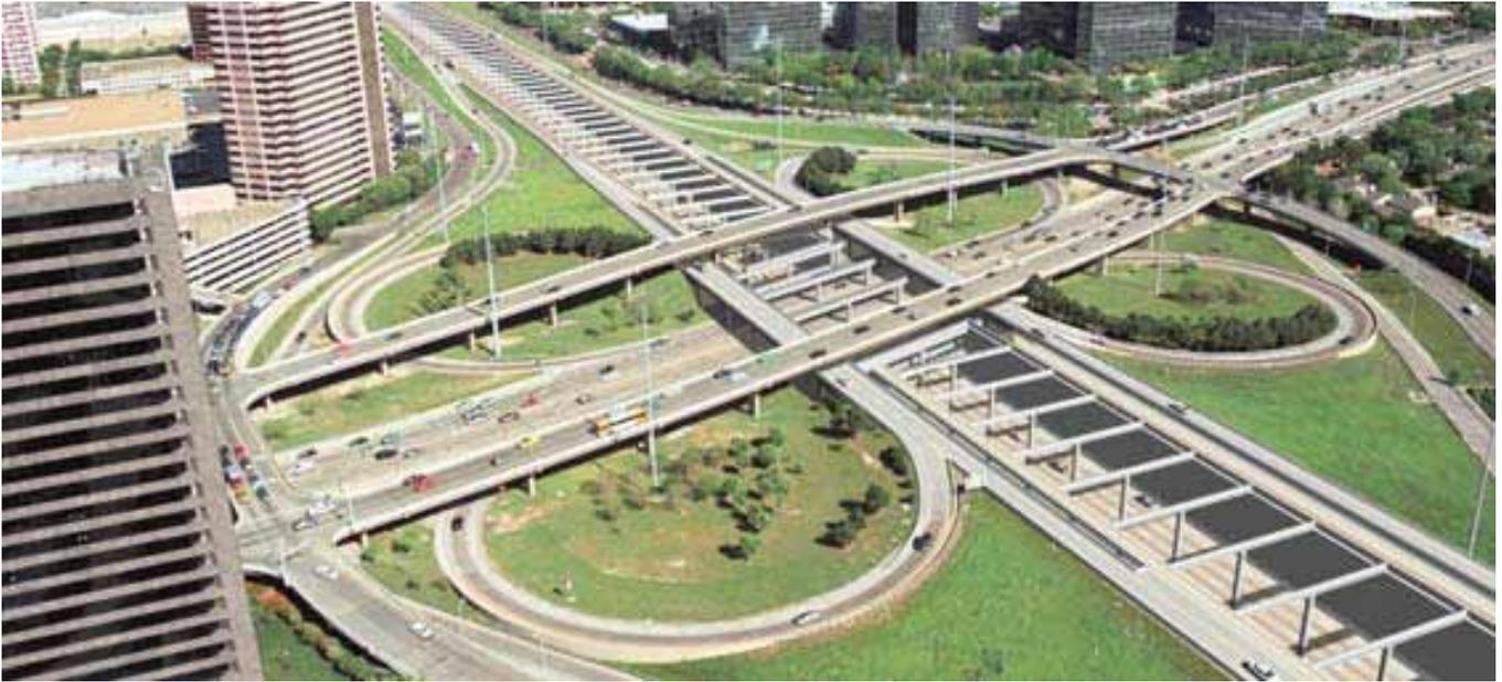
Fig. 19. Enlace DNT: solución original con cuatro niveles
