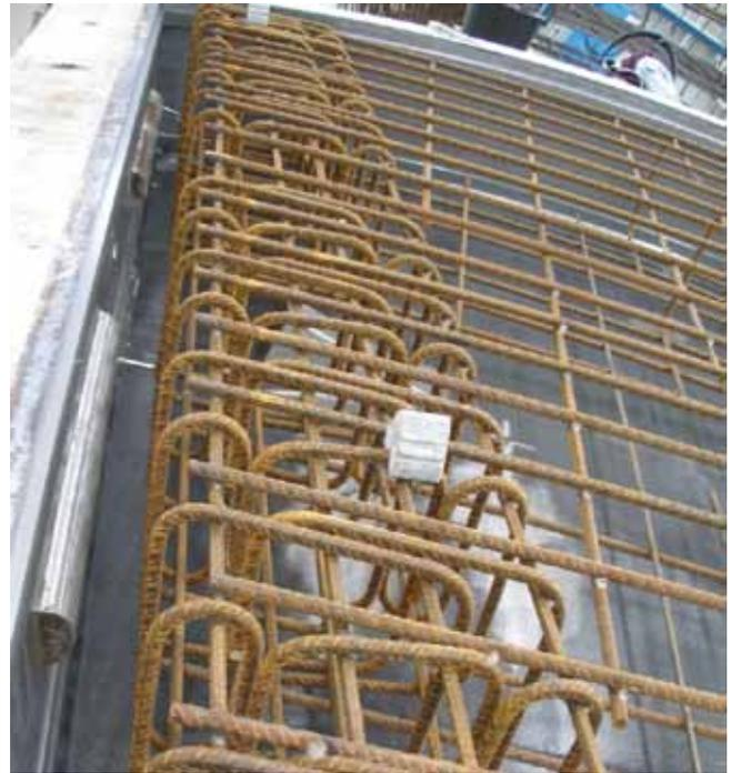
Fig. 18 Detalle optimizado de armadura de la dovela en barras
