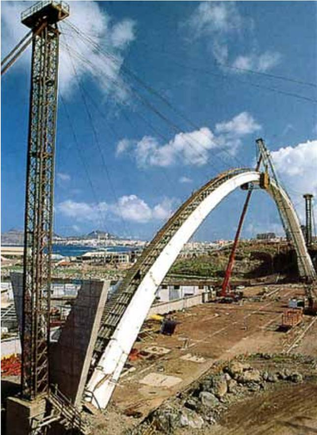
Fig. 1 VT. Arco montado
