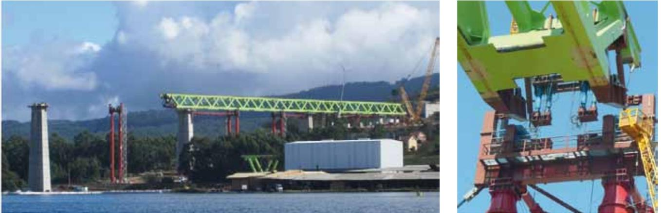
Fig. 2 PFU. Vista general del lanzamiento (izquierda) y detalle de apoyo deslizamiento sobre apeo provisional
