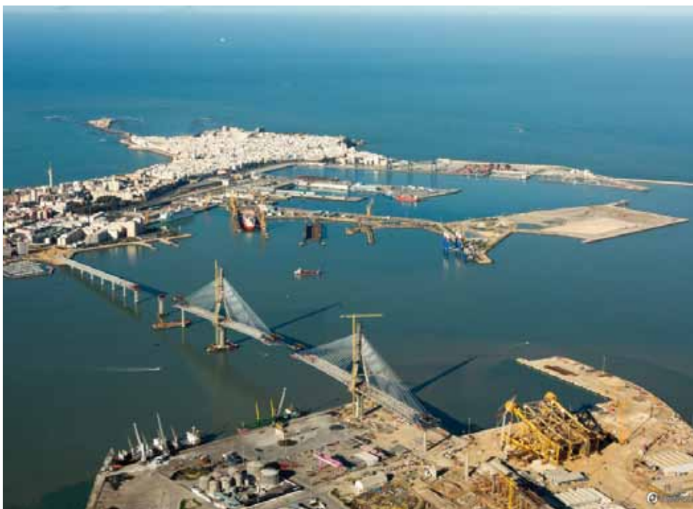
Fig. 3. Puente de la Constitución de 1812, Cádiz (España)
