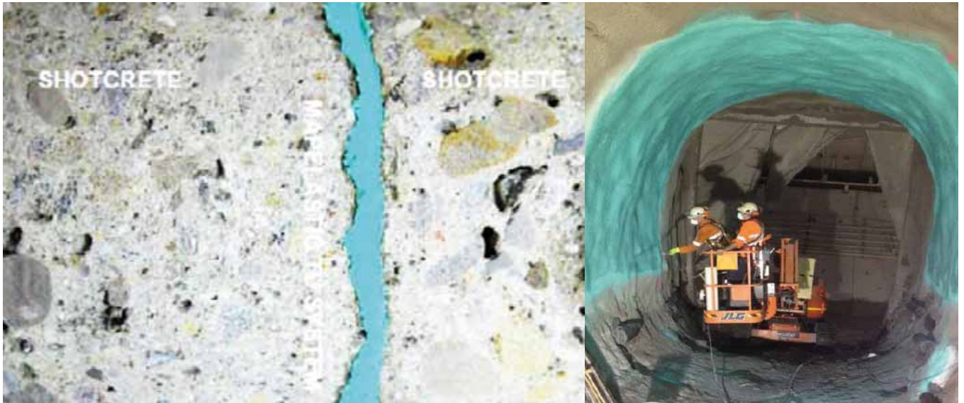
Fig. 9. Membrana proyectada con detalle de su instalación
