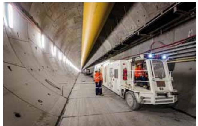
Fig. 15. Vehículos sobre neumáticos usados en el proyecto Legacy Way
