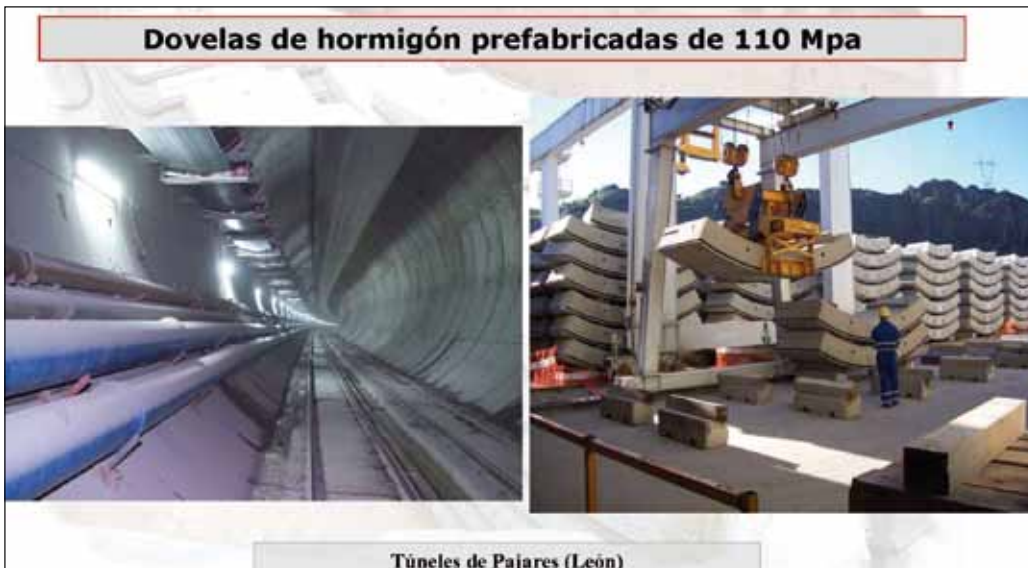
Fig. 17. Dovelas prefabricadas de hormigón de altas prestaciones
