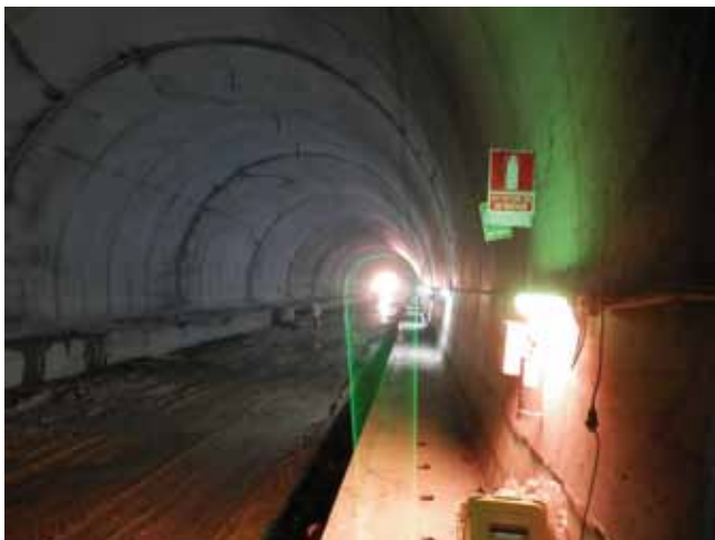
Fig. 8. Muestra de los ensayos realizados por Acciona I+D+i en el túnel de alta velocidad de Padornelo (Zamora)
