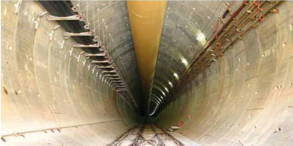
Fig. 13. Desescombro mediante cinta continua
