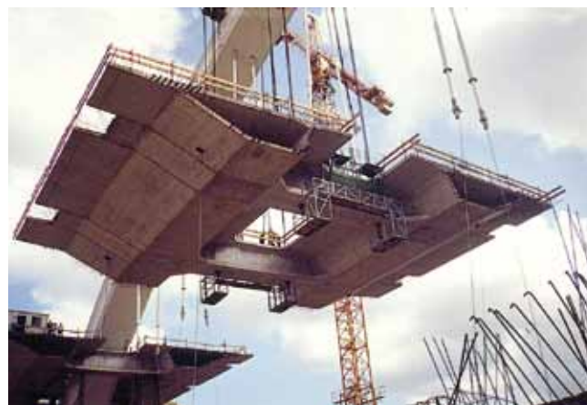
Fig. 3 VT. Izado de una dovela de tablero desde el arco
