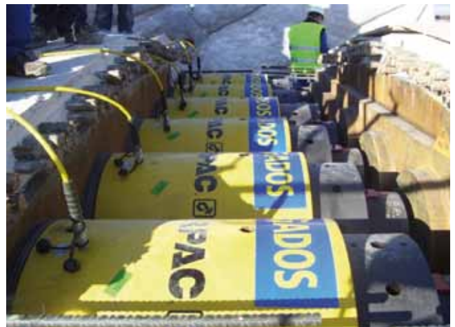
Fig. 6 P3M. Chapones de refuerzo y gatos para apertura en clave
