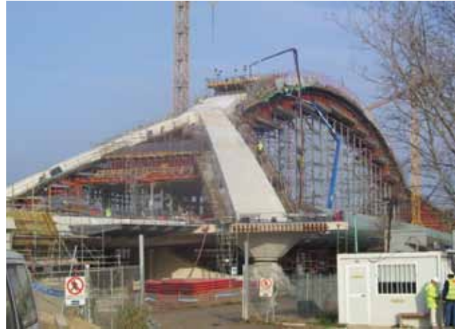
Fig. 5 P3M. Cimbra, ferrallado y hormigonado arco
