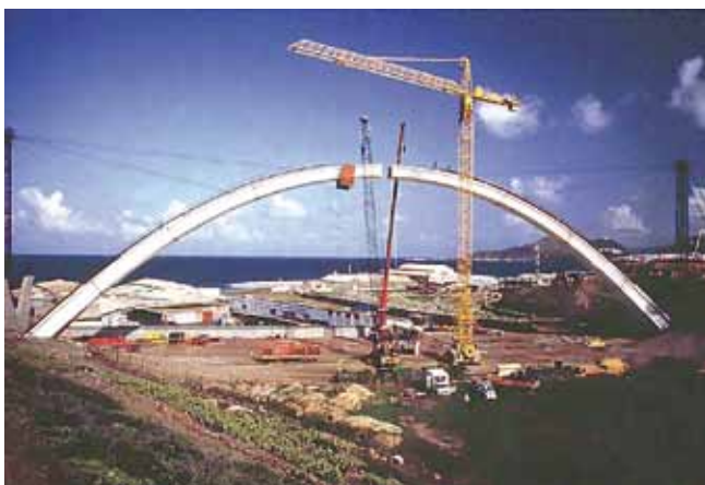
Fig. 2 VT. Montaje del arco, próximo al cierre en clave
