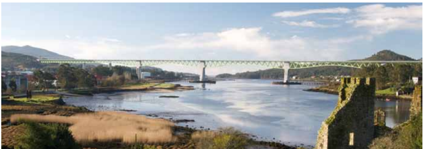
Fig. 1 PFU. Vista general del viaducto terminado
