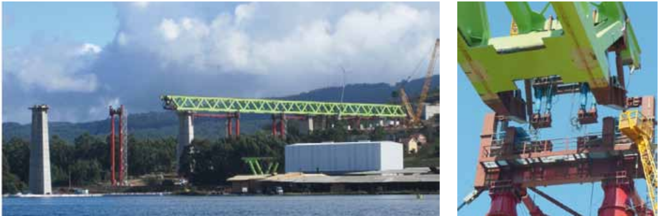
Fig. 2 PFU. Vista general del lanzamiento (izquierda) y detalle de apoyo deslizamiento sobre apeo provisional
