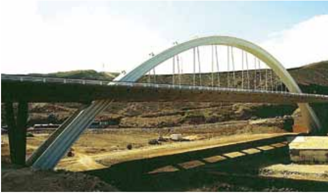
Fig. 5 VT. Viaducto terminado
