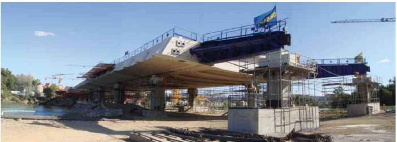
Fig. 4 P3M. Empuje del tablero
