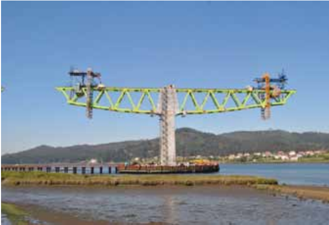
Fig. 5 PFU. Vista de los pórticos de izado
