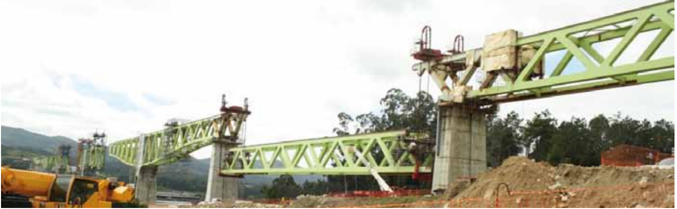
Fig. 3 PFU. Vista del izado del vano 10 (entre P9 y P10)
