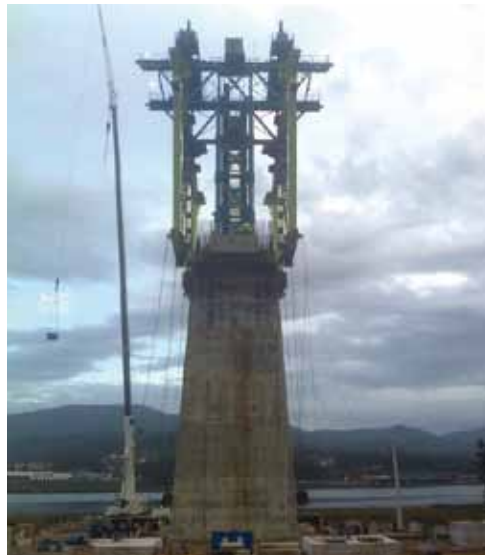
Fig. 4 PFU. Verticalización del cabecero (imagen izquierda) y del izado (imagen derecha)
