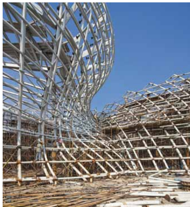
Fig. 8. La doble curvatura de la estructura del Pabellón de España en la Expo 2010 en Shanghái (China)
