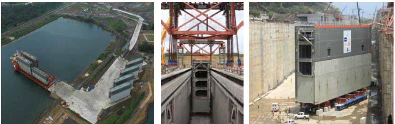
Fig. 16. Transporte e instalación de compuertas
