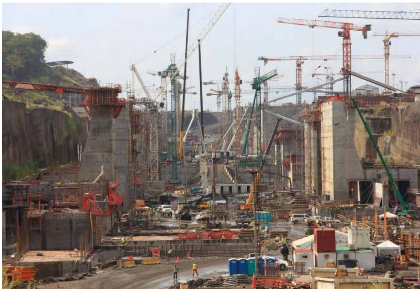
Fig. 14. Conjunto de esclusas del lado Atlántico en plena actividad de hormigón en 2012
