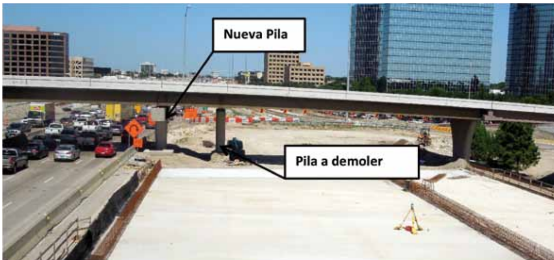
Figura 21. Enlace DNT. Movimiento de pilas
