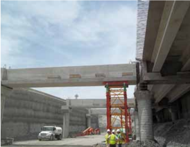
Fig. 10. Dinteles prefabricados. Apoyo provisional antes del postesado de cosido
