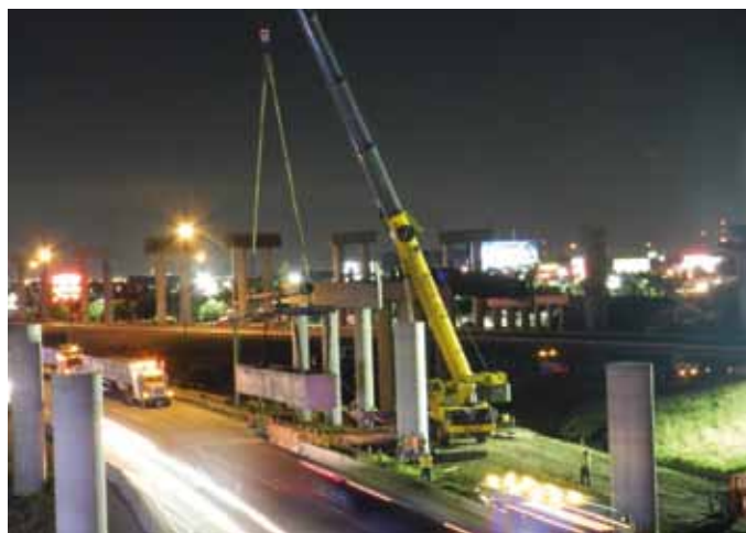
Fig. 14. Dintel mixto: sección y proceso de instalación
