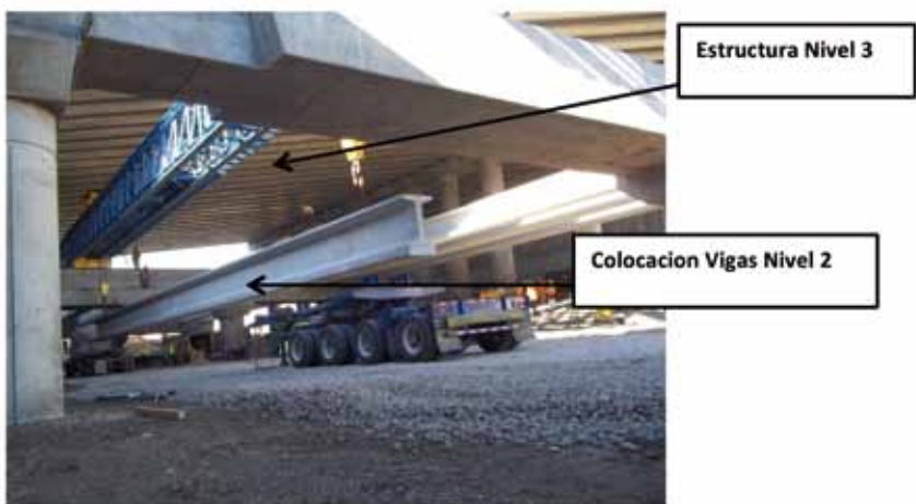
Fig. 17. Colocación vigas nivel 2 Paso Superior de Marsh Lane
