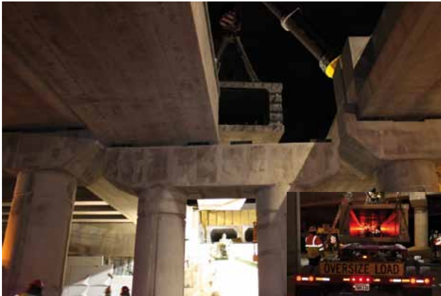
Fig. 15. Instalación del uno de los vanos prefabricados del acueducto de Joe Ratcliff
