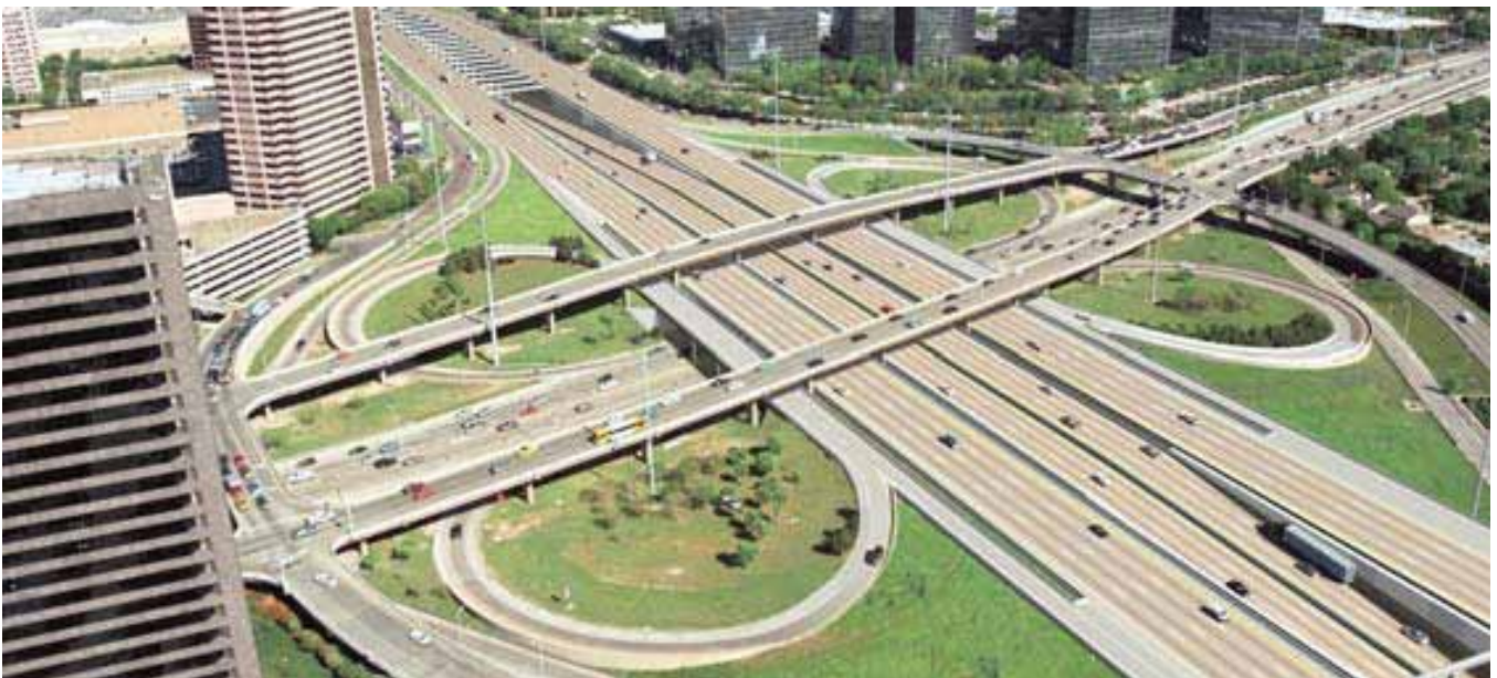
Fig. 20. Enlace DNT: solución construida con tres niveles. Calzadas libres y peaje al mismo nivel
