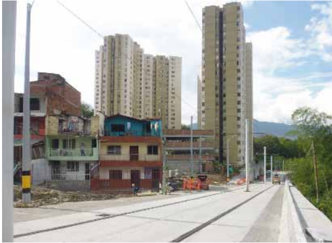
Carril guiado central y sistema de rodillos
