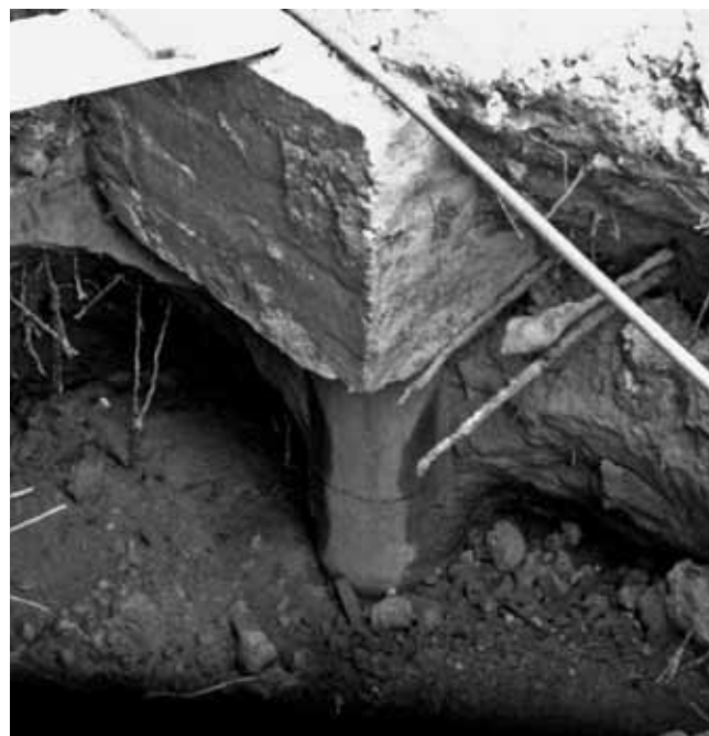
Fig. 5. Pilote fisurado
