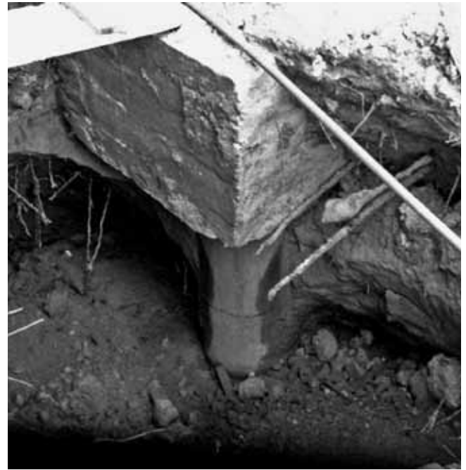
Fig. 5. Pilote fisurado
