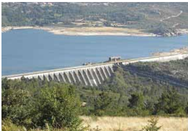
Fig. 8. Presa de Salas
