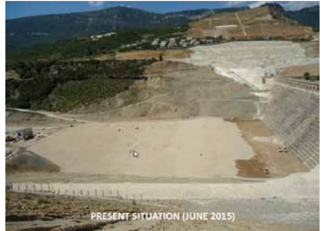
Fig. 15. Vista general de la estabilización (junio 2015)
