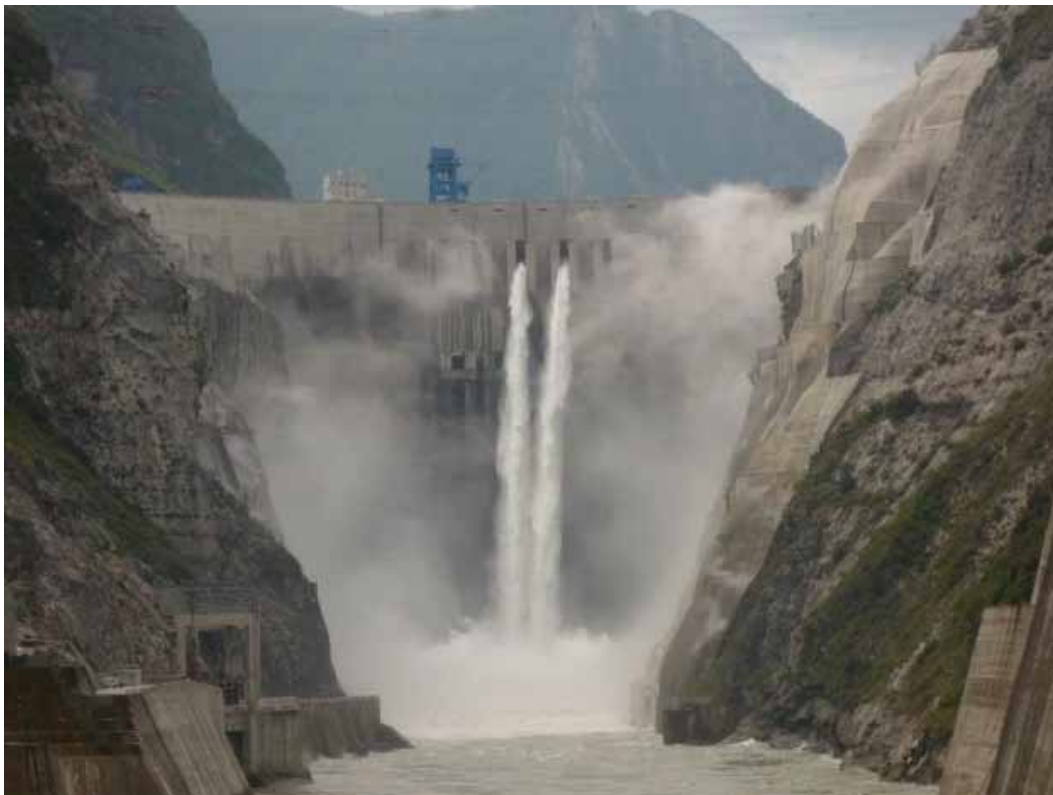
Fig. 9. Vista de la presa de Jinping I desde aguas abajo
