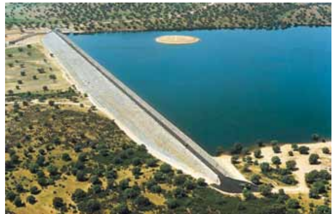
Presa de Cubilar
