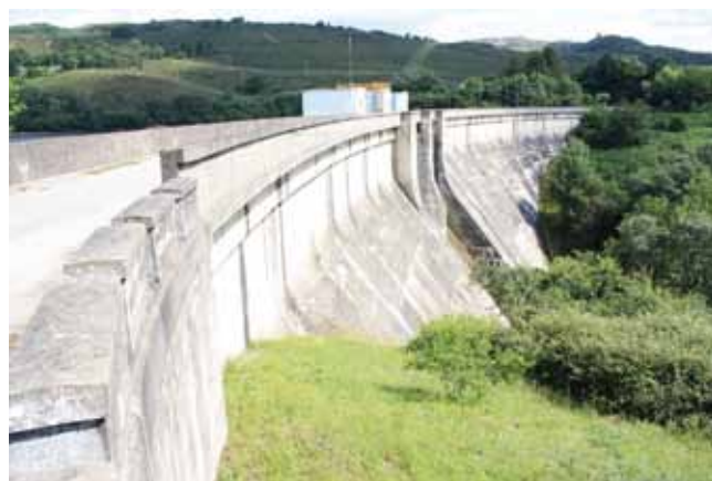
Fig. 9. Presa Las Conchas
