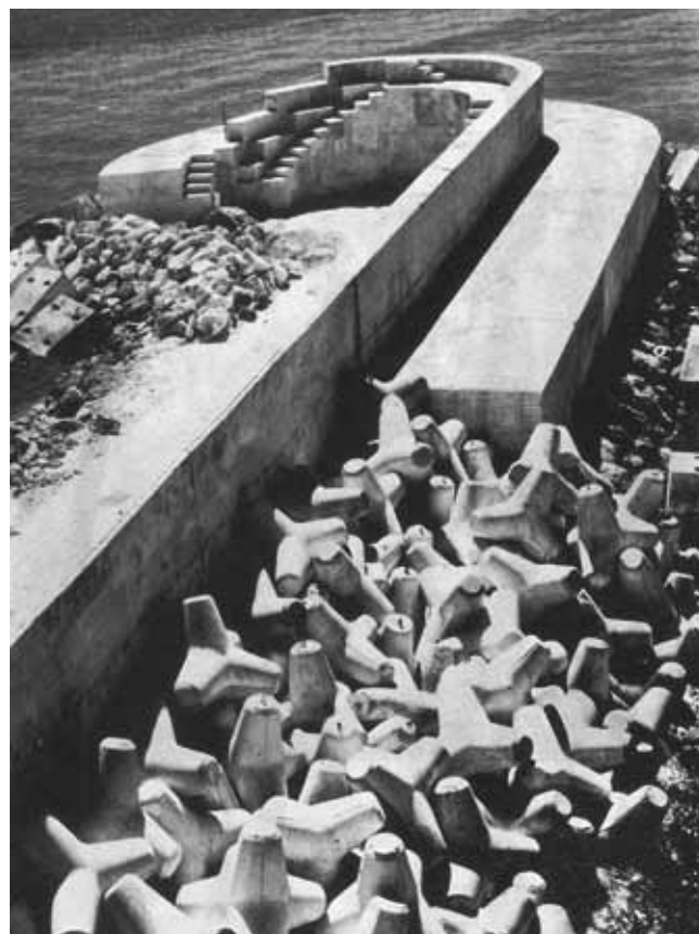
Base Naval de Rota. Rompeolas de Tetrápodos. Fuente: SPANCOLD
