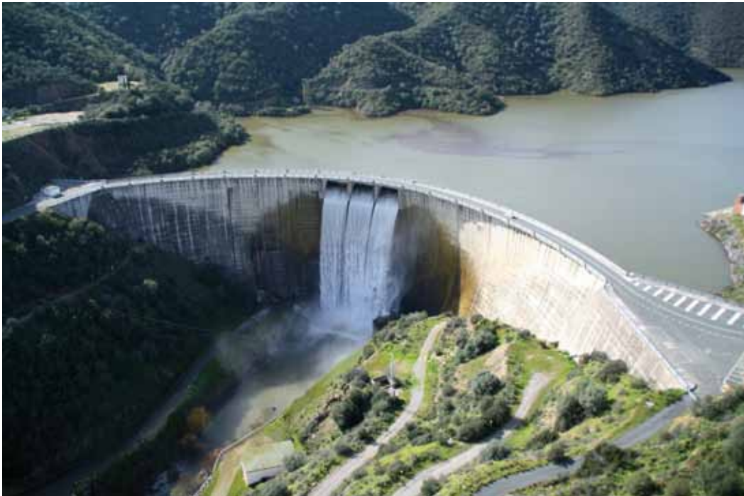
Presa José Torán (Sevilla). Fuente: Confederación Hidrográfica del Guadalquivir
