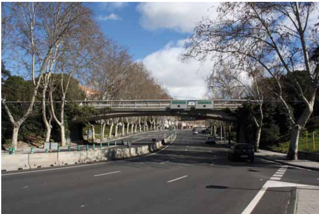
Puente de Tranvías en la Avenida de los Reyes Católicos (Madrid). Imagen superior: año 1945. Imagen inferior: actualidad. Fuente: SPANCOLD
