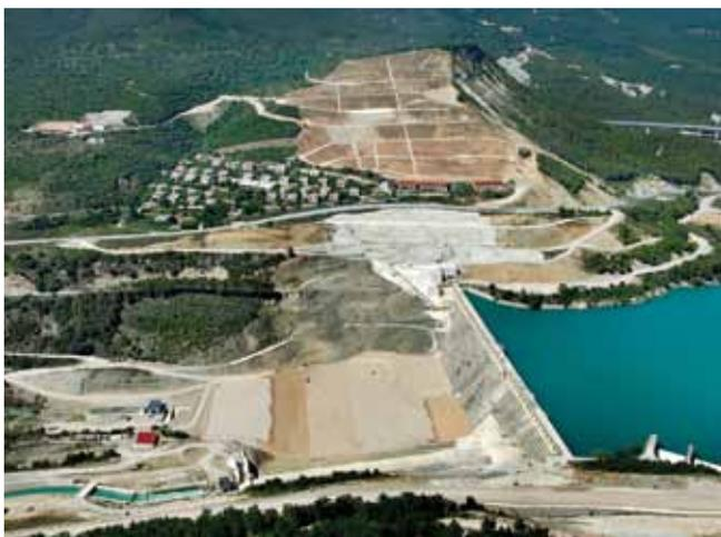
La nueva presa se situará en una cerrada conformada por calizas cretácicas con un buzamiento general de 30° hacia aguas abajo, con dirección aproximada este-oeste.
