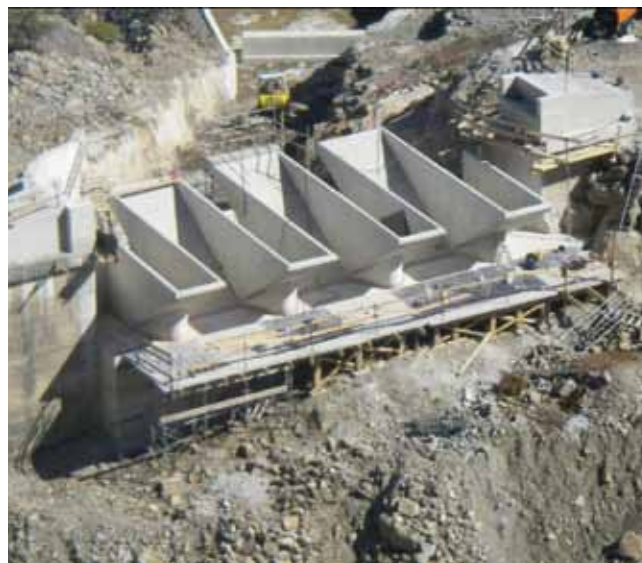
Fig. 1. Vertedero en tecla de piano de la presa de Gloriettes (Francia) (R45)
