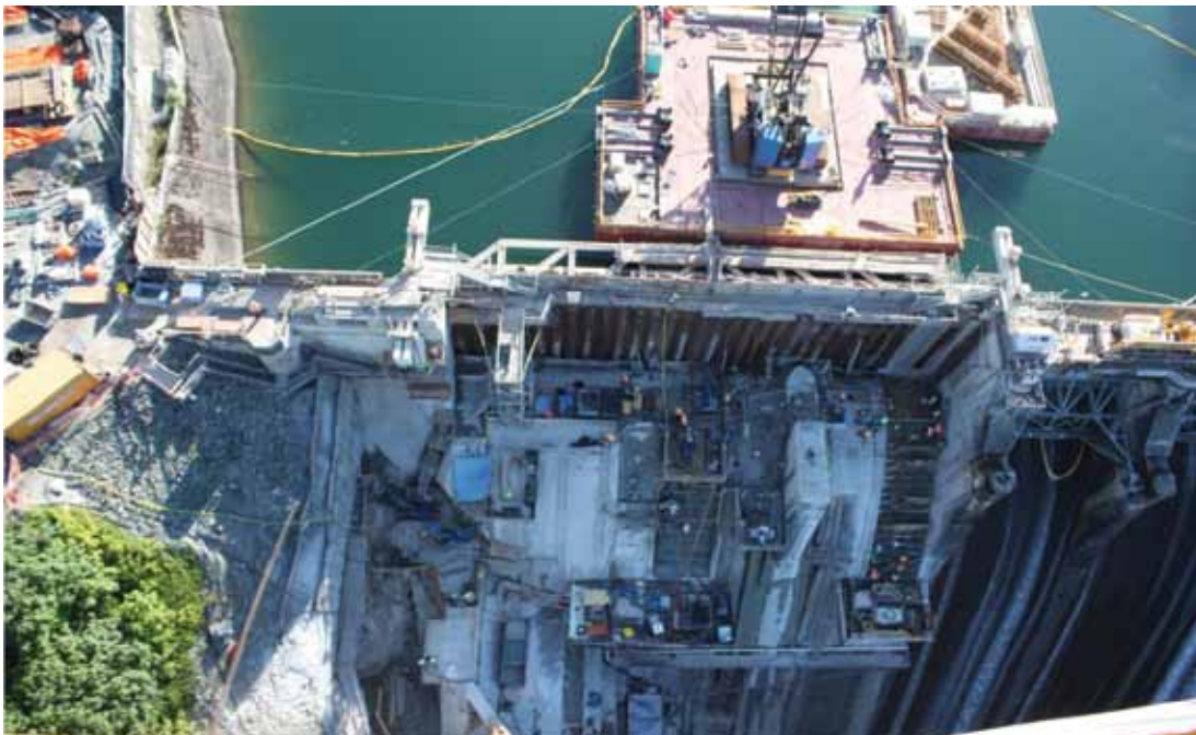
Fig. 4. Adaptación del aliviadero de la presa Ruskin (Cánada) (R33)
