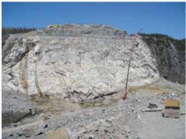
Fig. 9. Estribo derecho de la presa de Romanie 2 tras la excavación
