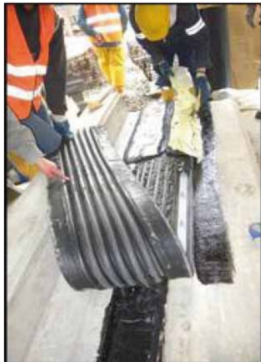
Fig. 4. Disposiciones específicas de la junta perimetral en la presa de Mazar (Ecuador)
