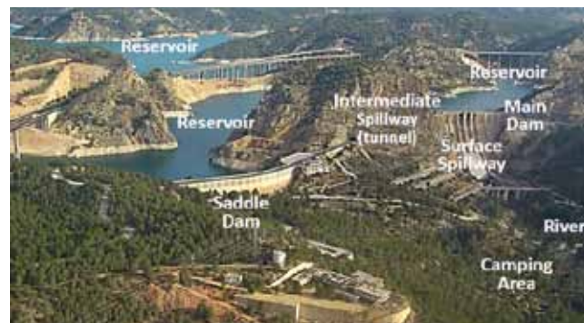
Fig. 3. Vista general del emplazamiento
