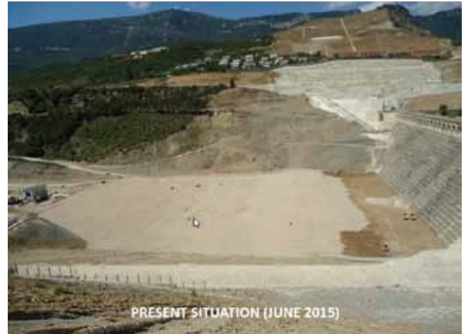
Fig. 15. Vista general de la estabilización (junio 2015)
