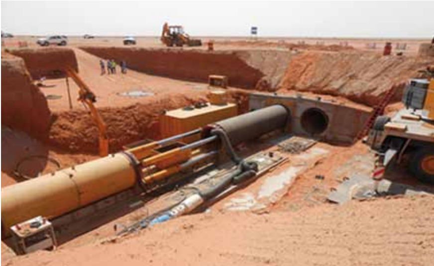
Detalle de microtúnel
