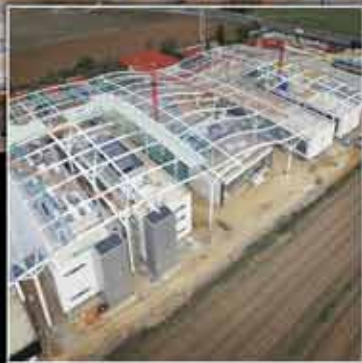
Campus de Formación de Iberdrola Project & Construction Management. San Agustín de Guadalix, Madrid
