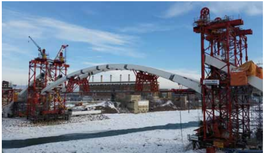
Manobra de izado de parte central
