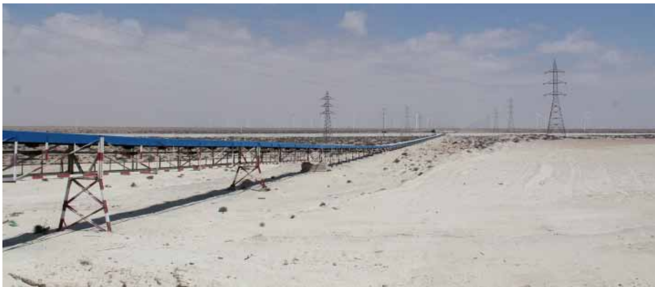
Cinta transportadora de fosfatos por el desierto del Sáhara
