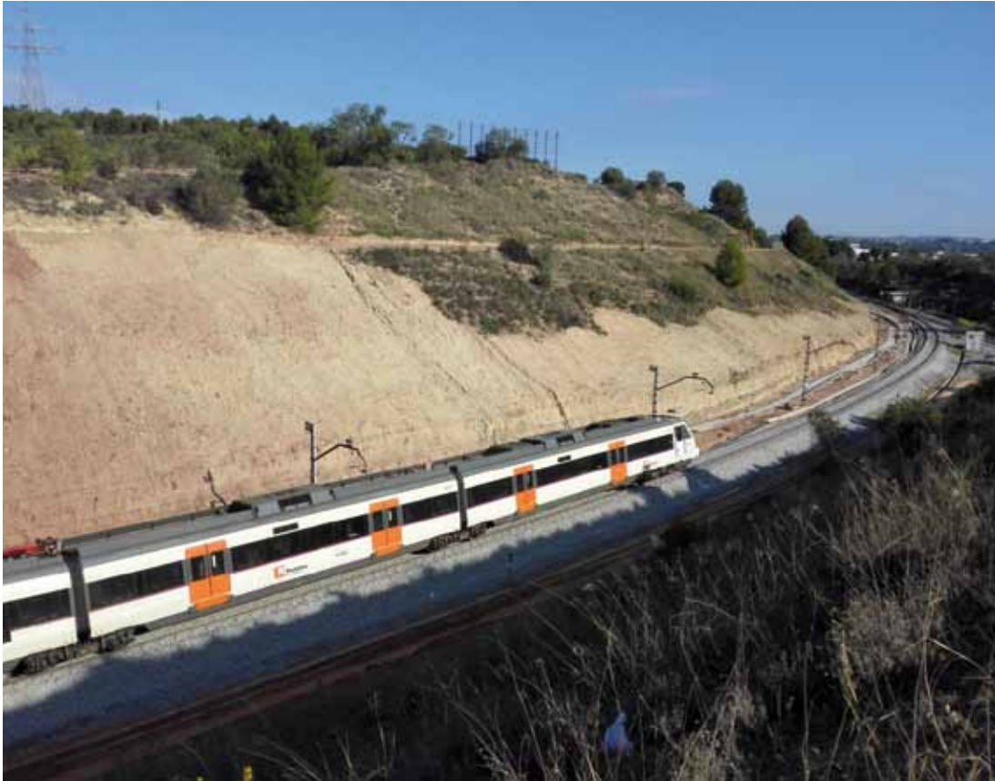
Fig. 1. Unidad de cercanías circulando por el tramo de pruebas en Castellbisbal
