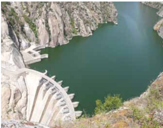
Fig. 12. Presa de Aldeadávila. Foto C.N.
