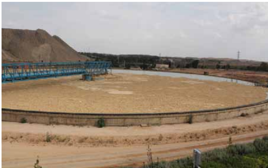
Instalaciones de Khouribga
