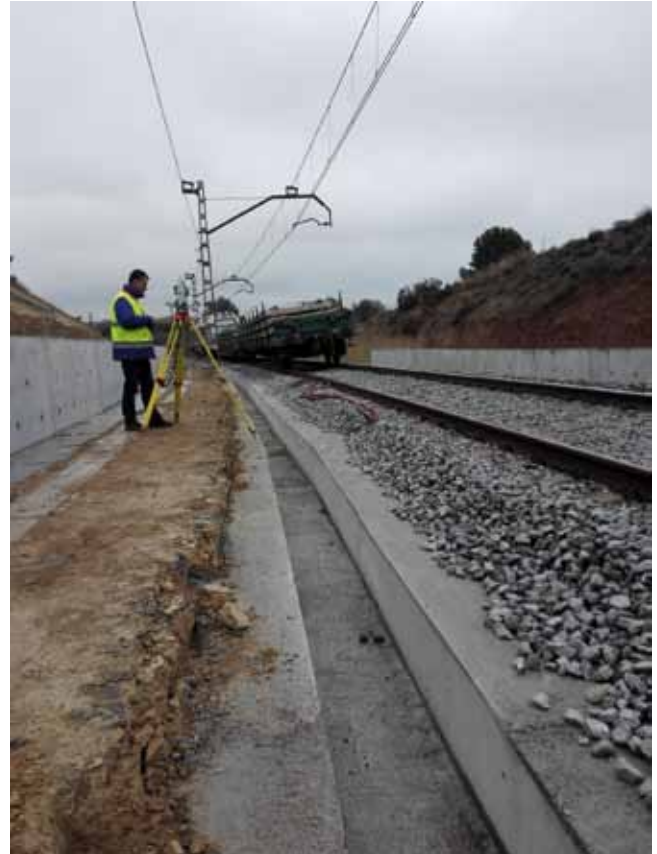
Fig. 2. Montaje de vía en el tramo de pruebas (imagen superior)
