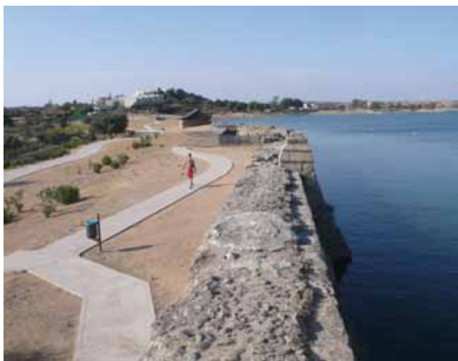
Fig. 10. Presa de Proserpina, con el entorno rehabilitado. Foto C.N.
