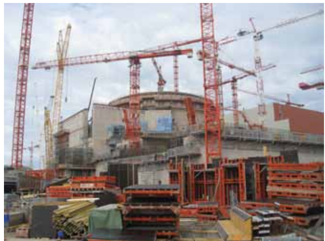
La central nuclear de Olkiluoto (Finlandia), actualmente en construcción
