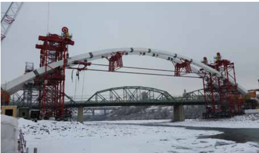
Posición final del ensamblaje del arco central
