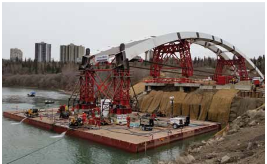
Transferencia de carga de skidshoes delanteros a pontona
