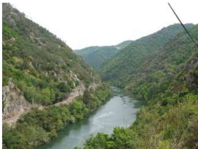
Fig. 19. Línea de ferrocarril de Monforte a Ourense por el Sil. Foto C.N.
