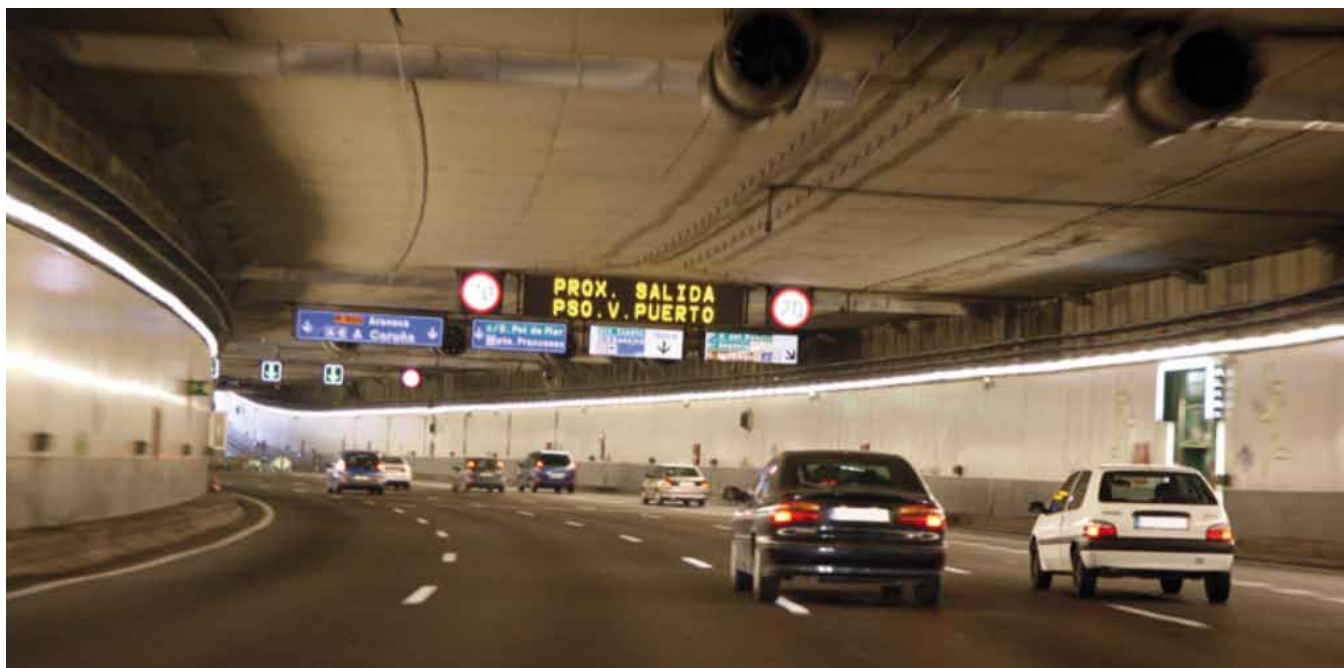
Túneles de la M-30
