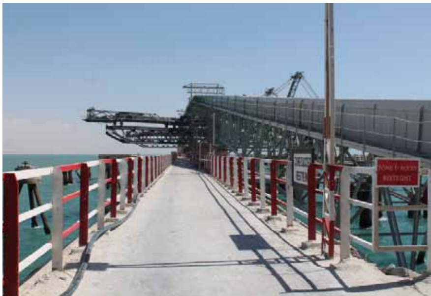
Instalaciones del actual puerto de Boucraa
