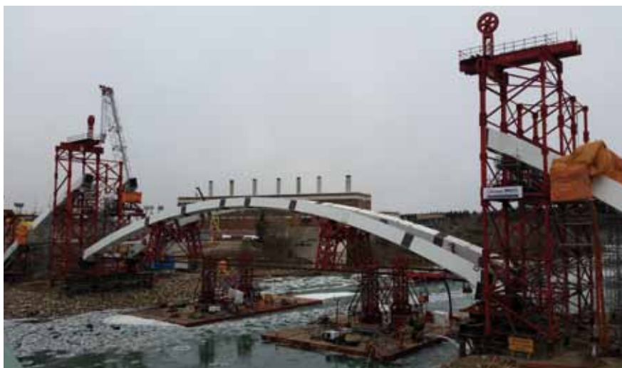
Retirada de pontonas tras apoyo del arco en apoyos temporales
