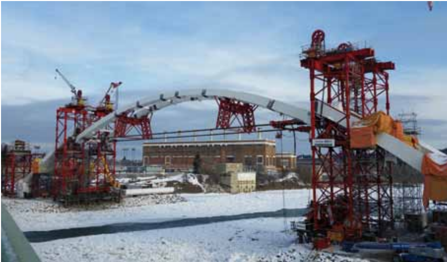
Manobra de izado de parte central
