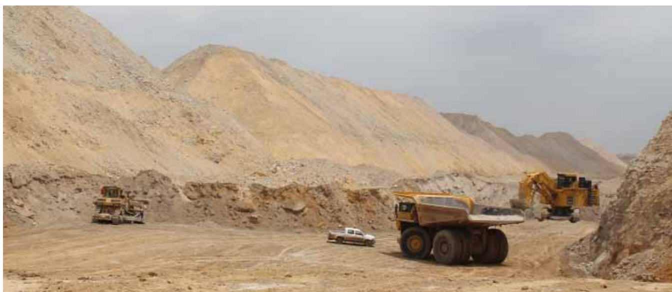
Trabajos en la explotación de fosfatos de Khouribga
