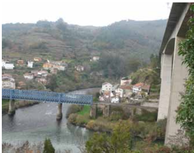
Fig. 8. Cruce de la carretera y el ferrocarril por Os Peares. Foto C.N.
