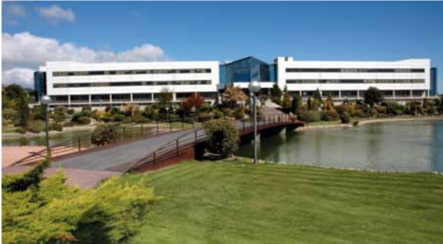
Vista exterior del edificio
