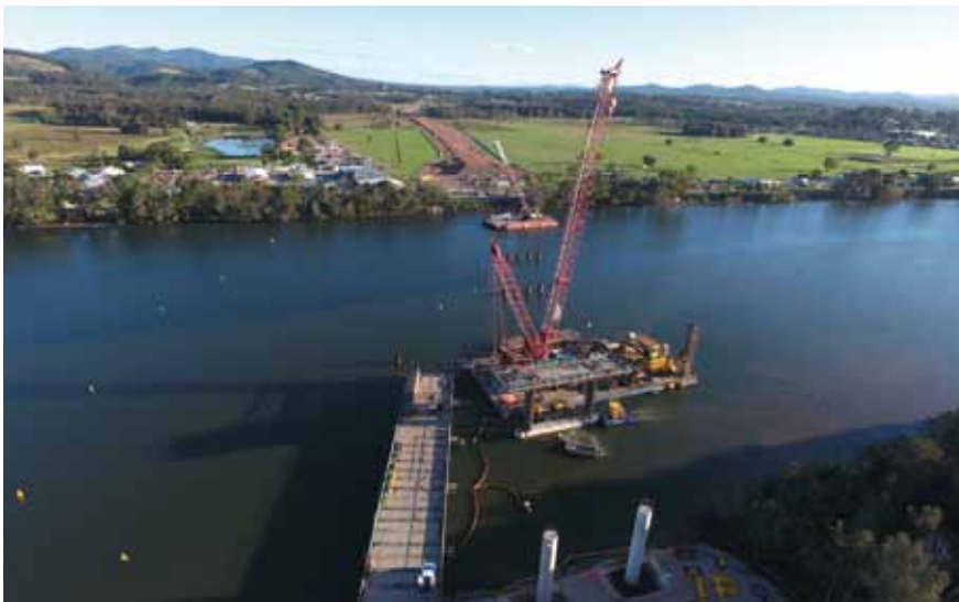
Pacific Highway (Ferrovial y Acciona)
