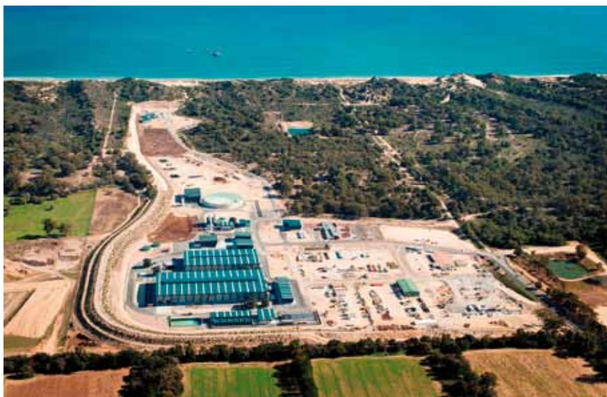
Desaladora de Perth (Sacyr)
