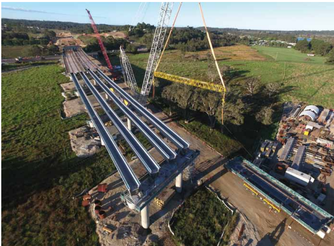
Pacific Highway (Ferrovia y Acciona)
