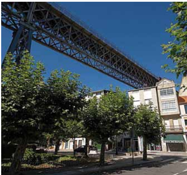
Viaducto de Redondela de celosía metálica
