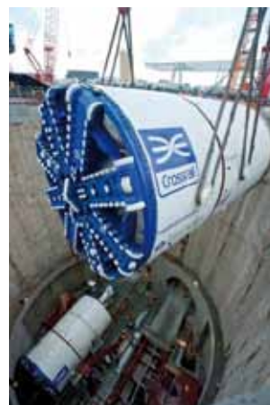
Fig. 5. Sistema de pozos y galerías en Limmo Peninsula (izda.). Descenso de tuneladoras en el pozo principal (dcha.)
