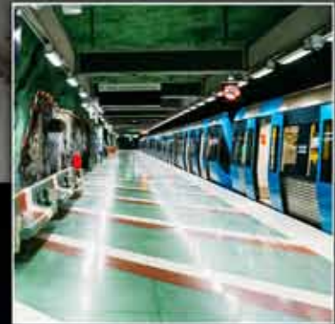
Metro de Estocolmo Planificación y diseño de 11 km de línea, con túnel en roca, bajo el mar de Saltsjön
