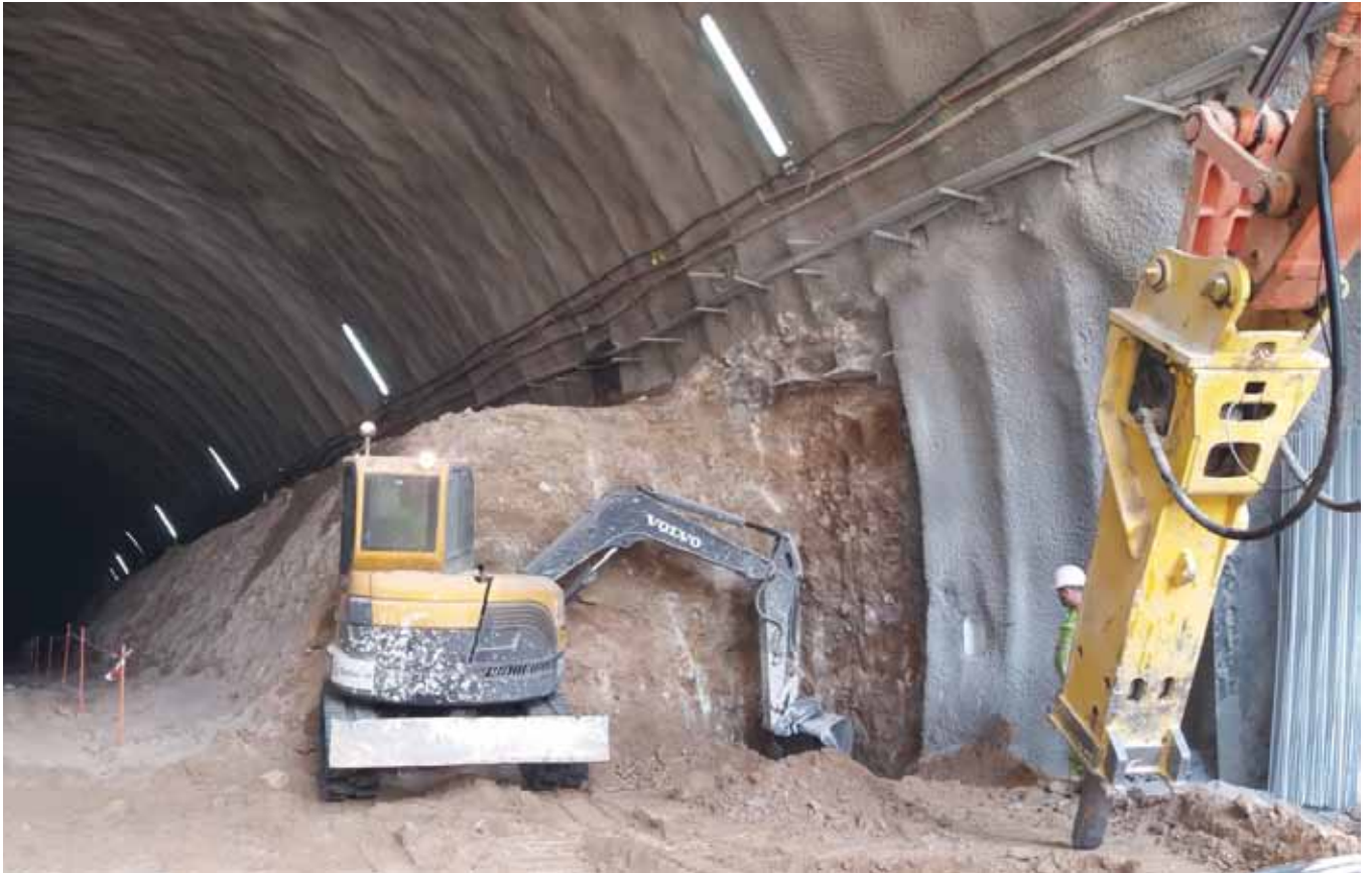
Fig. 10. Excavación de batache en la fase de destroza
