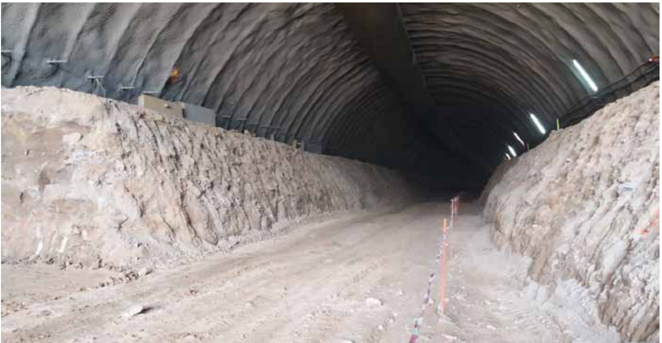
Fig. 9. Excavación de destroza central
