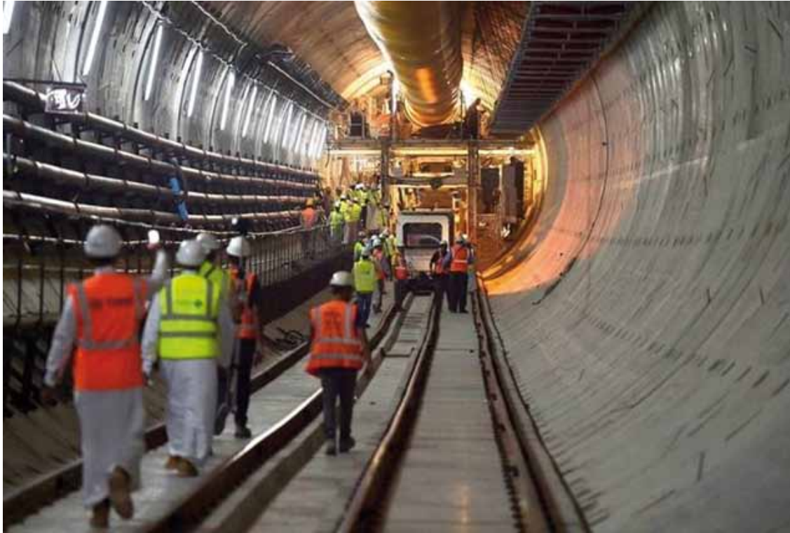
Fotografía 1. Túnel principal de línea 5 excavado con TBM
