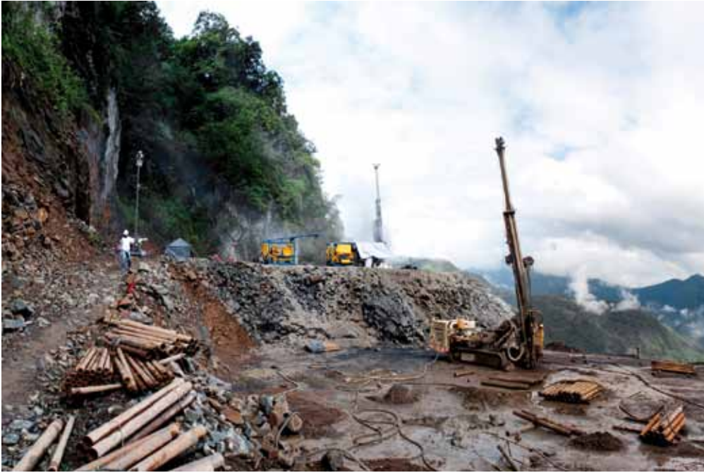
Fig. 28. Vista de la plataforma de inyecciones
