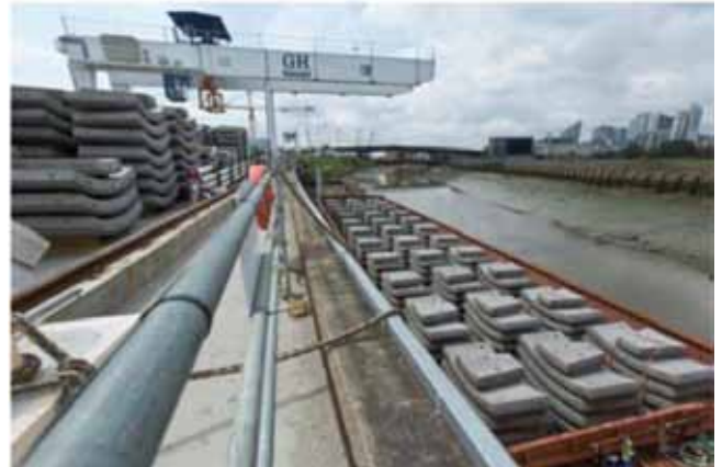
Fig. 3. Carga de material de excavación en barcazas por medio de cintas tipo tripper en Instone Wharf (izda.). Recepción de dovelas en Limmo suministradas mediante barcazas (dcha.).
