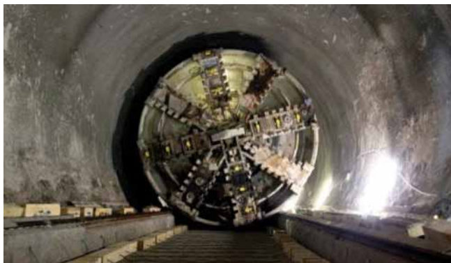
Fig. 10. Tránsito de la TBM del Drive Y por la estación de Whitechapel
