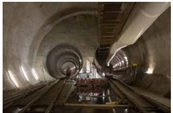
Fig. 9. Cale de la segunda TBM en Stepney Green (izda.) y vista de la caverna tras el paso de las máquinas (dcha.)
