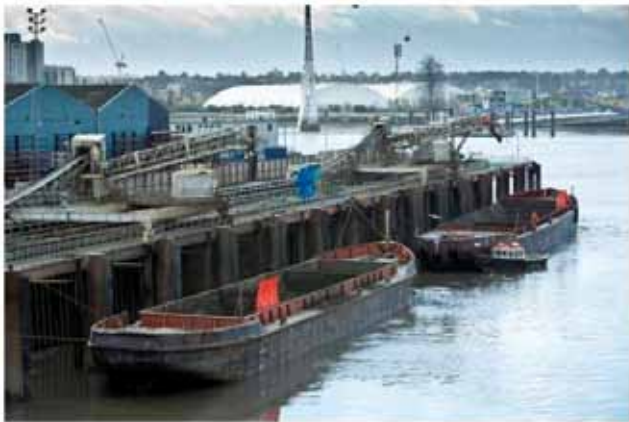
Fig. 3. Carga de material de excavación en barcazas por medio de cintas tipo tripper en Instone Wharf (izda.). Recepción de dovelas en Limmo suministradas mediante barcazas (dcha.).
