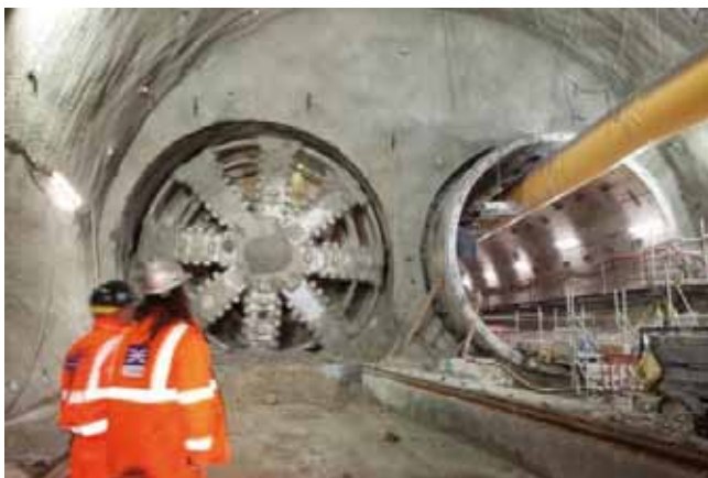
Fig. 9. Cale de la segunda TBM en Stepney Green (izda.) y vista de la caverna tras el paso de las máquinas (dcha.)
