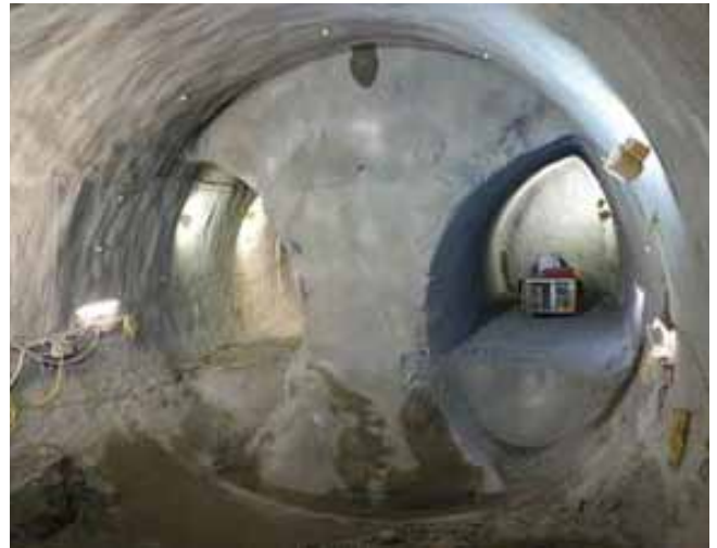
Fig. 17. Subdivisión del frente en dos fases (izda.) y subdivisión en tres fases para las secciones de mayor tamaño (dcha.)
