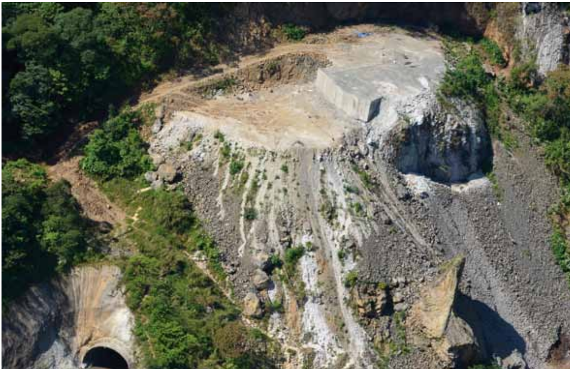
Fig. 32. Vista aérea de la plataforma posterior a la finalización de los trabajos de inyección
