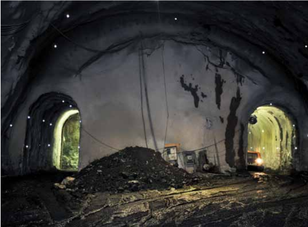
Fig. 33. Vista de las galerías laterales al inicio de su construcción
