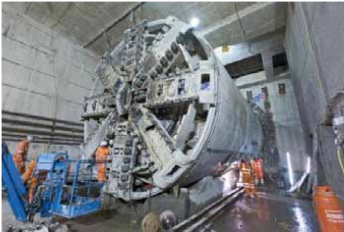
Fig. 8. Paso de tuneladora por la estación (izda.). Servidumbre a través de la estación para suministro de las tuneladoras tras el paso de la estación (dcha.)
