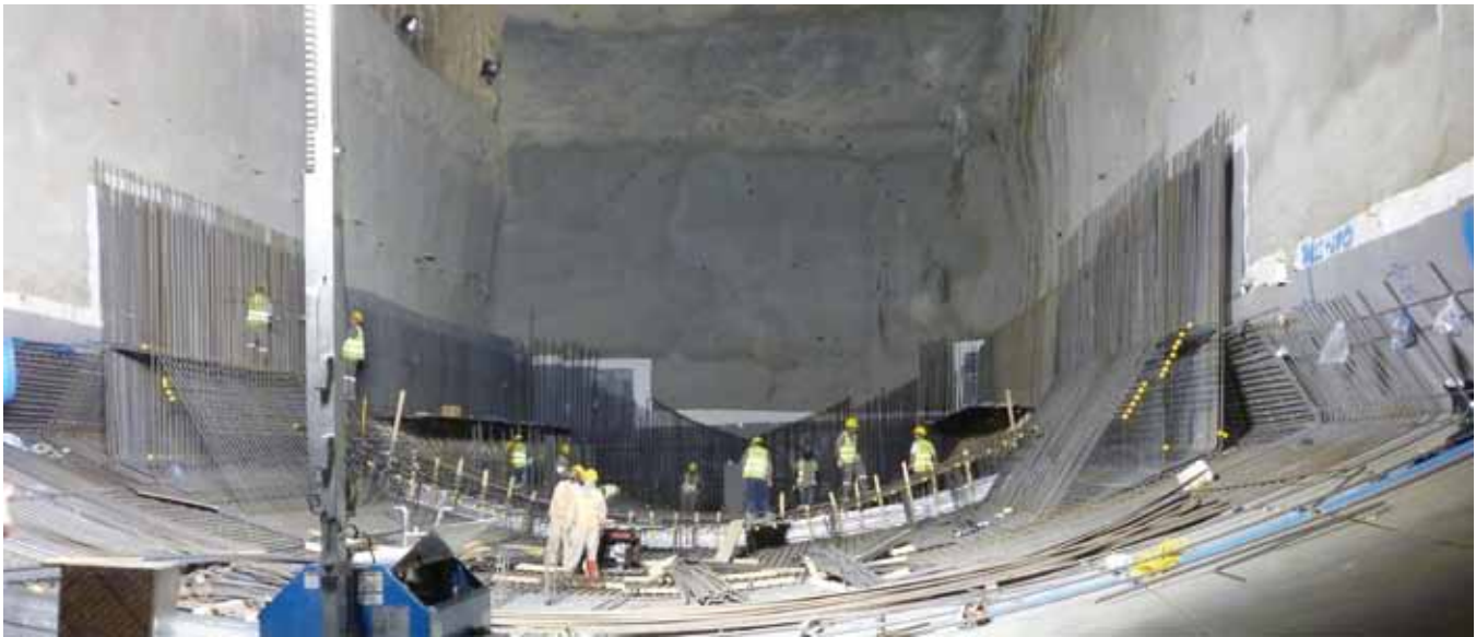
Fotografía 3. Contrabóveda en fase de construcción
