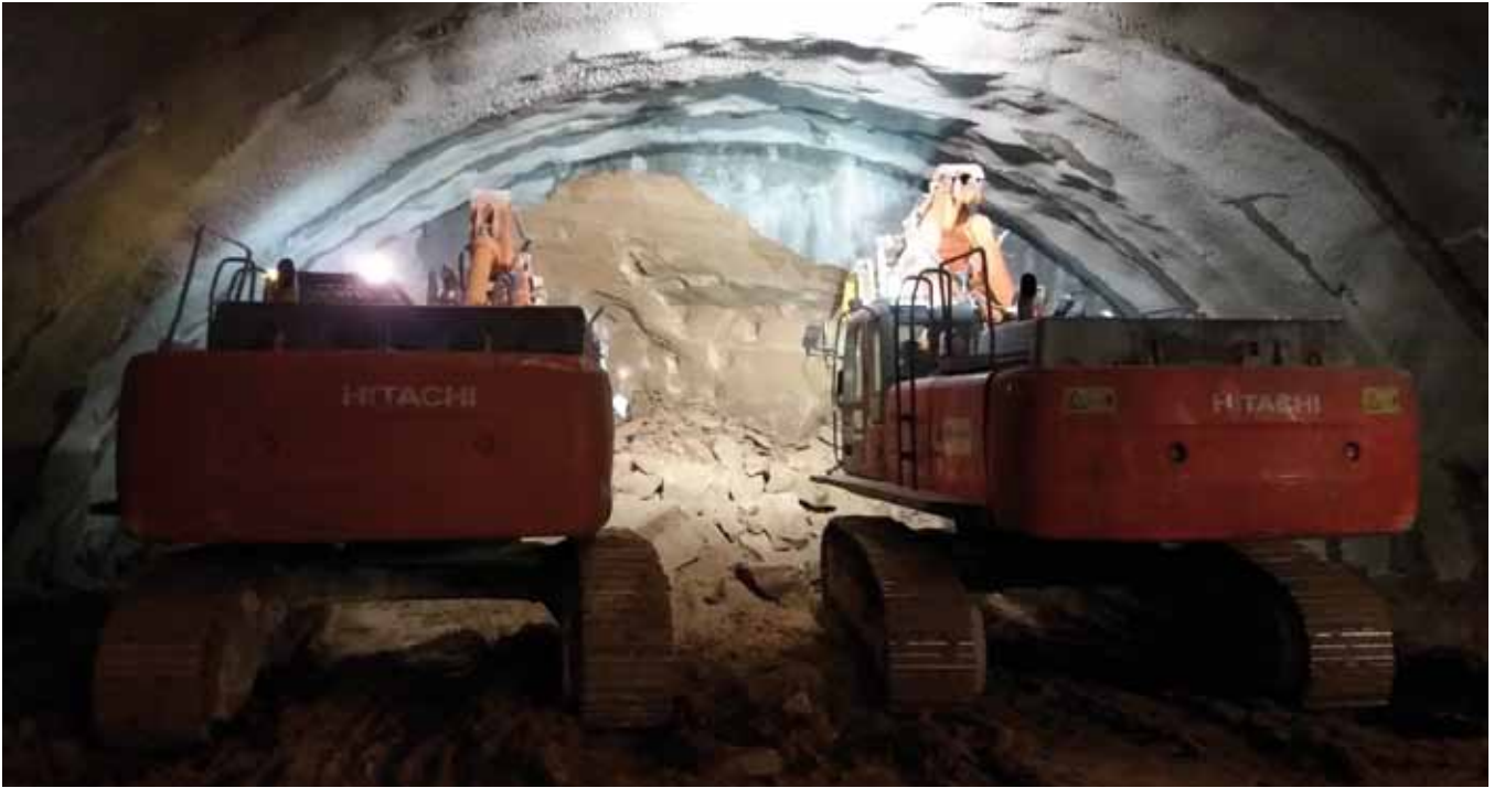
Fig. 8. Excavación en avance con dos martillos picadores
