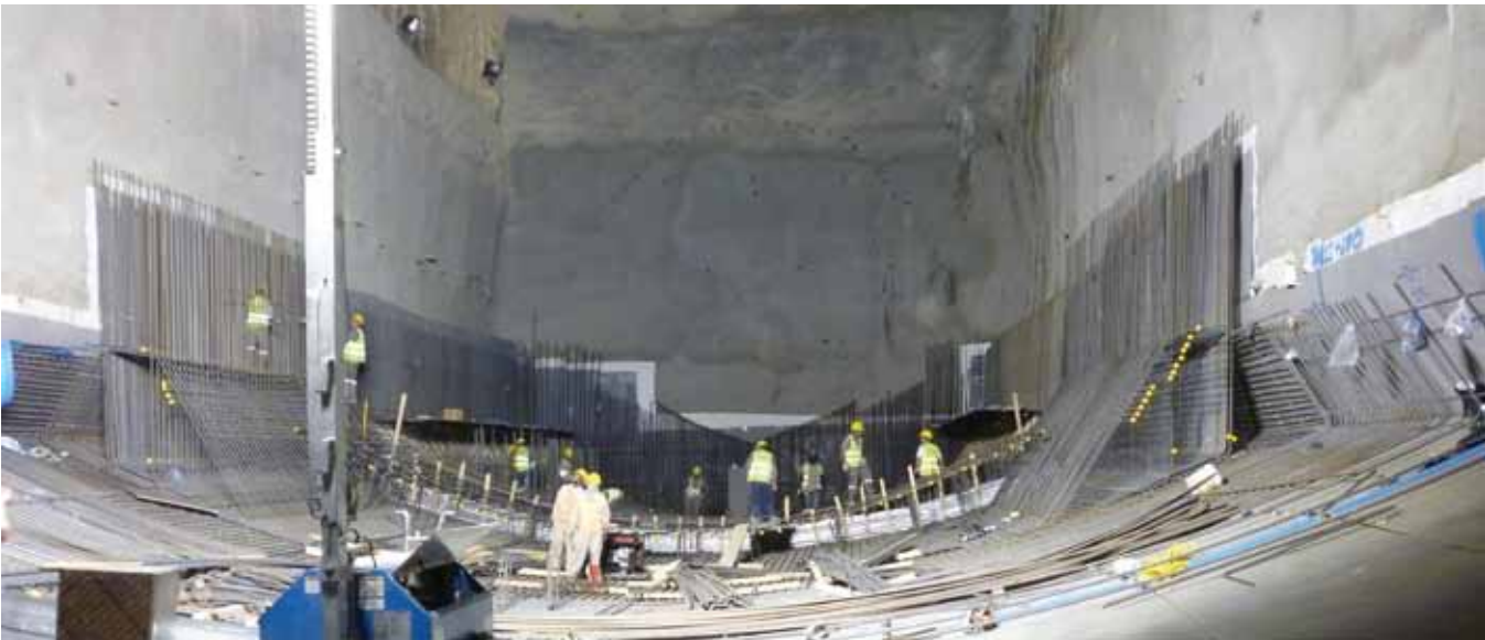
Fotografía 3. Contrabóveda en fase de construcción
