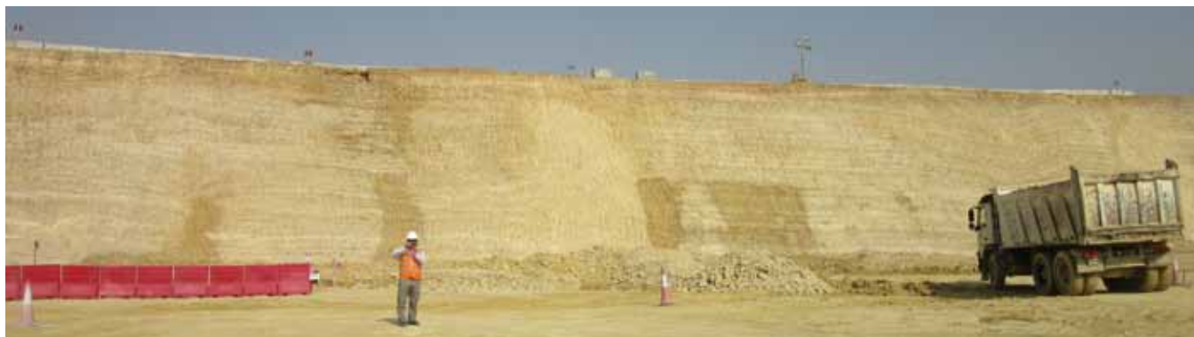
Fotografía 2. Excavación con fluencia de agua
