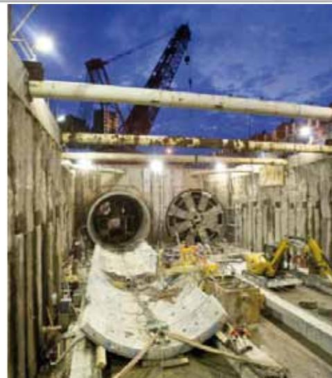
Fig. 13. Sección transversal de los túneles del Drive G en las proximidades del portal de Victoria Dock indicando los tratamientos del terreno (arriba) y recepción de tuneladoras en el portal (abajo)
