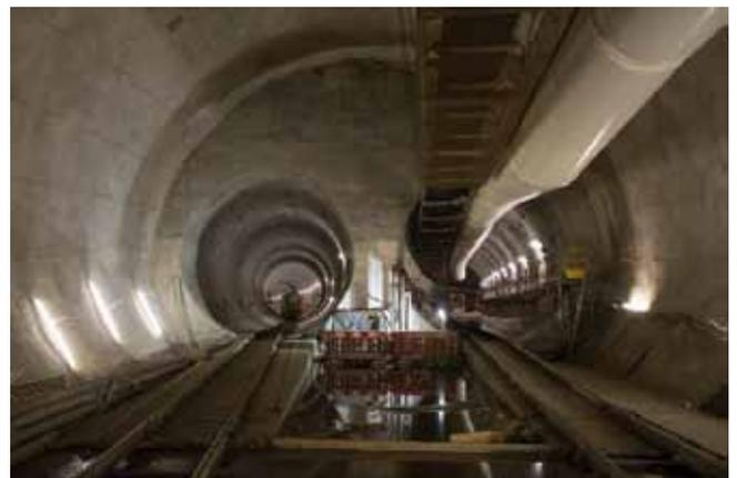
**Fig. 9. Cale de la segunda TBM en Stepney Green (izda.) y vista de la caverna tras el paso de las máquinas (dcha.)**
