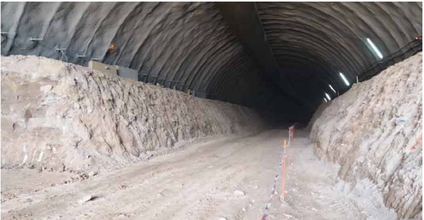
Fig. 9. Excavación de destroza central
