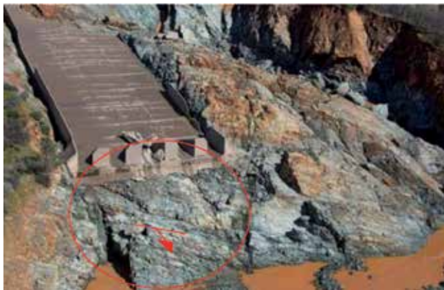
Fig. 5. Buzamiento de la serie esquistosa en la zona del aliviadero
