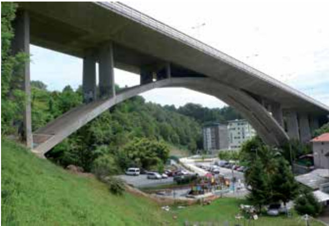
Fig. 21. Viaducto de Morlans en San Sebastián. Foto C. N.
