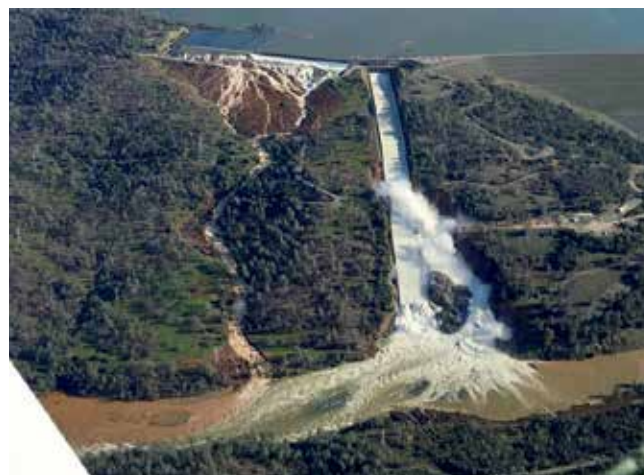
Fig. 9. Vertido simultáneo por el aliviadero de emergencia y el aliviadero principal. 12/02/2017
