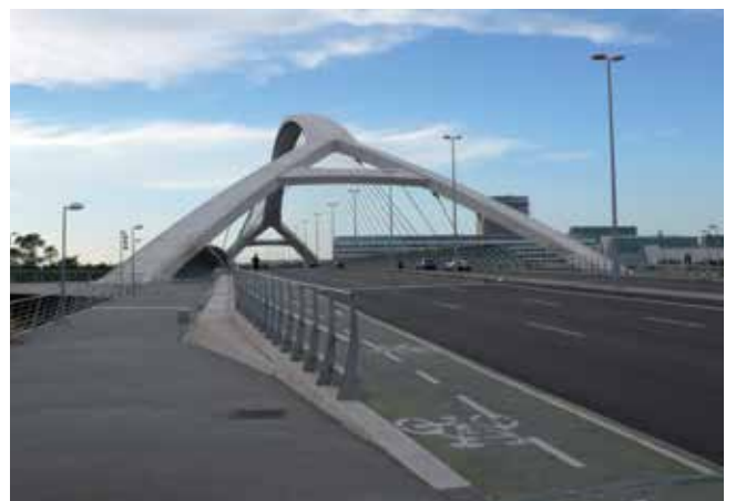
Fig. 26. Puente del III Milenio en Zaragoza. Foto C. N.
