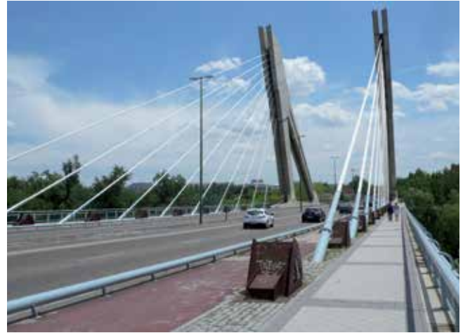
Fig. 19. Puente sobre el Pisuerga en Valladolid. Foto C. N.
