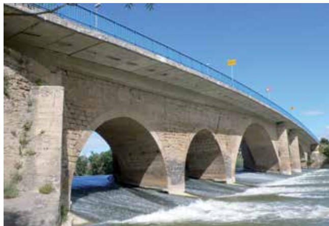
Fig. 9. Ensanche del puente de Berbinzana. Foto C. N.
