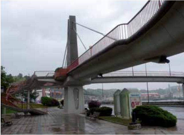
Fig. 14. Pasarela de Astrudubia en Bilbao. Foto C. N.
