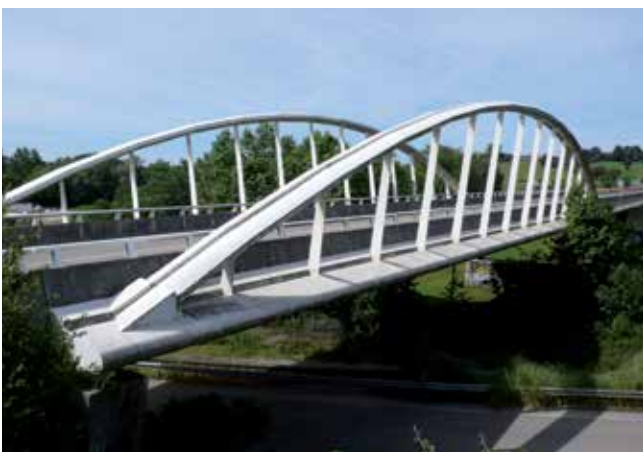
Fig. 25. Puente de la carretera de Villaverde de Pontones. Foto C. N.
