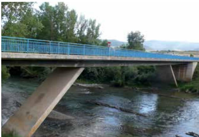
Fig. 8. Puente sobre el río Iraki en Lumbier (Navarra). Foto C. N.
