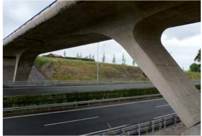
Fig. 30. Paso Superior de la Autovía del Cantábrico próxima a Torrelavega. Foto C. N.
