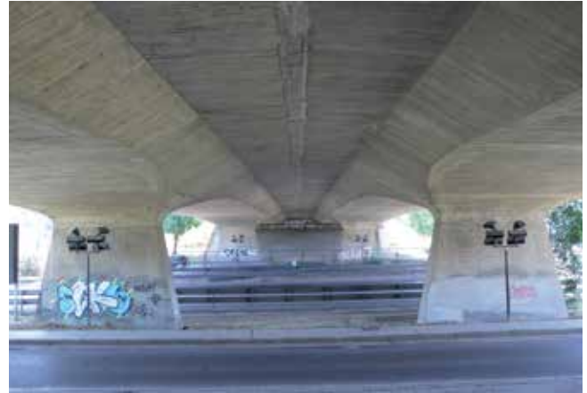
Fig. 11. Paso elevado de la Avenida de los Pirineos en Zaragoza. Foto C. N.
