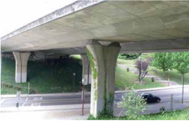
Fig. 10. Paso elevado de Fuente de Hierro. Variante oeste de Pamplona. Foto C. N.
