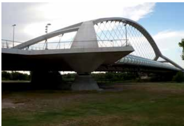
Fig. 27. Piezas de los apoyos del tablero del Puente del III Milenio. Foto C. N.
