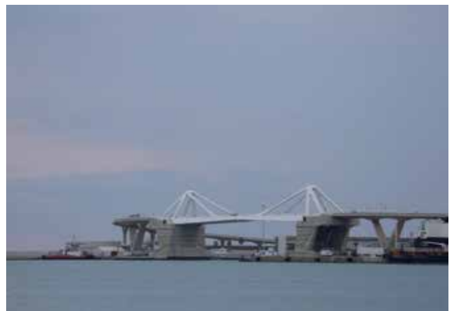
Fig. 24. El puente móvil en el puente de Barcelona. Foto C. N.
