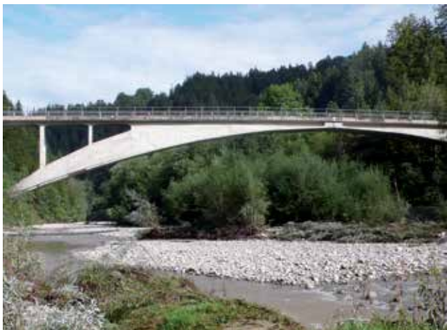
Fig. 2. Puente de Rossgraben de Maillart. Foto C. N.
