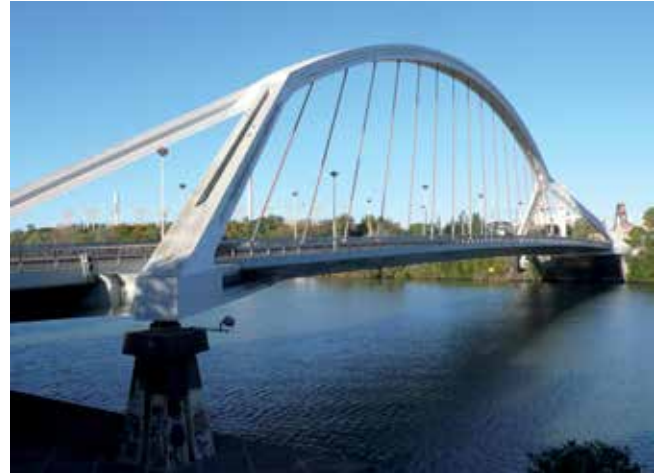
Fig. 15. Puente de la Barqueta en Sevilla. Foto C. N.
