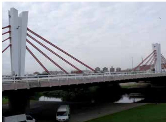
Fig. 17. Puente de la Calle Potosí en Barcelona. Foto C. N.
