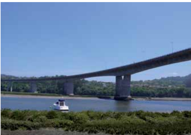
Fig. 23. Viaducto sobre la ría del Pedrido. Foto C. N.
