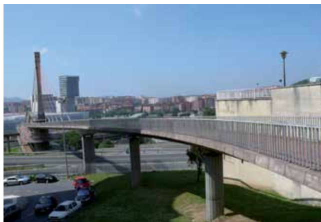
Fig. 13. Pasarela de Cruces en Bilbao. Foto C. N.
