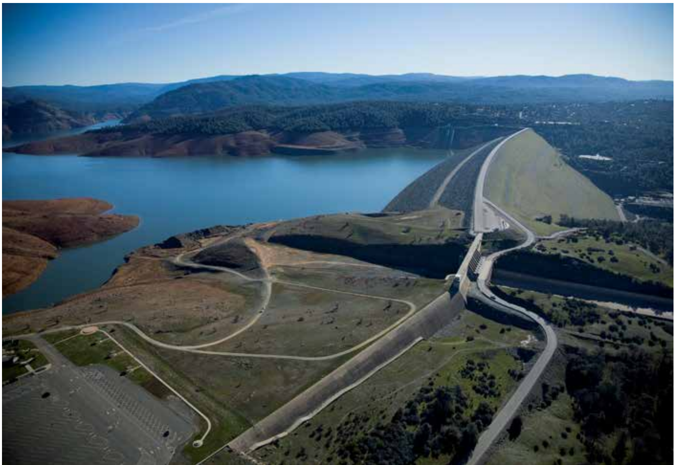
Fig. 1. Vista aérea de la presa de Oroville. En la parte inferior de la imagen se aprecia el aliviadero de emergencia (en primer término) y el aliviadero principal
