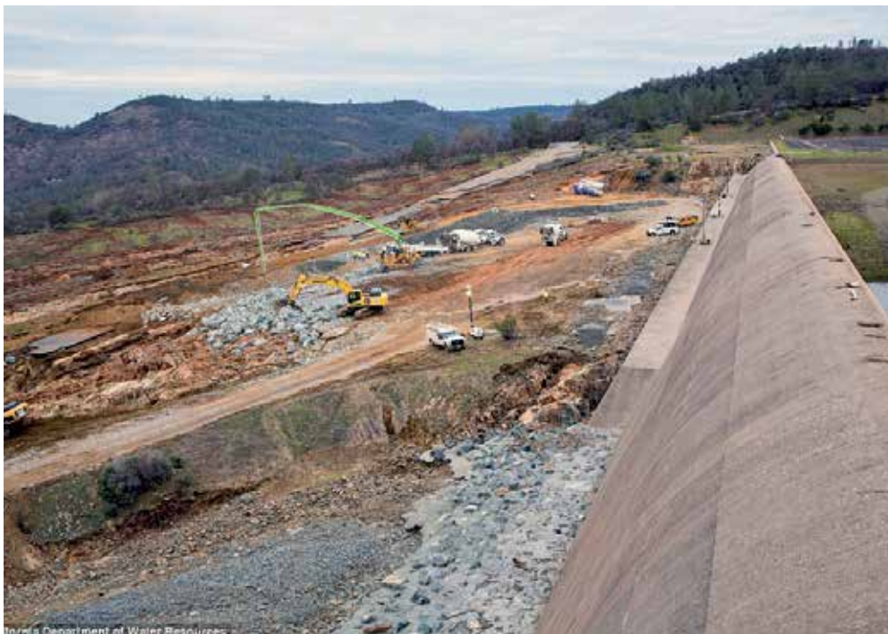
Fig. 10. Trabajos de reparación en el aliviadero de emergencia
