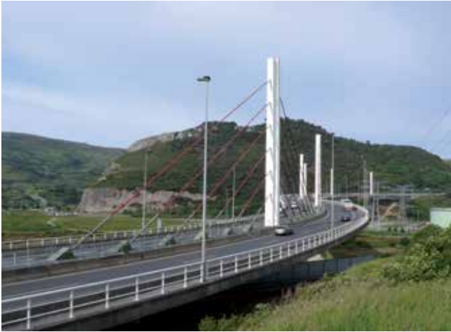
Fig. 18. Viaducto de las Arenas en la Autovía del Cantábrico. Foto C. N.
