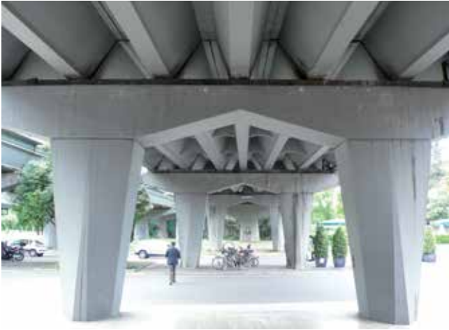
Fig. 4. Viaducto Corso Francia en Roma. Foto C. N.
