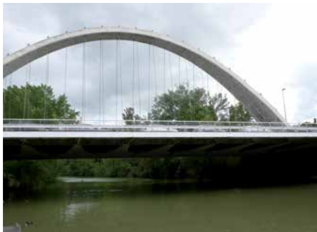
Fig. 16. Puente de las Oblatas en Pamplona. Foto C. N.
