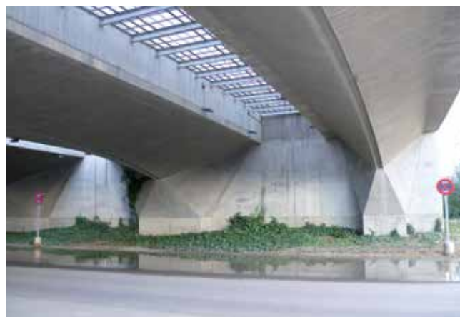
Fig. 28. Bóvedas de acceso al Parque de la Expo de Zaragoza. Foto C. N.
