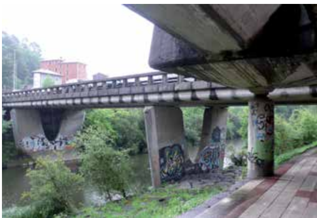
Fig. 12. Intradós de la pasarela y puente de Arrigorriaga en Bilbao. Foto C. N.
