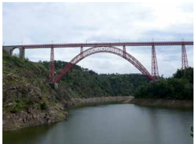
Fig. 1. Puente de Garabit. Foto C. N.
