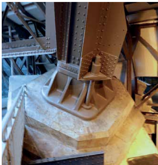
Detalle de una de las patas sobre las que se asienta la Torre
