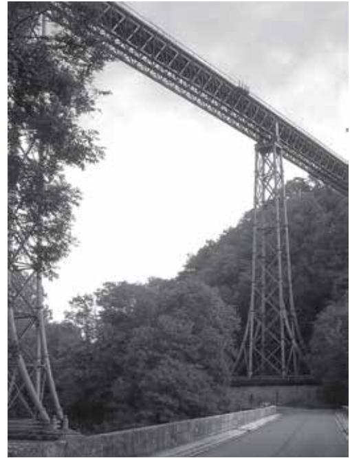
Viaducto de Neuviat sur la Sioule (Proyecto: Nordling; Constructor: Eiffel, 1869)
