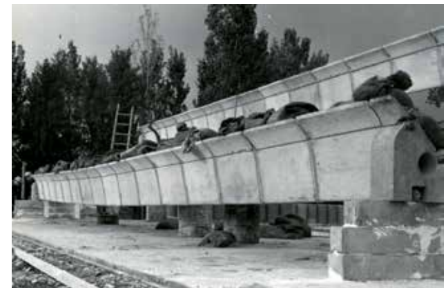
Fig. 5. Fisac en el parque de dovelas de las vigas hueso y la prueba de carga de una de ellas (en cehopu.cedex.es)
