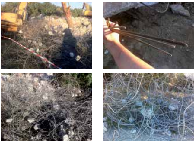
Fig. 16. Alambres de las vigas y la losa
