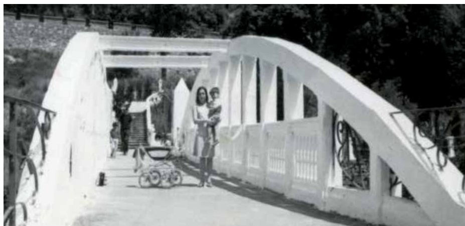
Fig. 25. Puente de Sobrón en aguas del Ebro, mostrando sus protecciones y barandillas en hierro forjado estilo modernista (ver en Ref. artículos de prensa)
