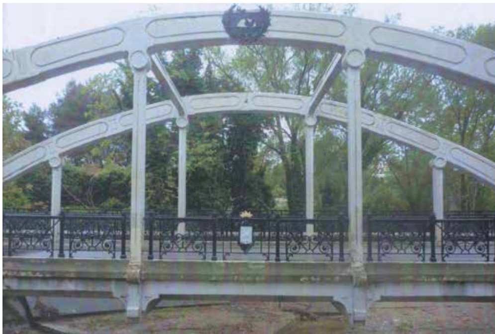
Fig. 23. Admirado por su bella perspectiva modernista, y sus 'trapecios' de péndolas y traviesas, colgados de los arcos, y la 'cadena de eslabones' dibujados en ellos. La foto del autor presenta el Puente San Miguel, con el punto de fuga coincidente con la corona del escudo de la Ciudad, bajo el bulón de la articulación de la clave
