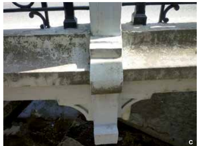
Fig. 16. A. Arista Biselada que dejan libre el espacio del aplique metálico reforzando su estética; B. Nudo de Péndola empotrada en la 'traviesa', al que acometen dos tramos del larguero de borde, con escuadras; C. Nudo de Riostra, que recibe al 'arco' en el punto de cuelgue de las cabezas cilíndricas de las péndolas centrales
