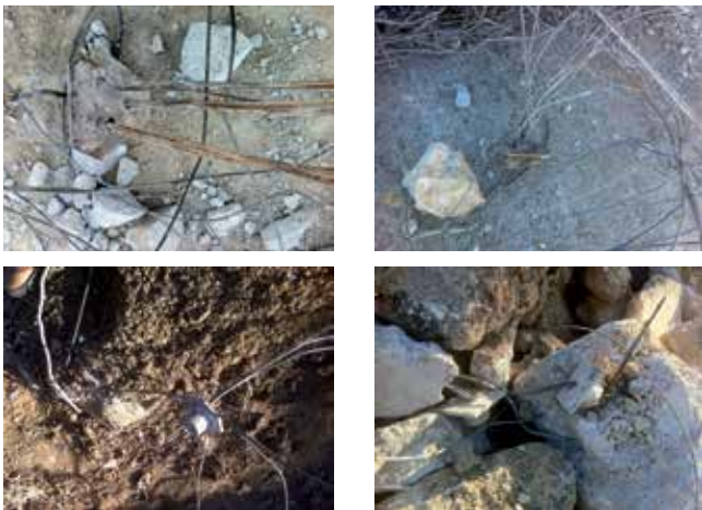
Fig. 17. Dispositivos de anclaje de vigas y losa
