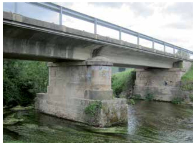
Fig. 26. Puente de la carretera M-625 sobre el río Guadalix, en Guadalix de la Sierra; un ejemplo canónico de la tipología de tramo recto de la colección Zafra
