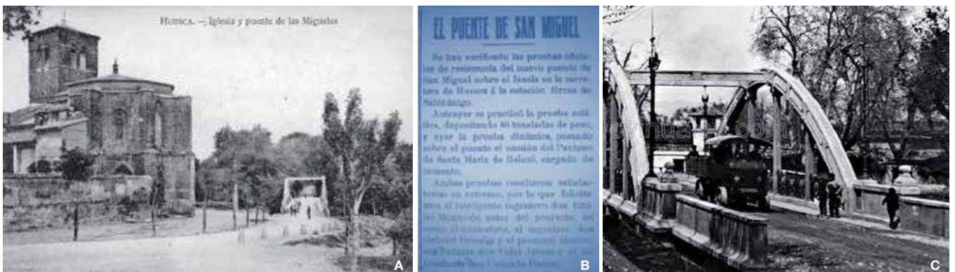
Fig. 14. A. Postal antigua del Puente San Miguel, que aparece claramente tangente al ábside; B. Reseña de prensa de la Recepción Oficial, 1913, que explica las 'pruebas estáticas' efectuadas con cargas de 80 Tm; C. 'Prueba dinámica' al paso de un vehículo, en la entrega de la Obra (Fototeca DPHu).
