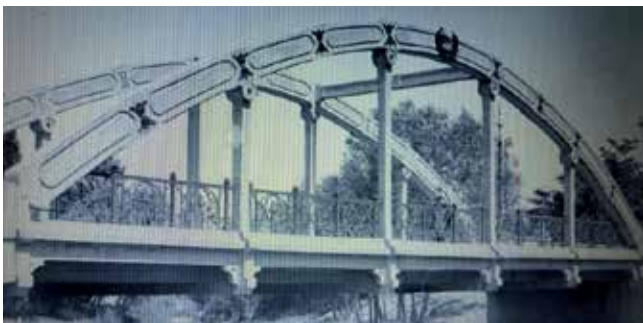
Figura 22. Imágenes antiguas mostrando la ornamentación modernista. Algunos elementos decorativos permanecieron intactos en el puente San Miguel. Bella 'Postal de 1925', que conserva limpiamente los invariantes del estilo, y recalca el diseño mecánico de adaptación de cada pieza, a su trabajo estructural (Fototeca DP)
