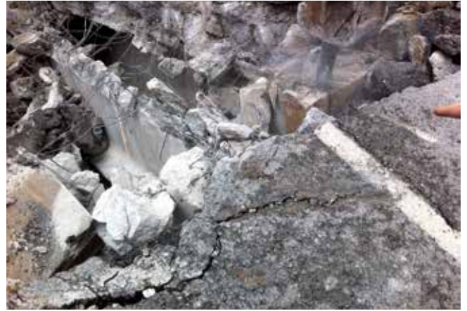
Fig. 15. Demolición del puente, el 15 de junio de 2015
