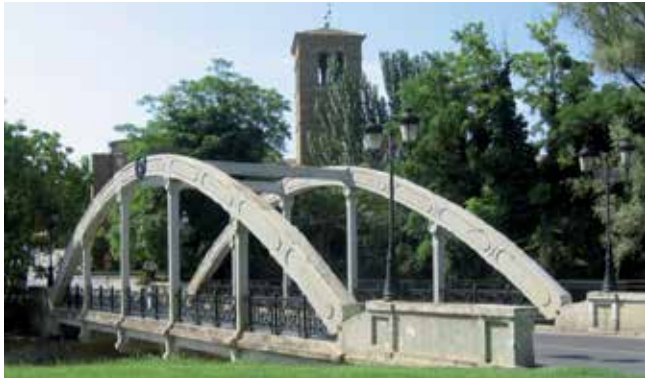
Fig. 1. El Puente 'Nuevo', junto al Monasterio* armoniza su elegante estructura en hormigón armado antepuesto a la sillería de arenisca, su estilo modernista en contrapunto al histórico románico de la torre y gótico del ábside, acordando la técnica constructiva de la triarticulación con el tangible contrafuerte
