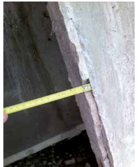
Fig. 13. La rotura de la viga de borde: detalles del modo de rotura, la corrosión de los alambres y la junta de 14 mm de mortero de "supercemento"
