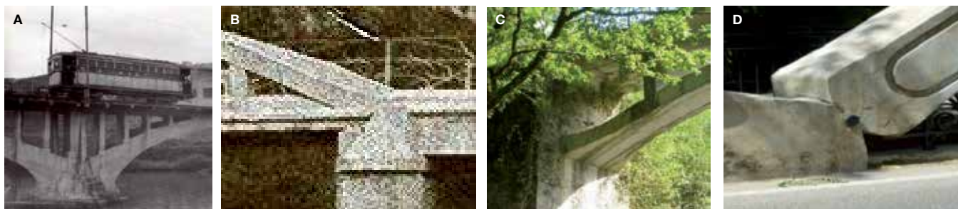
Fig. 3. Imágenes de los diferentes apoyos del arco: A. Simple; B. Atirantado –bowstring–; C. Empotrado; D. Articulado
