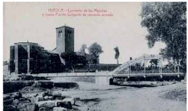
Fig. 2. Tarjeta postal h. 1914. El Convento bajo la muralla árabe que rodea la ciudad y el Puente. Despejados de vegetación, salvo algún árbol, y con las farolas-candelabro emborradas, fue una imagen muy difundida, que en su información recalca el funcionamiento estructural de sus péndolas, y el nuevo material de construcción. El título de las ediciones primitiva: HUESCA. -Convento de las Migueles y nuevo Puente Colgante de cemento armado. (Ejemplar propiedad del autor).
