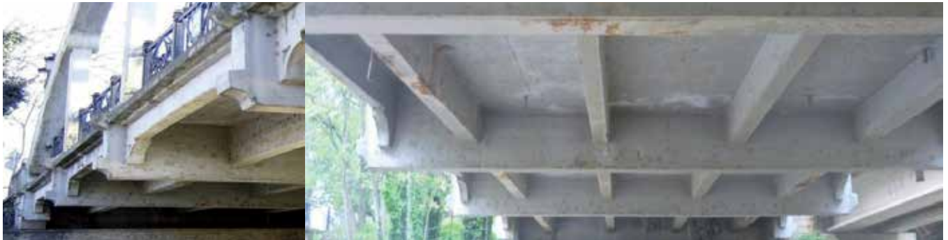
Fig. 17. Entramado que constituye la losa del tablero, con las ‘falsas traviesas’ recortadas en las ménsulas, apreciándose también el óxido de las platabandas pegadas posteriormente para reforzaron las vigas
