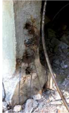
Fig. 19. La corrosión había seccionado una gran parte de los alambres de la viga de borde, pero en las vigas interiores apenas había señales de corrosión
