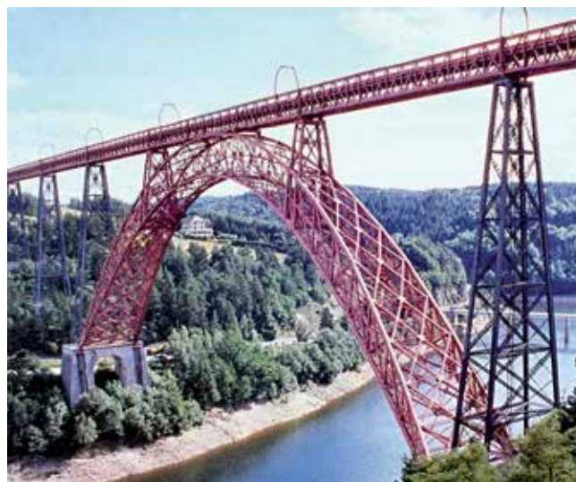
Viaducto de Garabit (Eiffel, 1884. 165 m de luz, 120 m altura)
