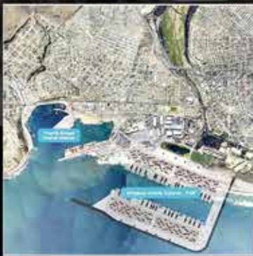
Puerto de San Antonio, Chile Ingeniería para el desarrollo de un puerto de gran escala con nueva dársena para terminal de contenedores
