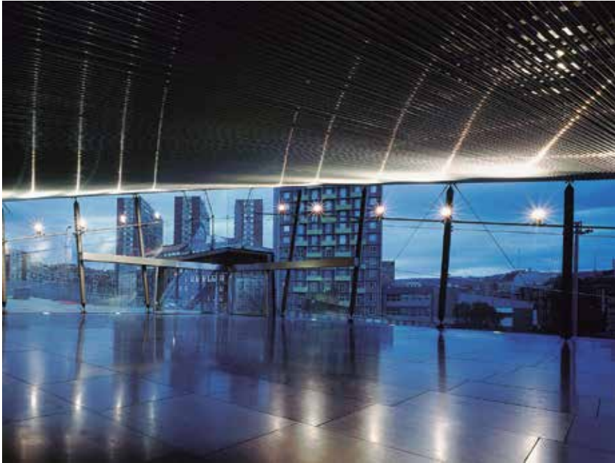
La estación de Ametzola, de Renfe y Feve, es uno de los principales elementos de la Variante Sur Ferroviaria
