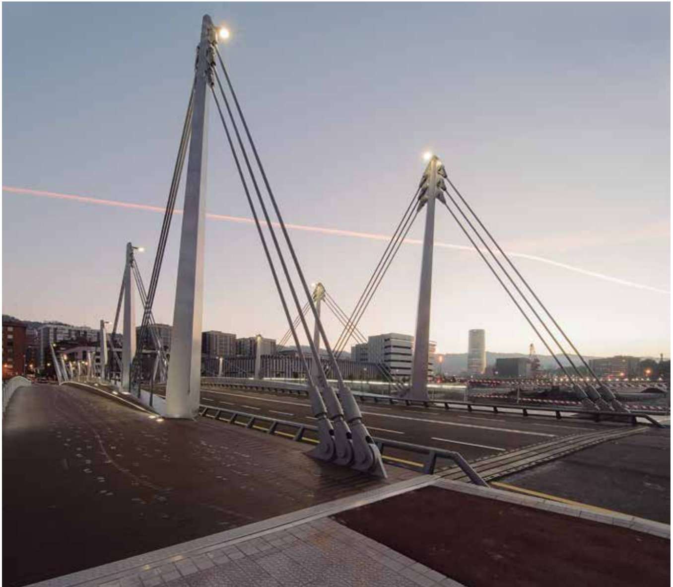
El puente se basa en una solución atípica de viga en celosía, una variante invertida de la viga tipo Fink clásica
