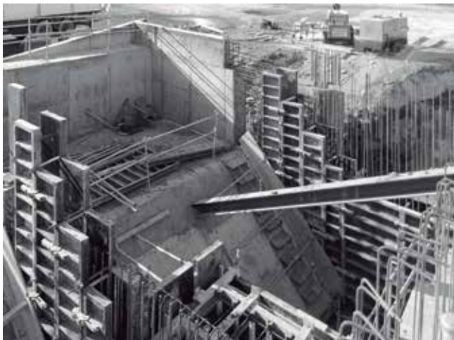
El puente en fase de construcción
