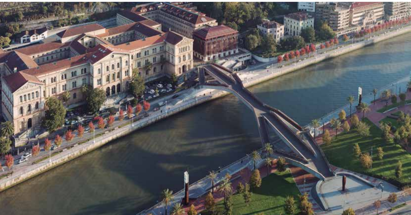
Vista aérea completa del puente
