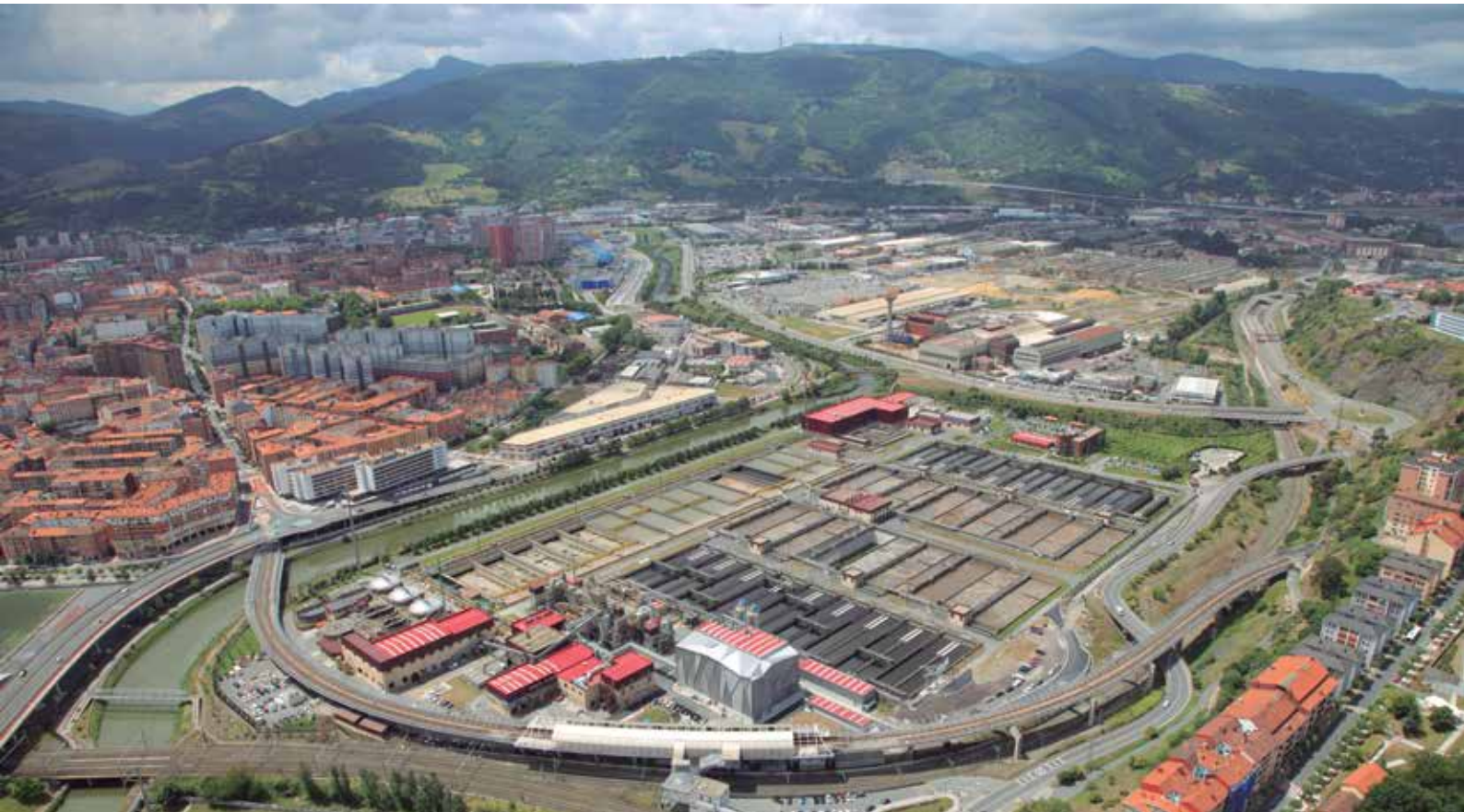
Vista de la EDAR de Galindo, obra financiada por el Estado.
