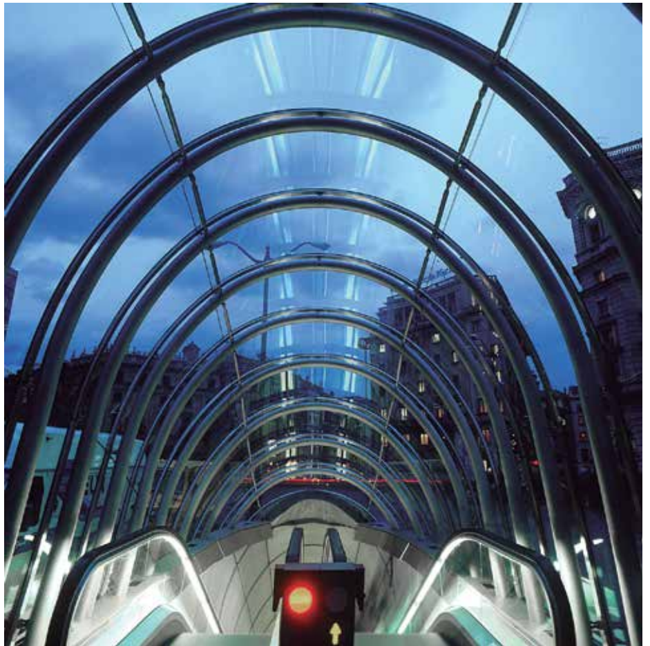
El “fosterito” es el cañón interior que se hace transparente al llegar a la superficie (AO)
