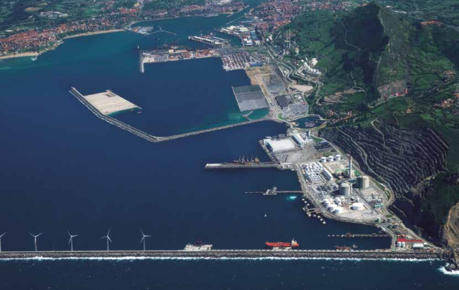
Vista general de la ampliación del Puerto
