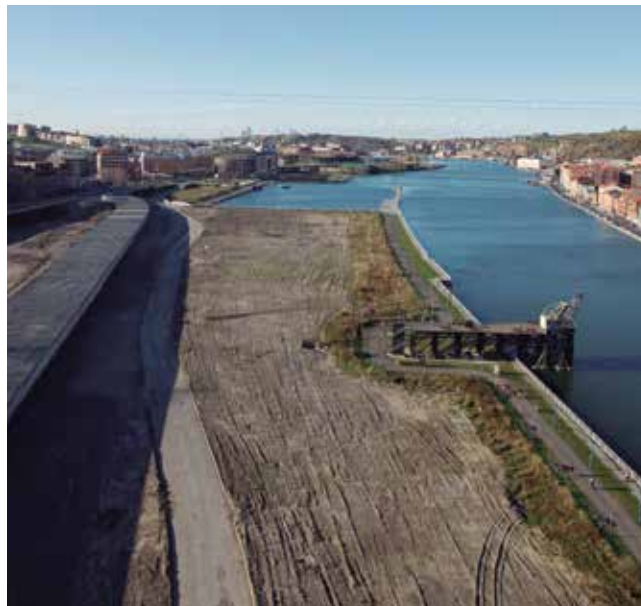
La cesión, por parte de la Diputación, de los suelos que pertenecieron a Altos Hornos de Vizcaya a Bilbao Ría 2000 posibilitó la actuación Urban-Galindo. Aitor Ortiz
