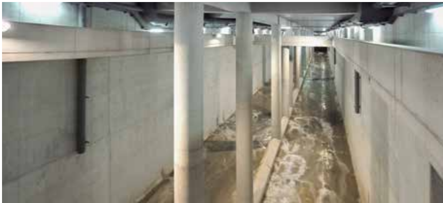
Tanque de tormenta de Etxebarri (70.000 m 3 )
