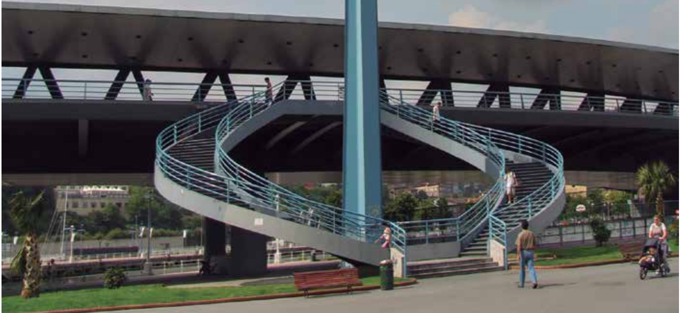
El mástil de 40 metros de altura fue uno de los elementos de diseño, junto con la “escalera imperial”
