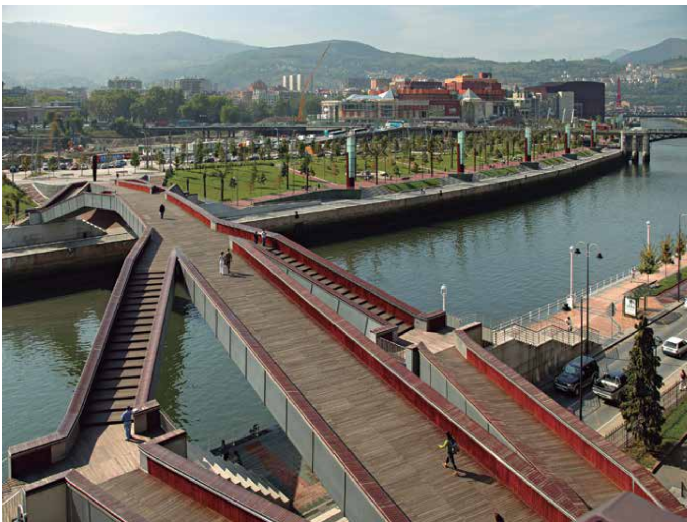
El acero inoxidable y la madera son los elementos distintivos de la pasarela. Foto cedida por IDEAM)
