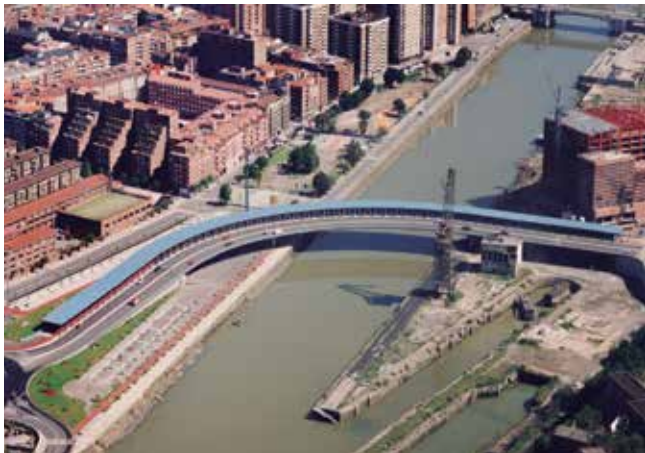
Vista aérea completa del puente
