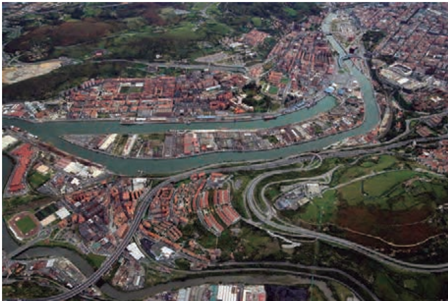
A finales de los años 50, el Puerto acometió la apertura del Canal de Deusto, que se inauguró en 1968. Zorrotzaurre en 2005, justo antes de que el Puerto abandonara sus instalaciones.
