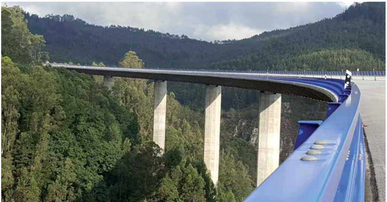
Fig. 1. Viaducto del Regueirón (Asturias)
