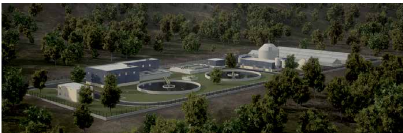
Planta de aguas residuales de la ciudad de Ibarra
