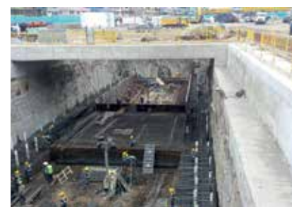
Construcción del metro de Quito
