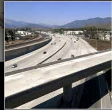
Autopista I-15 en Riverside, California Proyecto de ejecución de carriles "express lanes" para vehículos de alta ocupación (VAO)
