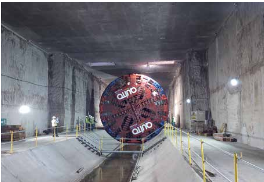
Construcción del metro de Quito
