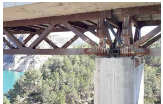
Fig. 3. Viaducto de Contreras (Valencia)
