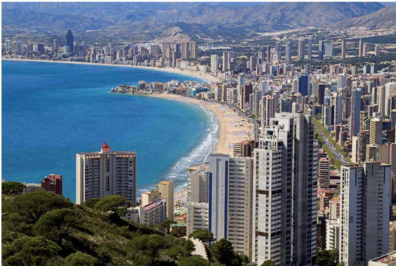
Ejemplo del proceso urbanizador sobre la costa española. Vista panorámica de la playa de Benidorm (Alicante)
