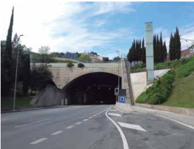
Fig. 7. Túnel de Valdevidrera. Foto C. N.
