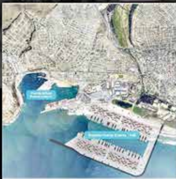
Puerto de San Antonio, Chile Ingeniería para el desarrollo de un puerto de gran escala con nueva dársena para terminal de contenedores
