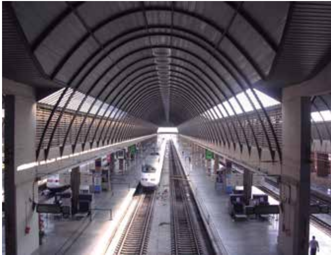
Fig. 12. Andenes de la Estación de Santa Justa. Foto C. N.
