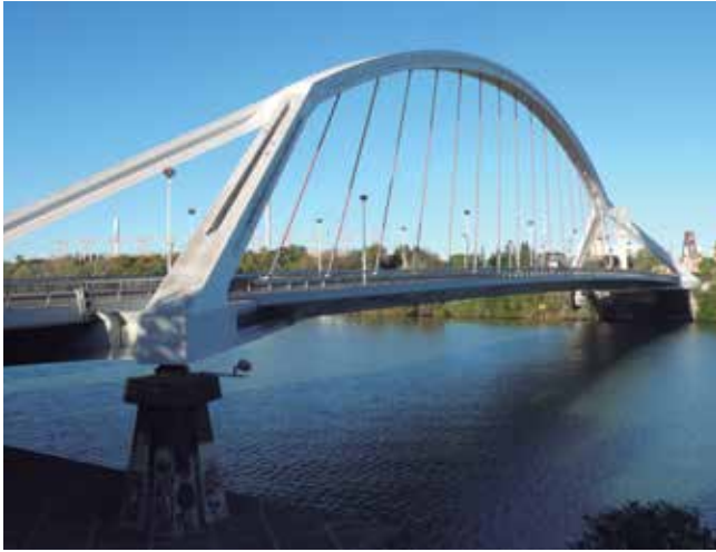
Fig. 15. Puente de la Barqueta, de Juan José Arenas. Foto C. N.
