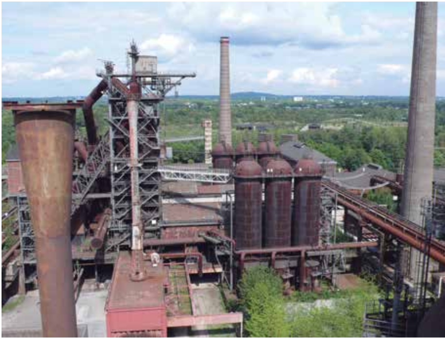
Fábrica y parque en Diusburg-Nord. Foto C. N.
