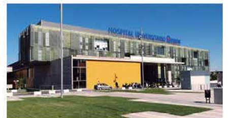
Hospital Quirón, Pozuelo de Alarcón
