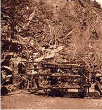
Fig. 19. Perforaciones con "jumbo" en el Túnel de La Argentina
