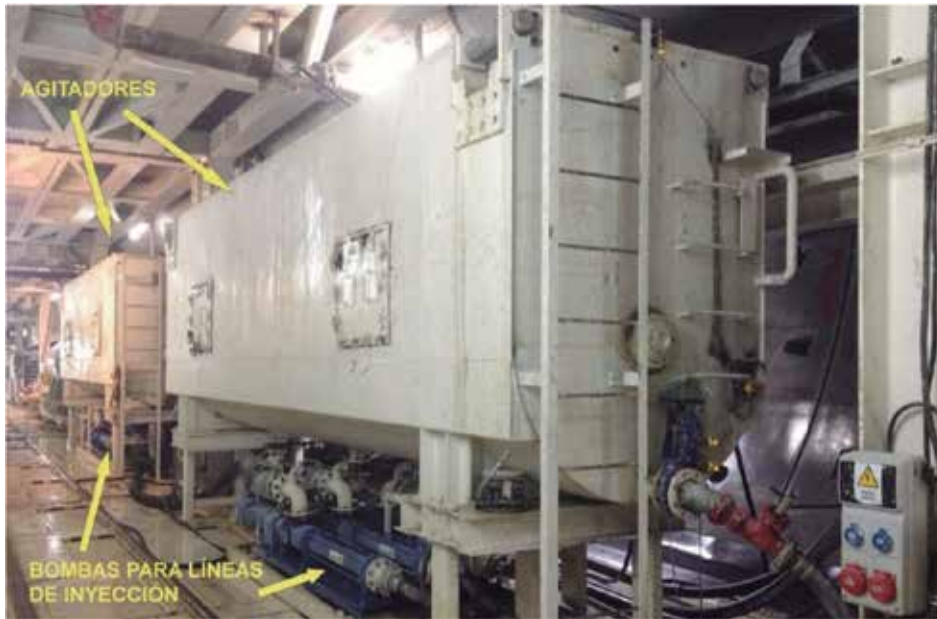
Fig. 11. Depósitos de Comp A en el back-up de la TBM
