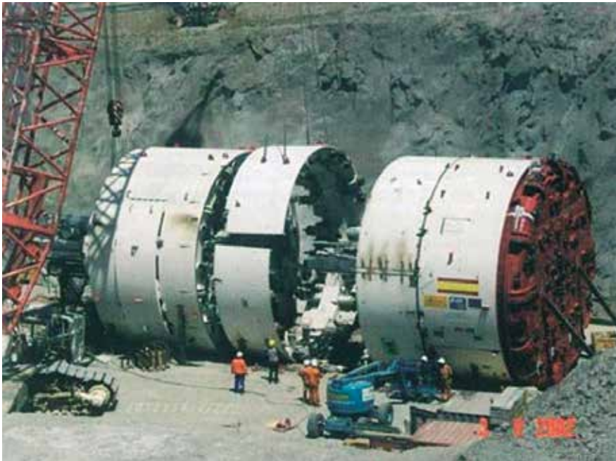
Fig. 45. Montaje de una tuneladora de doble escudo en los Túneles ferroviarios de Guadarrama
