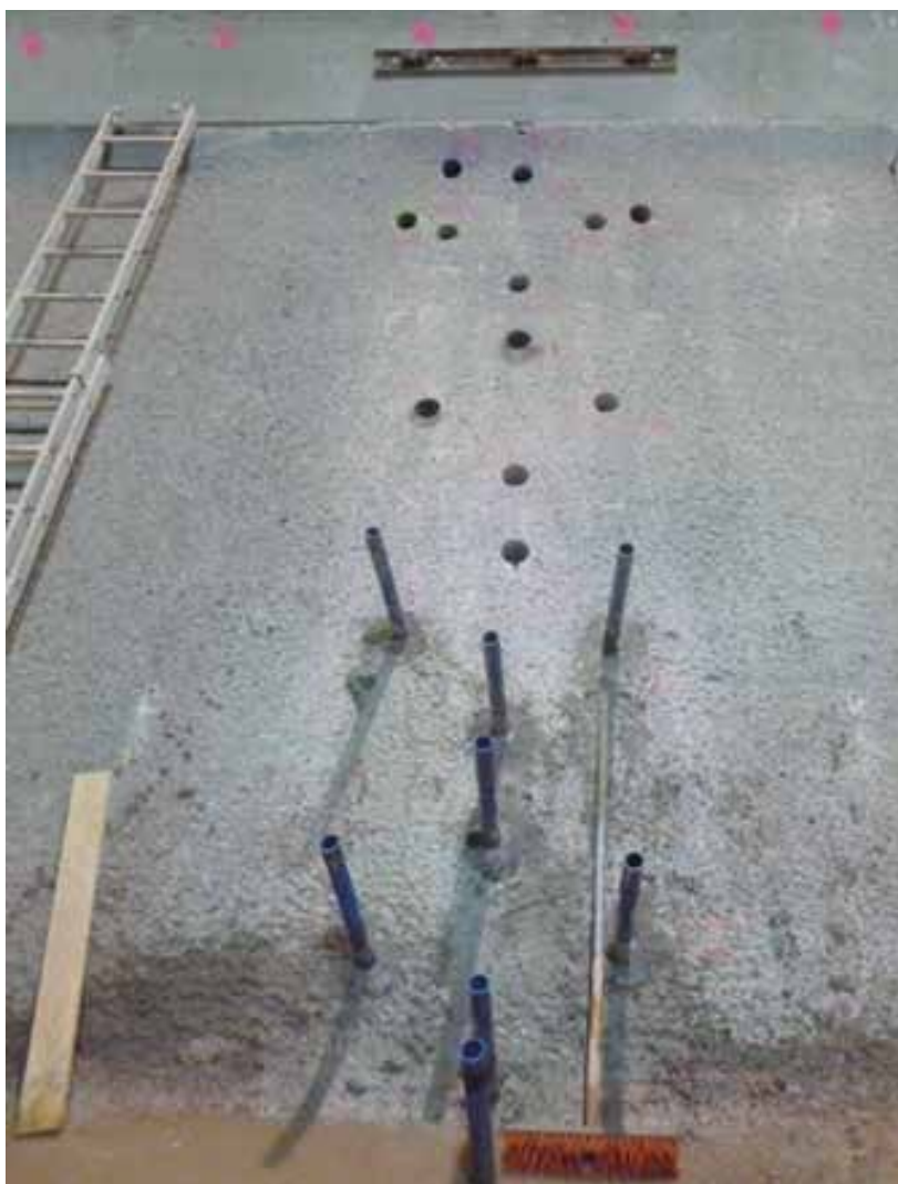
Fig. 13. Posición de los tubos de manga en la sección transversal del túnel
