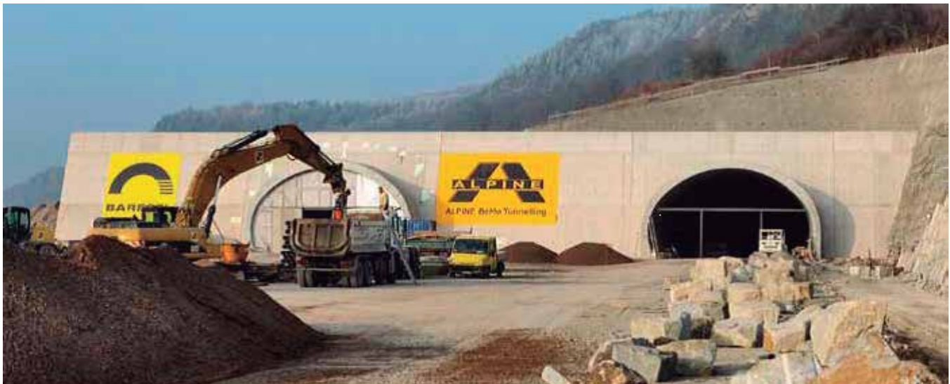
Fig. 1. Portal Este del Túnel de Jagdberg
