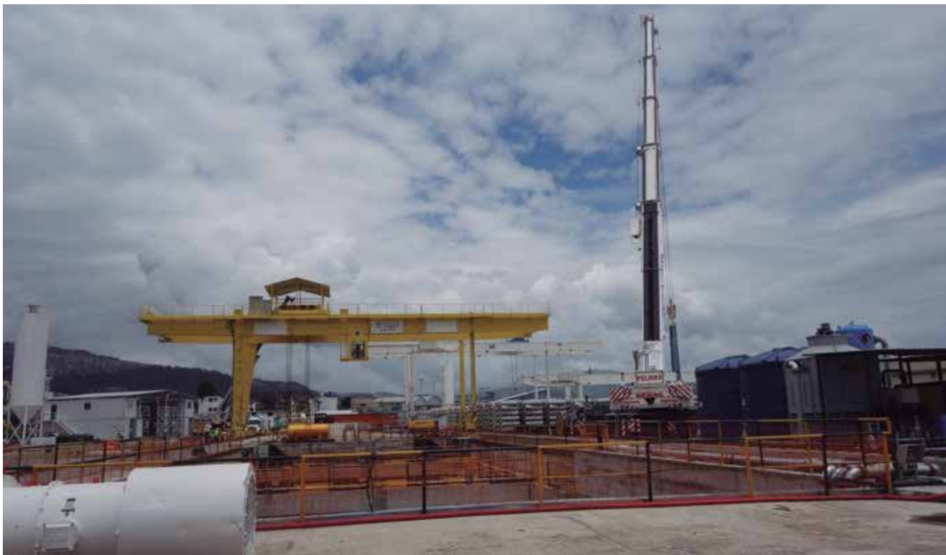
Fig. 4. Instalaciones generales de la obra
