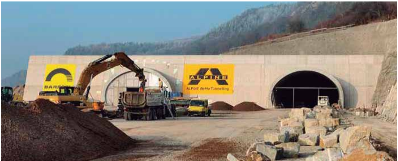
Fig. 1. Portal Este del Túnel de Jagdberg
