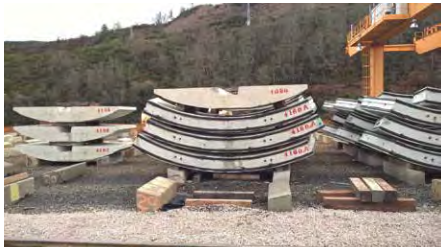
Fig. 10.b. Detalle dovela con doble junta de sellado
