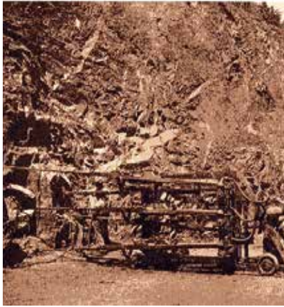
Fig. 19. Perforaciones con "jumbo" en el Túnel de La Argentina
