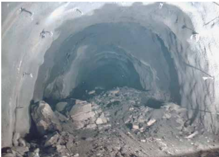
Fig. 4. Reperfilado y refuerzo de sostenimiento en el túnel ET TM 2225 (desde el Sur)
