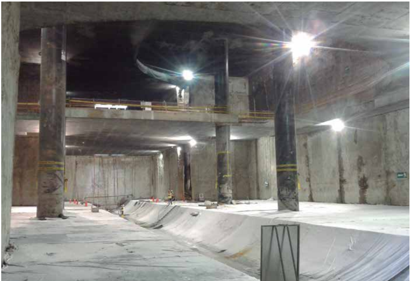
Fig. 1. Infraestructura de una estación terminada para el paso de TBM que construye el túnel
