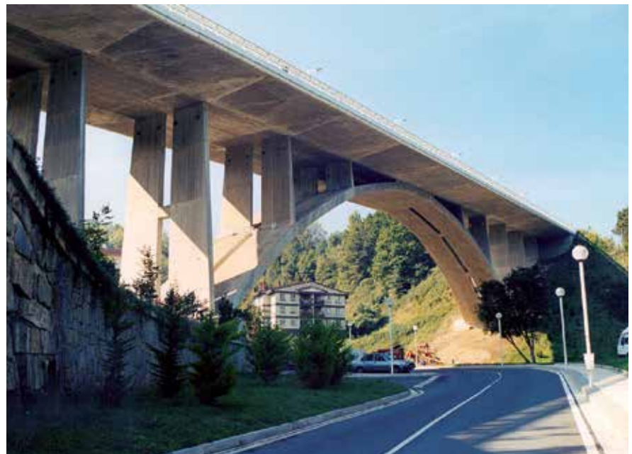
Fig. 5. Puente del Valle de Morlans en San Sebastián
