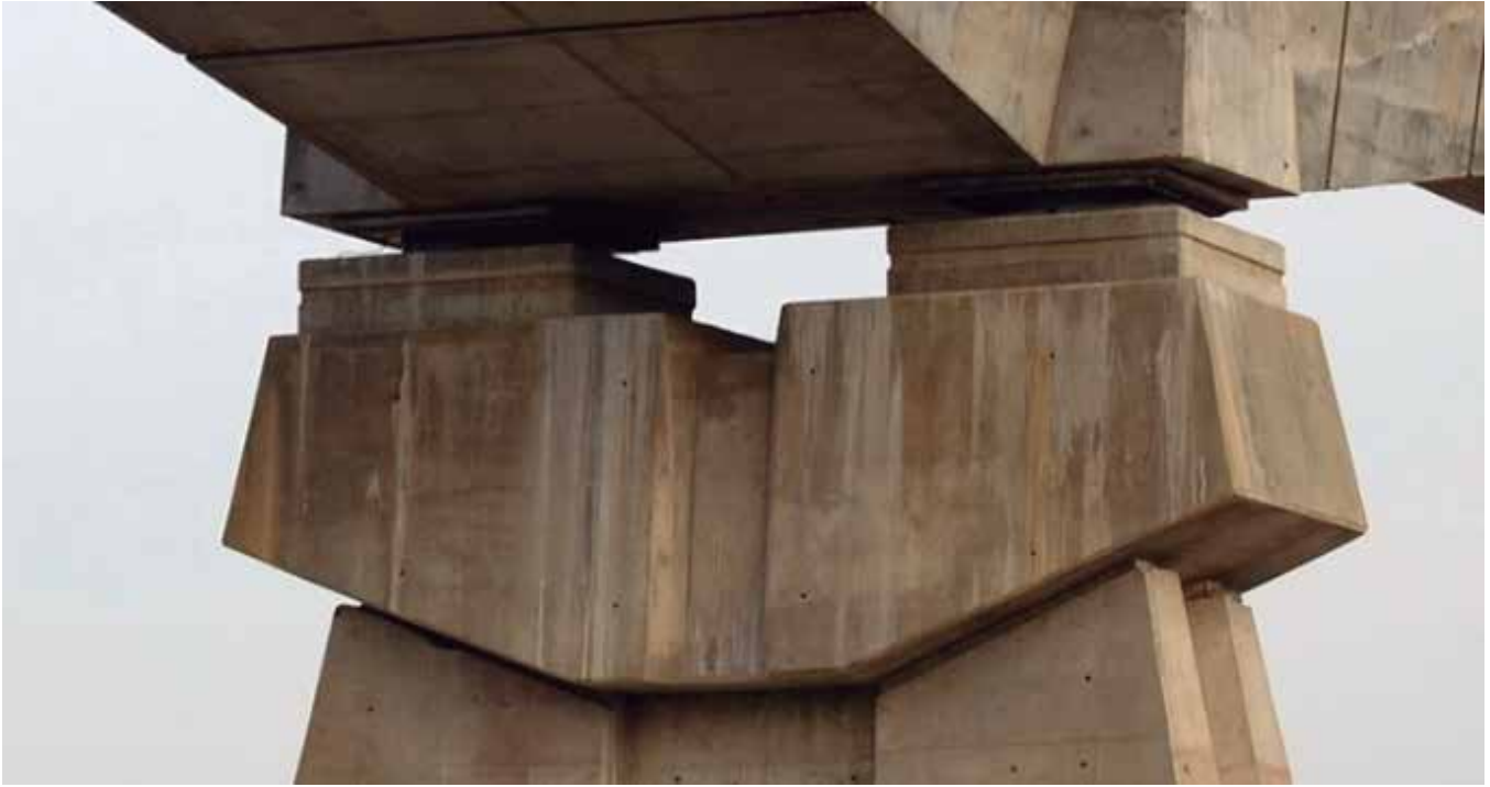
Fig. 2. Superficies de presión. Viaducto del AVE sobre el Zadorra. Vitoria 2011
