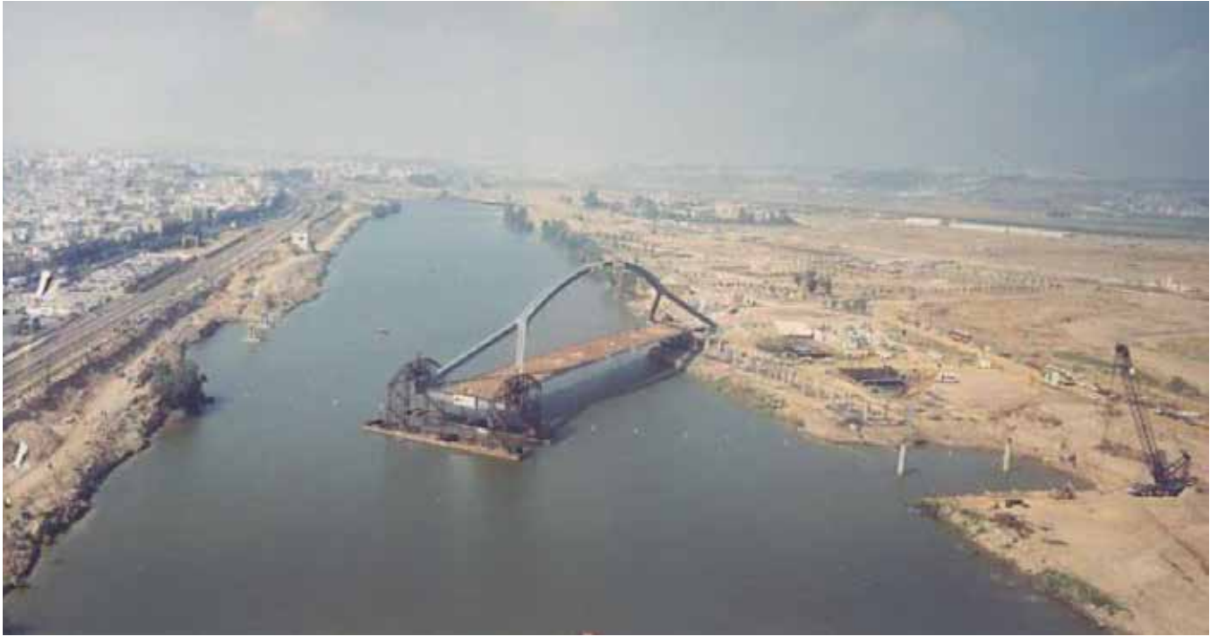
Maniobra de posicionamiento del Puente de la Barqueta
