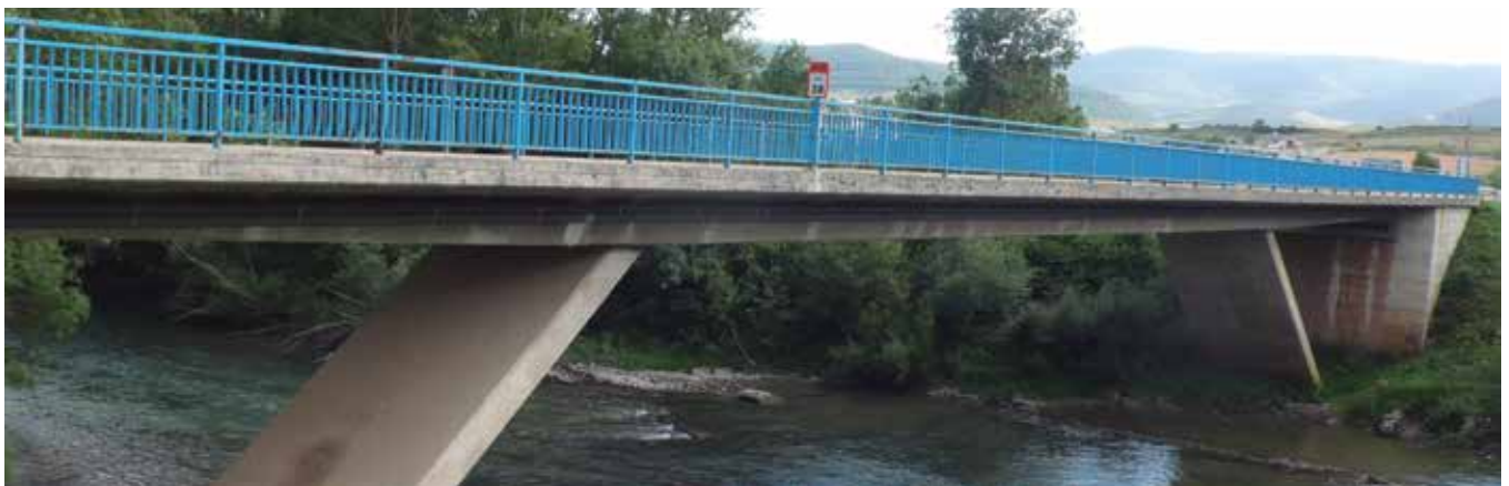
Fig. 1. Puente sobre el río Iraki en Lumbier (Navarra). Foto C. N.
