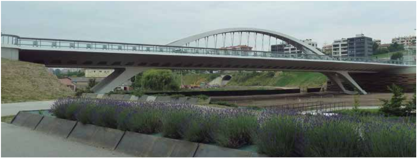
Fig. 11. Puente Juan José Arenas, sobre la Vaguada de Las Llamas en Santander
