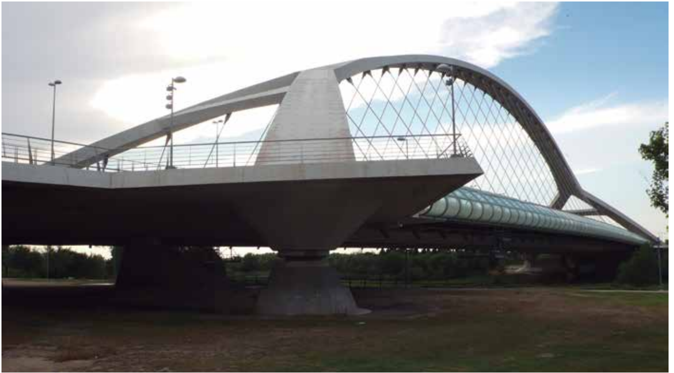
Fig. 5. Piezas de los apoyos del tablero del Puente del III Milenio. Foto C. N.
