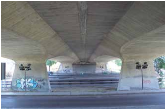
Fig. 2. Paso elevado de la Avenida de los Pirineos en Zaragoza. Foto C. N.
