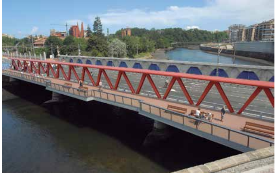
Fig. 12. Puente de la Real Sociedad de San Sebastián
