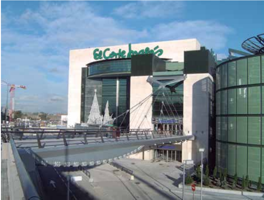
Fig. 6. Pasarela colgante autoanclada, suspendida del propio edificio del C.C. Sanchinarro
