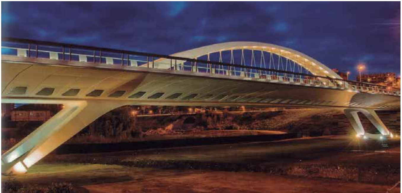
Fig. 2. Puente "Juan José Arenas"
