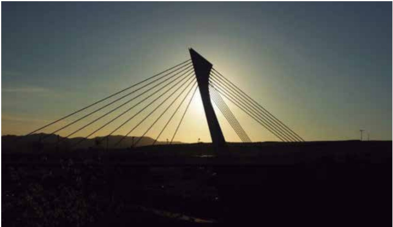
Fig. 5. Barras. Puente PCTCAN. Santander 2007
