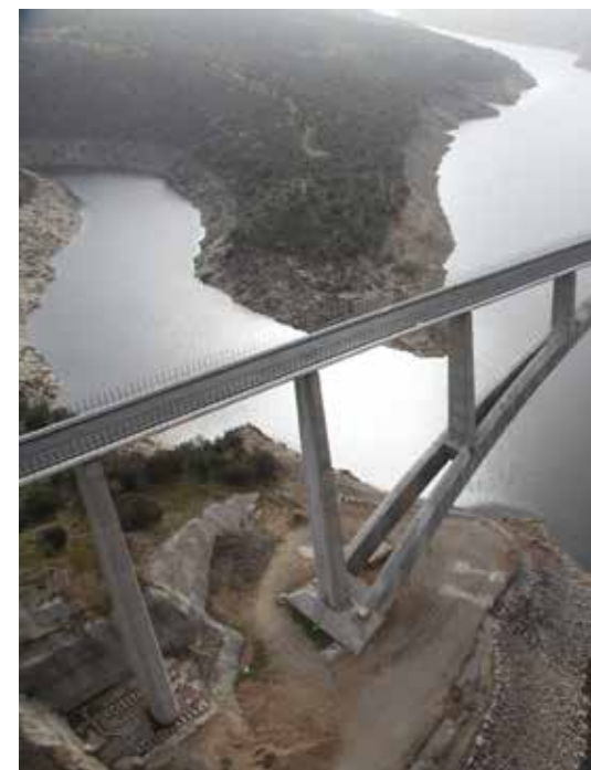
Fig. 10. Puente sobre el río Almonte en el Embalse de Alcántara
