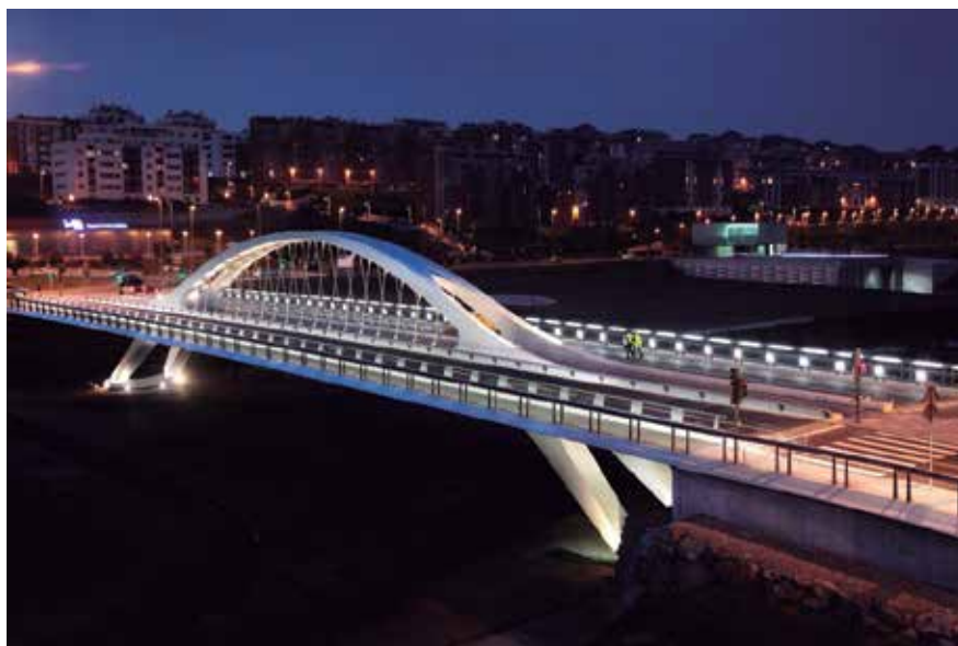
Figs. 6. El puente Juan José Arenas en Santander, uno de los proyectos de Arenas en Cantabria y que el Ayuntamiento de la capital regional dedicó al ingeniero, profesor y vecino de esta ciudad durante más de 40 años
