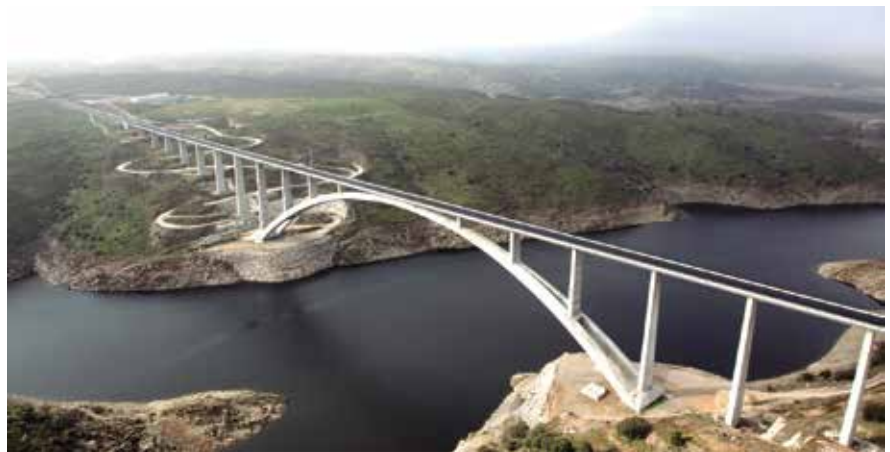
Fig. 14. Viaducto de Almonte, LAV Madrid - Extremadura
