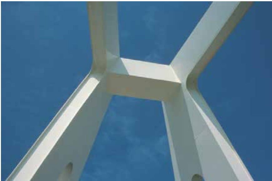
Fig. 2. Puente Puerta de Europa en el Puerto de Barcelona
