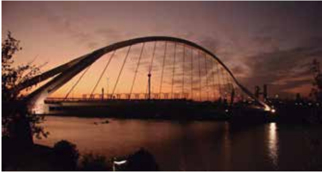
Fig. 3. Curvatura. Puente de la Barqueta. Sevilla 1992
