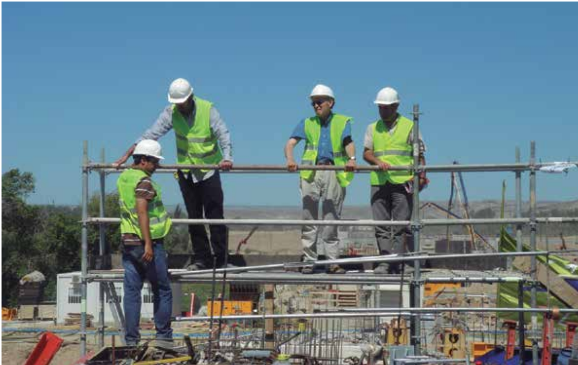
Fig. 3. Juan José Arenas supervisando las obras del Puente del Tercer Milenio
