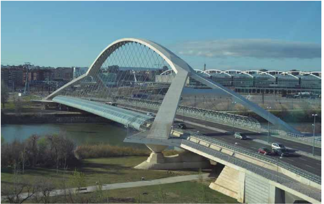
Fig. 6. Puente del Tercer Milenio. Expo Zaragoza, 2008
