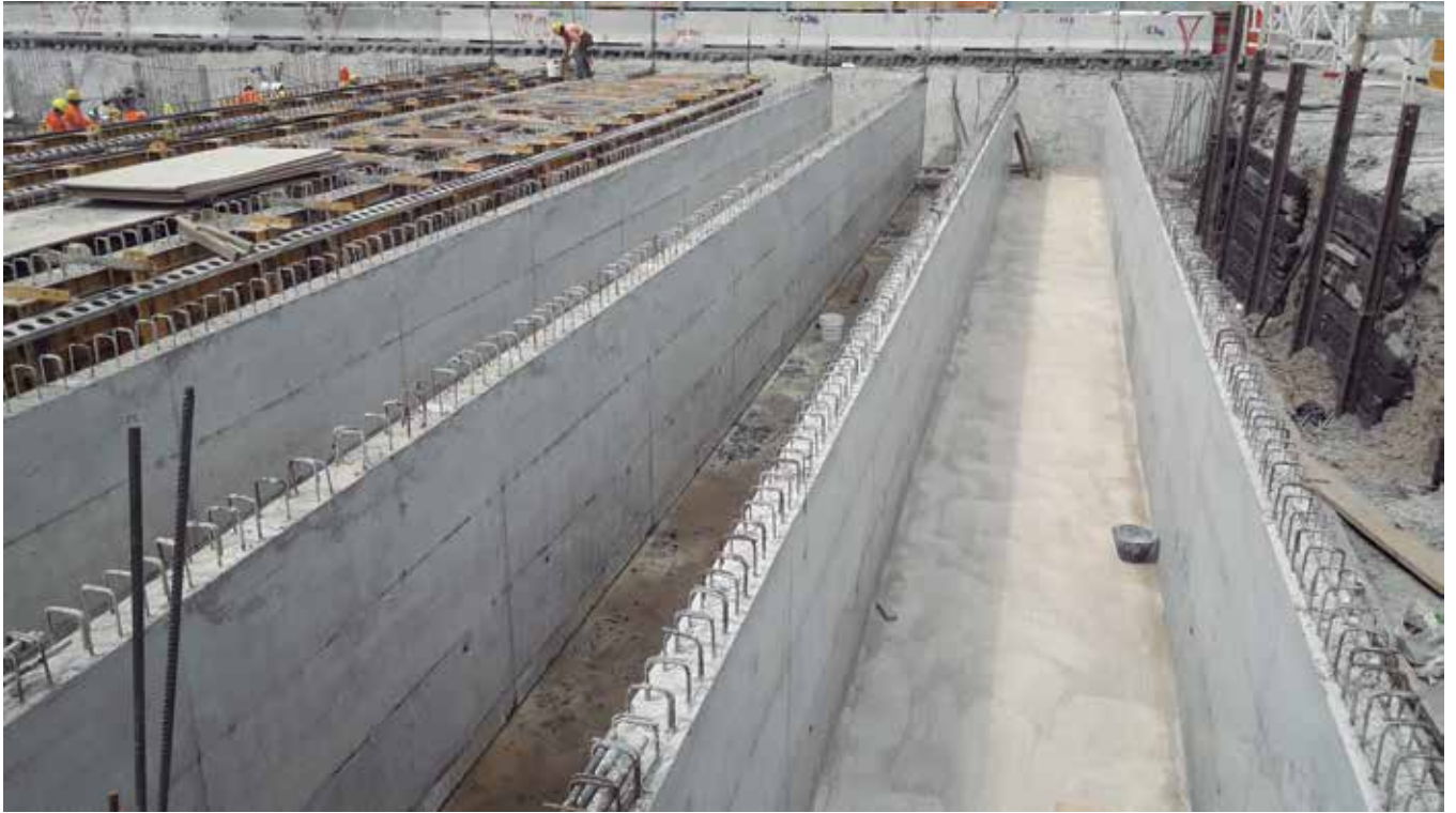
Vigas cajón en Puente Inmigrantes
