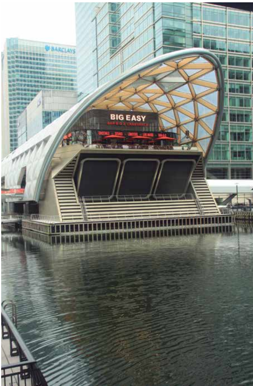
Fig. 20. Nueva estación para Crossrail en Canary Wharf
