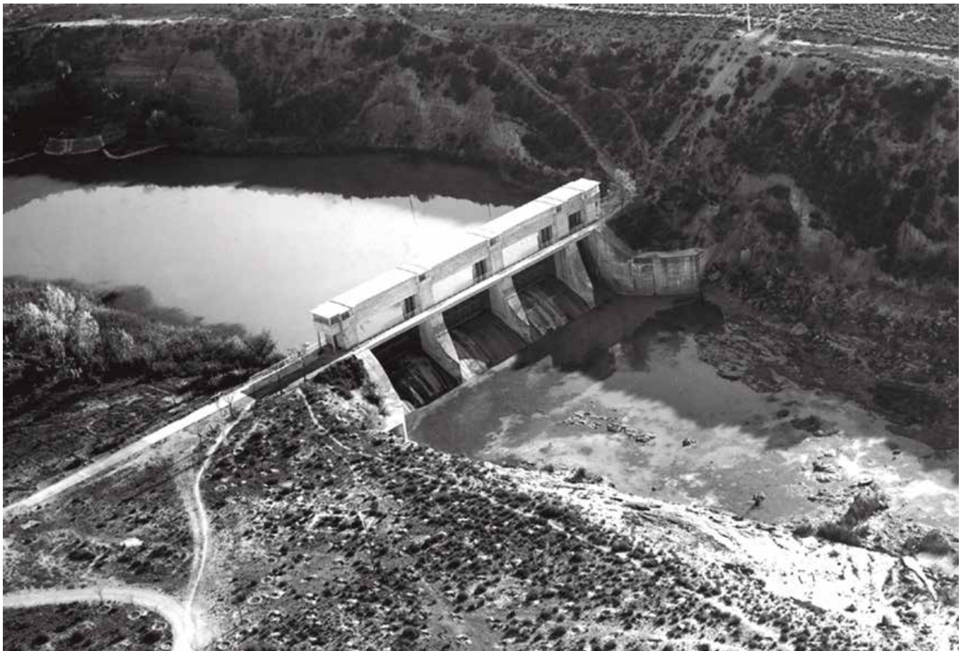
Presa de Zorita
