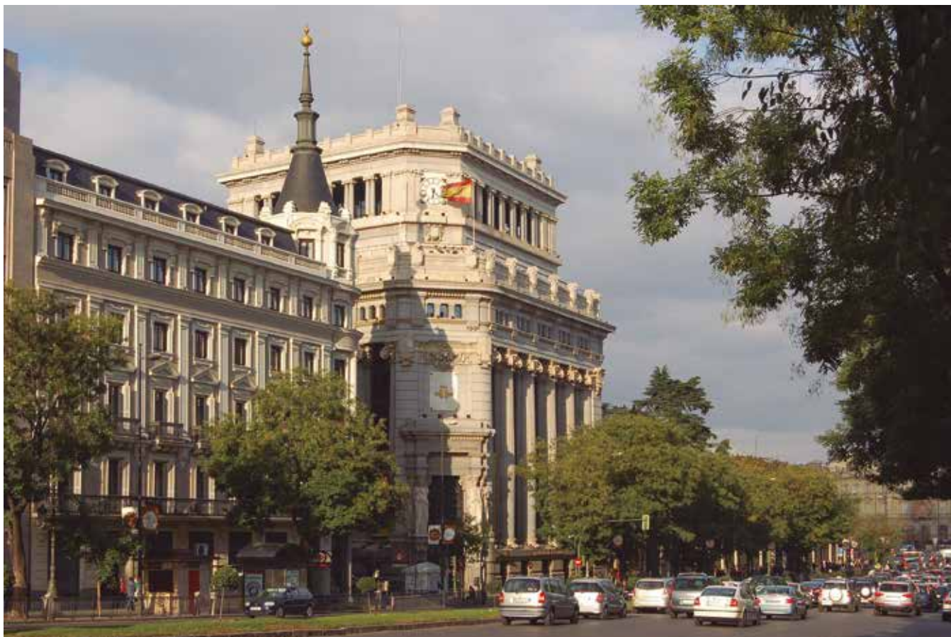
Lugar donde se encontraba el despacho de Becerril, en el edificio del Banco Urquijo, en la esquina de la calle de Alcalá con Barquillo
