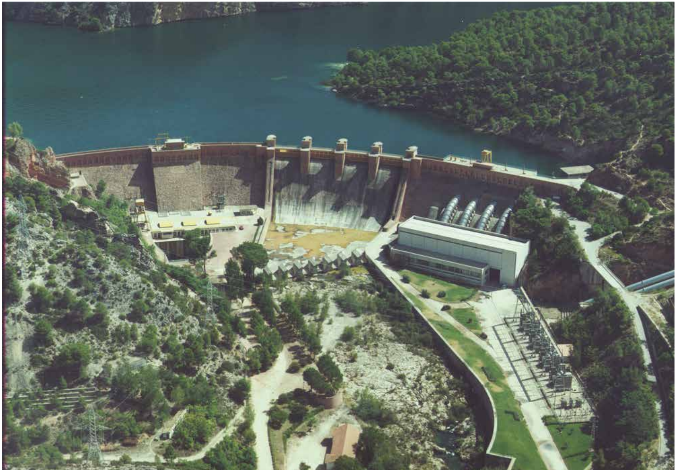
Presa de Bolarque
