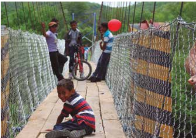
Fig. 7_ Vista desde el tablero de la pasarela Monte Verde terminada
