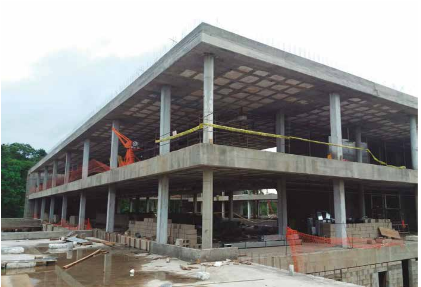
Construcción al complejo hospitalario en Villa Tunari, en Cochabamba
