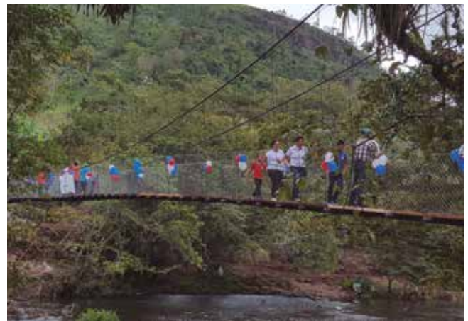
Fig. 8_ Vista lateral de la Pasarela San Vicente terminada
