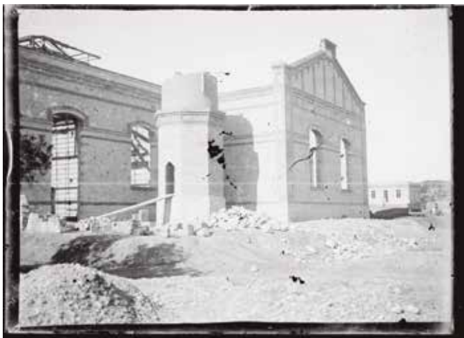
Fig. 1_ Construcción de la sala de bombas de la Planta de La Presa
