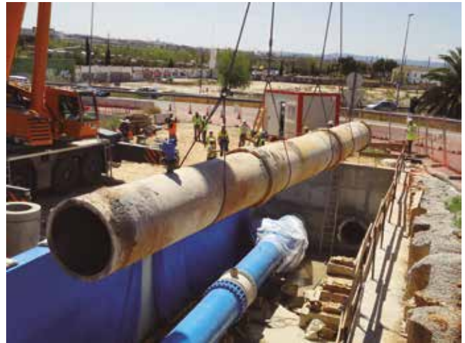
Fig. 4_ Actuación en aducción
