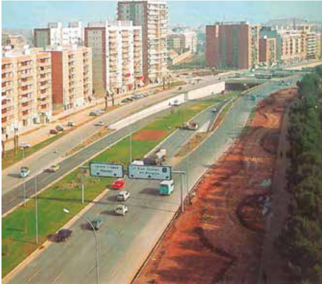
Paso inferior en la Avda. de Castilla
