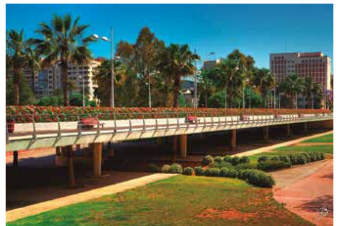
Fig. 3.5 (a)_ Puente de las Flores. Tablero mixto formado por un emparrillado metálico de retícula triangular y una losa superior de hormigón armado, empotrado en pilas cortas articuladas en su base (Iberinsa, 2003). Fuente: http://fosfilms.blogspot.com.es/2014/04/exposicion-los-puentes-de-valencia.html
