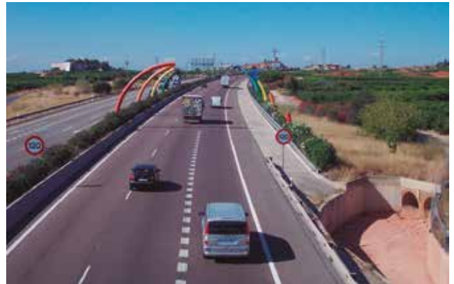
Bypass. Autovía circunvalación de Valencia A-7
