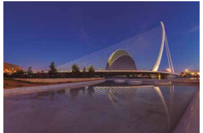
Fig. 3.10 (a)_ Pont de l’Assut de l’Or. Puente atirantado metálico de vano único con tablero multicelular, torre en ménsula curva y tirantes múltiple dispuestos en harpa (Santiago Calatrava Valls, 2008). Fuente: Diego Delso, delso.photo, License CC-BY-SA
