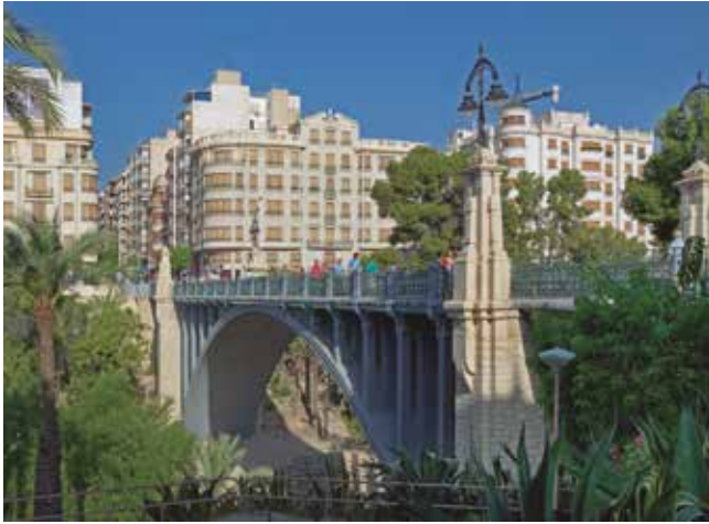
Puente de Canalejas sobre el río Vinalopó, Elche (Alicante). Foto: J. García, CDR
