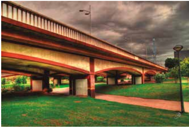
Fig. 3.7_ Primer puente de Monteolivete. Dos tableros paralelos formados por dos vigas cajón mixtas con pretensado exterior (José Antonio Fernández Ordóñez y Julio Martínez Calzón, 1992). Fuente: http://fosfilms.blogspot.com.es/2014/04/exposicion-los-puentes-de-valencia.html
