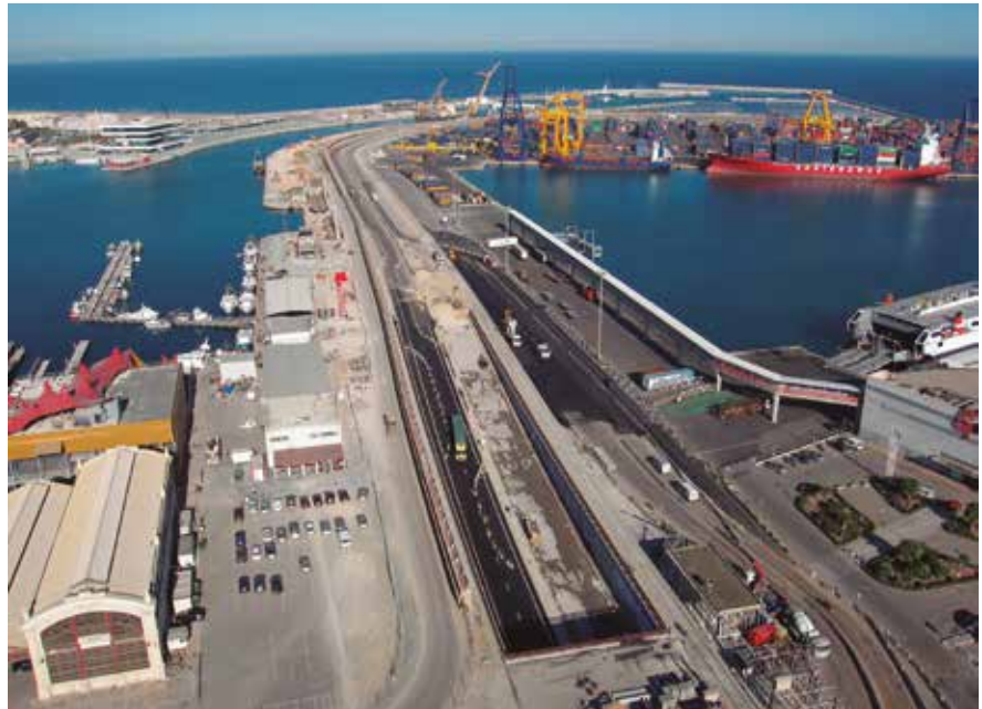
Puerto de Valencia Accesos ferroviarios (Foto Pablo Neustadt)
