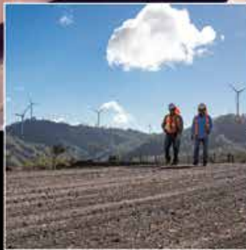
Parque eólico de Chichayote, Honduras Ingeniería de obra civil e instalaciones y supervisión de la construcción.
