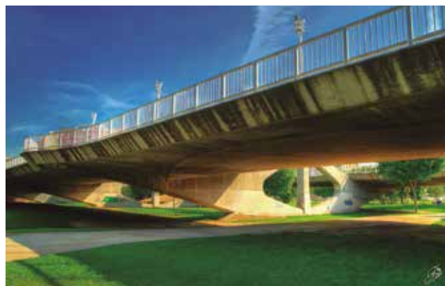
Fig. 3.2 (a)_ Puente de las Artes. Dos tableros paralelos formados por losas aligeradas de canto variable de hormigón pretensado, unidos transversalmente mediante cuatro pilas en forma de rombo (Leonardo Fernández Troyano, 1998). Fuente: http://fosfilms.blogspot.com.es/2014/04/exposicion-los-puentes-de-valencia.html
