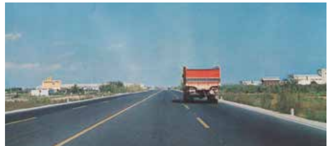
Acceso Sur por Pista de Silla
