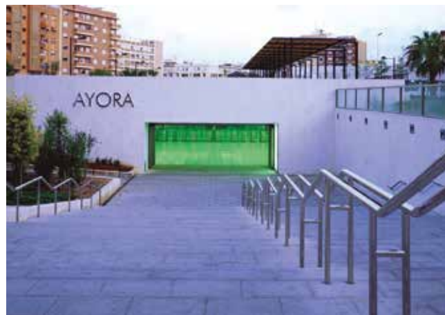
Fig. 6_ Estación de Ayora. Líneas 5 y 6. El acceso directo desde el nivel de calle al nivel de vestíbulo, obra de J. Pérez Iguualada, logra incorporar el espacio subterráneo al tejido urbano del entorno. Fotografía de J. Pérez Iguualada.
