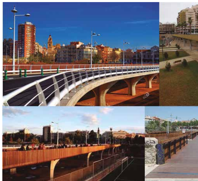
Fig. 3.3 (a)_ Pont de Fusta. Dos tableros paralelos formados por losas aligeradas de canto constante de hormigón armado, soportados mediante pilas de cuatro ramas (Juan Francisco Moyá, Ignacio Company y José María Tomás, 2012). Fuente: http://gecival.com/es/direccion-de-obra-construccion-nou-pont-de-fusta-en-valencia-espana/
