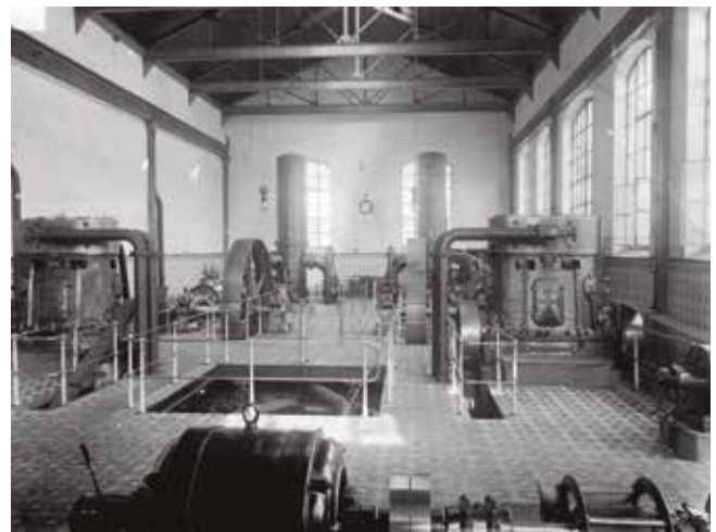
Fig. 2_ Grupos de vapor de la sala de bombas de Planta de La Presa
