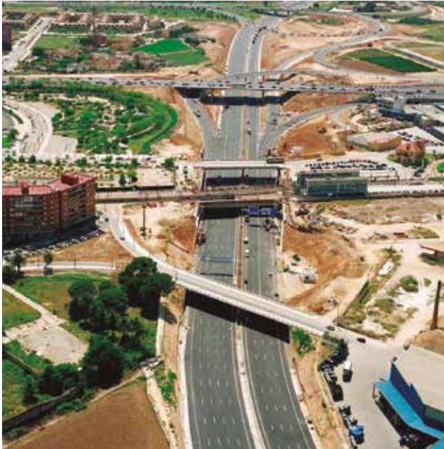
Conexión CV-30 con CV-35 y Ronda Norte
