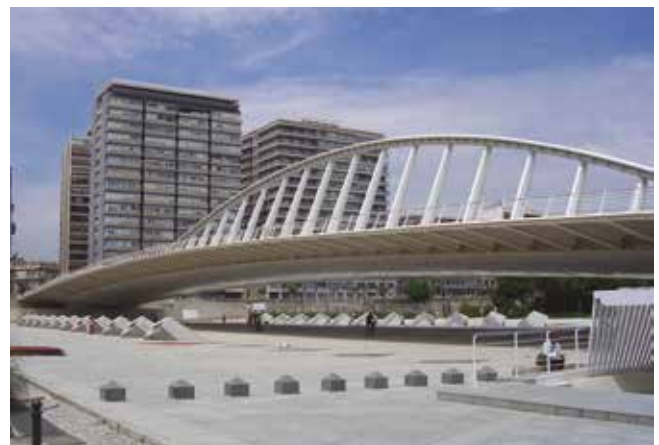
Fig. 3.4 (a)_ Puente de la Exposición. Tablero metálico multicelular formado por tres vanos, dos vanos de acceso cortos simplemente apoyados y el vano central rigidizado por un arco superior conectado al tablero mediante péndolas rígidas (Santiago Calatrava Valls, 1995). Fuente: https://upload.wikimedia.org/wikipedia/commons/thumb/8/8e/Puente_Exposicion_Valencia_Spain.jpg/970px-Puente_Exposicion_Valencia_Spain.jpg
