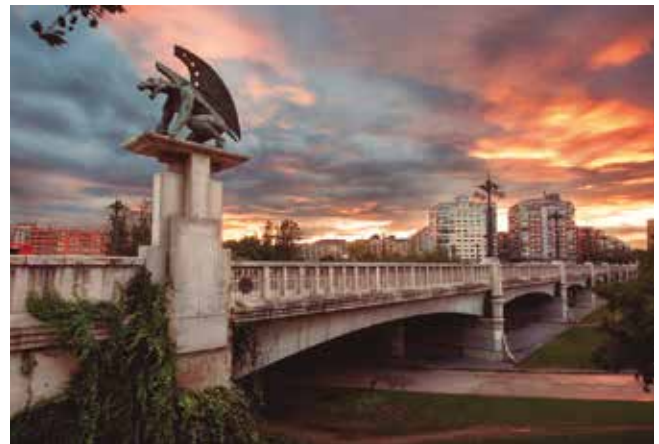
Fig. 3.6 (a)_ Pont del Regne. Dos tableros paralelos formados por vigas de hormigón pretensado, prefabricadas y de canto variable, simplemente apoyadas (Salvador Monleón Cremades, 1999). Fuente: canonistas.com
