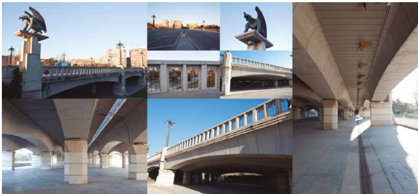
Fig. 3.6 (b)_ Pont del Regne. Vistas
