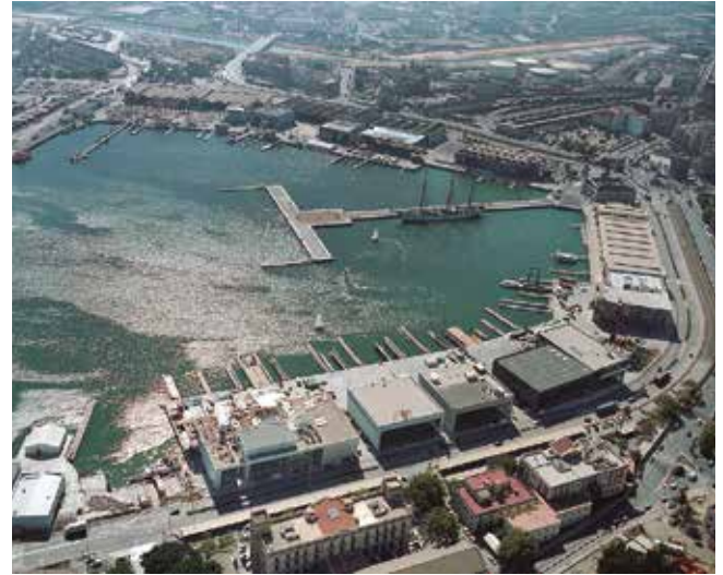
Fig. 2_ Dársena interior con pantalán, adelantamiento de cantiles y bases en uso
