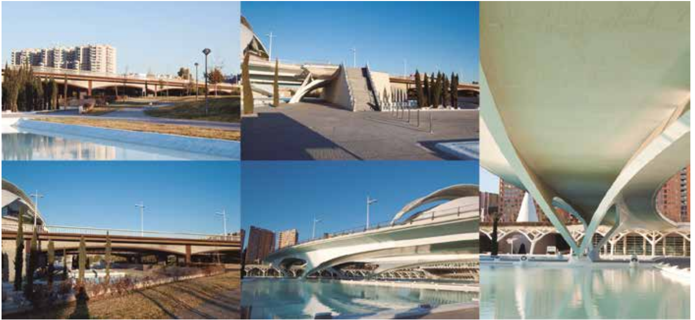
Fig. 3.9_ Puentes de Monteolivete. Vistas
