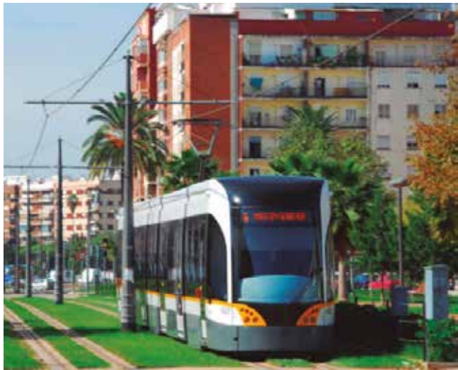
Tranvía de Valencia. Línea 6. En la Avenida Alfahuir se optó por una sección de carril enbebido en viga continua de hormigón armado e implantación de césped en el resto de la sección
