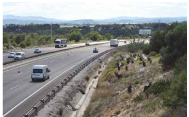
Bypass. Autovía Circunvalación de Valencia A-7
