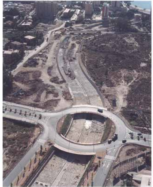
Alicante. Encauzamiento barrancos Orgegia y Juncaret
