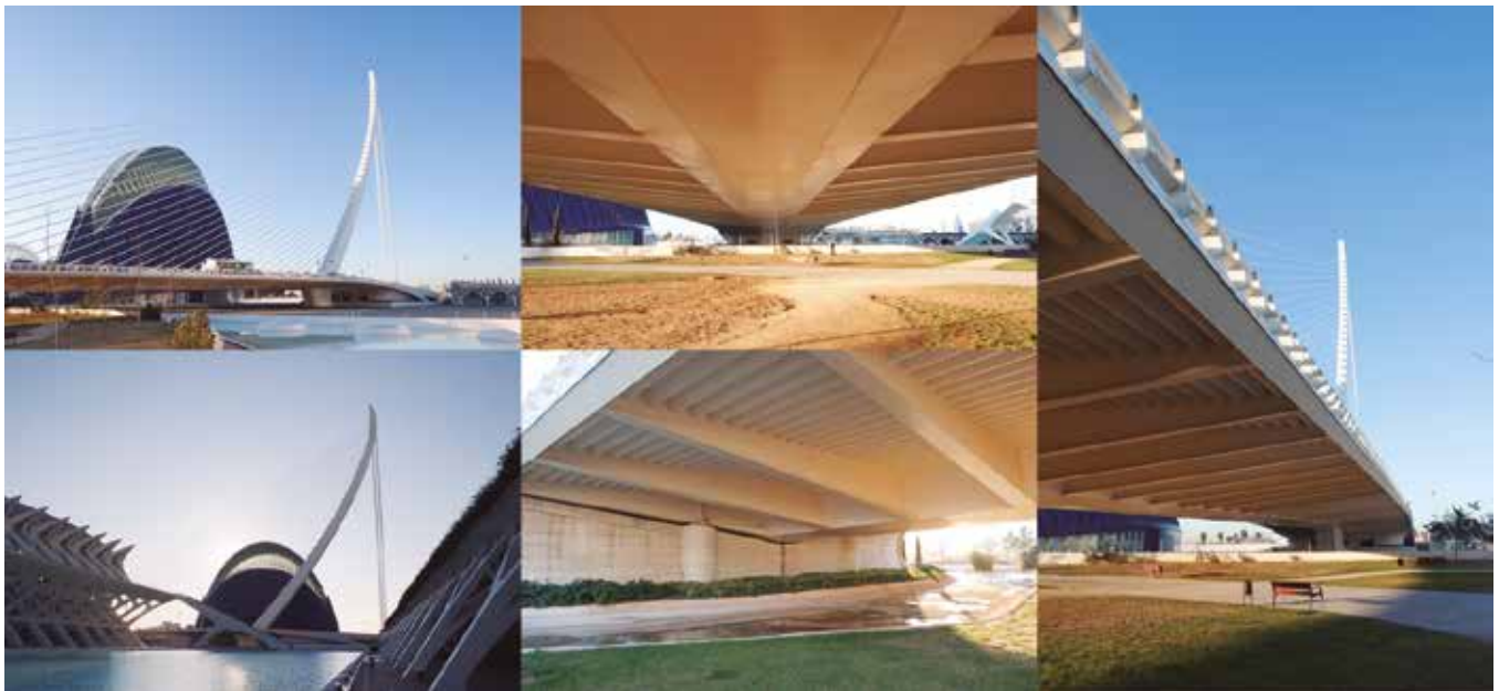
Fig. 3.10 (b)_ Pont de l'Assut de l'Or. Vistas
