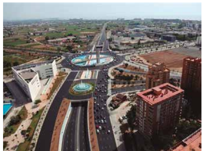
Ronda Norte. Conexión con Avda. Cataluña y V-21
