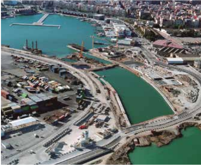
Fig. 1_ Obras en la dársena interior y nuevo canal de acceso. Octubre 2005
