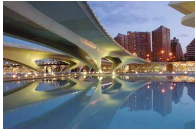
Fig. 3.8_ Segundo puente de Monteolivete. Dos tableros paralelos de fuerte curvatura en planta, formados por dos vanos en semi-arcos rígidos compensados (Santiago Calatrava Valls, 2001). Fuente: http://www.grupoetra.com/en/
