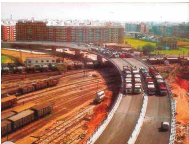
Paso sobre las vías. Prueba de carga
