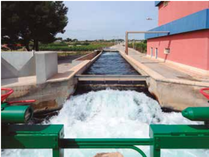
Fig. 3_ Canal de oxidación y reparto Planta de "El Realón"
