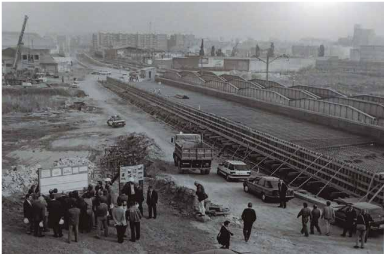
Fig. 14_ Obras de soterramiento de las vías (túnel del Cabanyal) hacia finales de los 80
