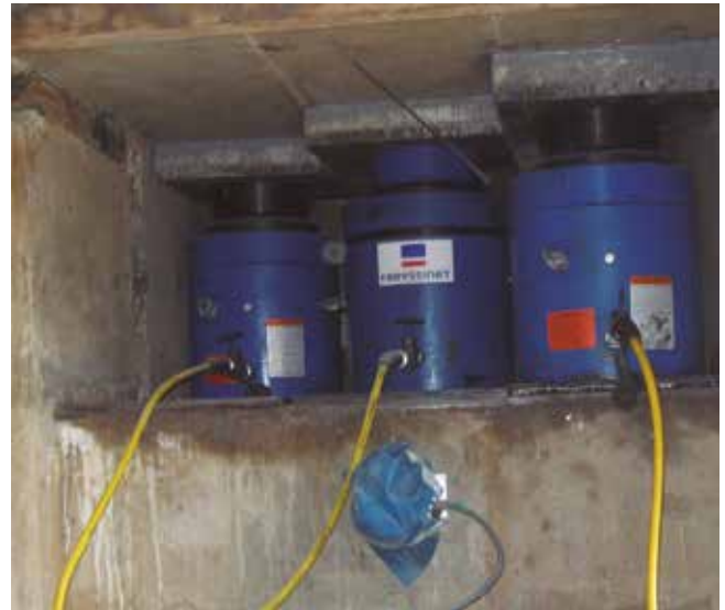
Fig. 12. Cimentación apeada: excavación inferior
