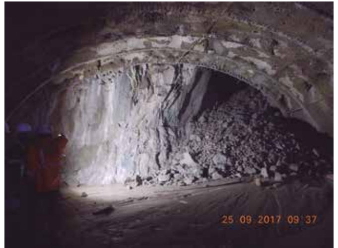
Fig. 33. Derrumbe en frente Muyupampa por lavado de juntas con arrastre de material
