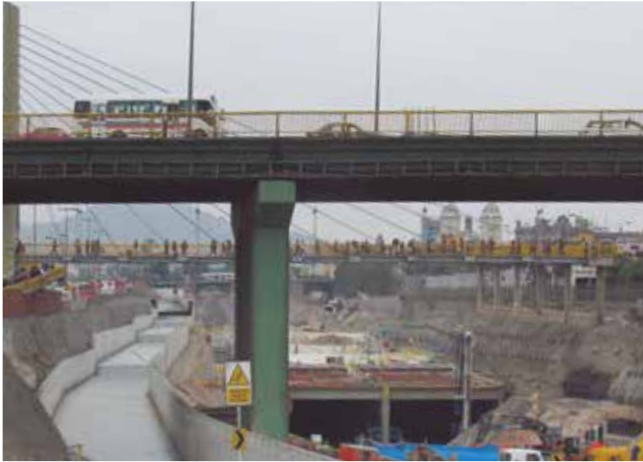
Fig. 3. Canal de desvío del río Rímac
