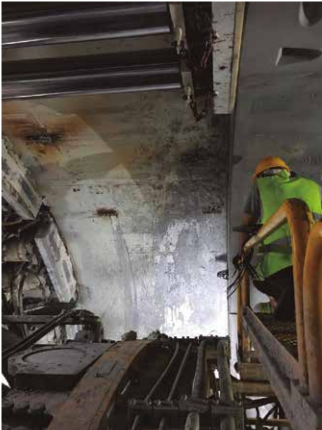
Fig. 4. Montaje de anillo de dovelas e inserción de los biconos. Los biconos se fijan con una silicona para mantenerlos en posición durante las operaciones.
