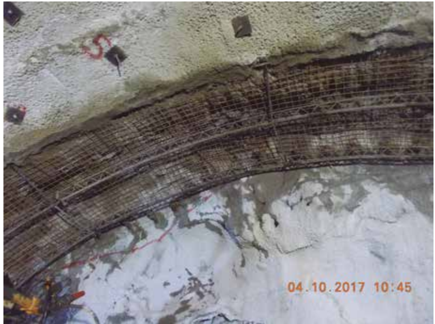
Fig. 34. Refuerzo con malla electrosoldada y pernos
