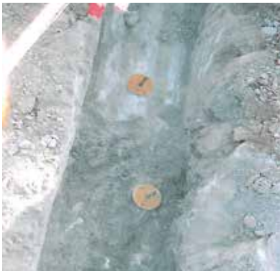
Fig. 5a. Calicata C-1 (p. k. 304+493)
