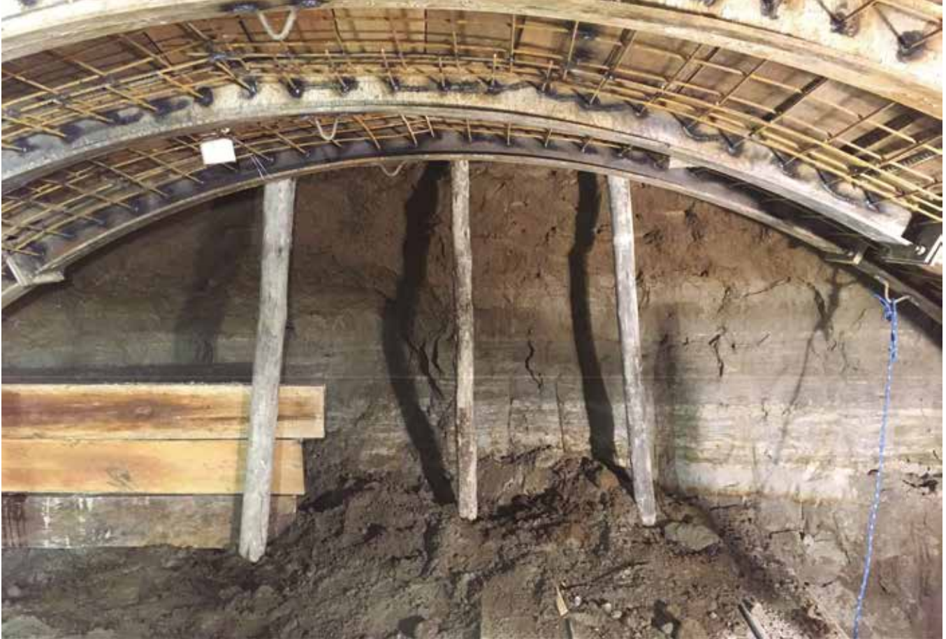
Fig. 1. Frente de excavación
