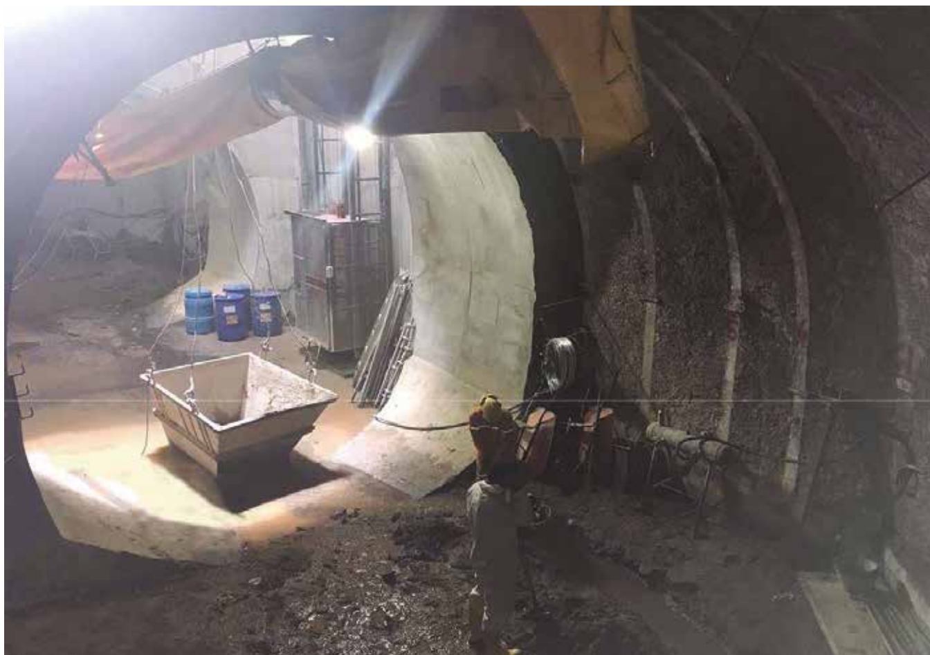
Fig. 7. Entronque de galería con pozo
