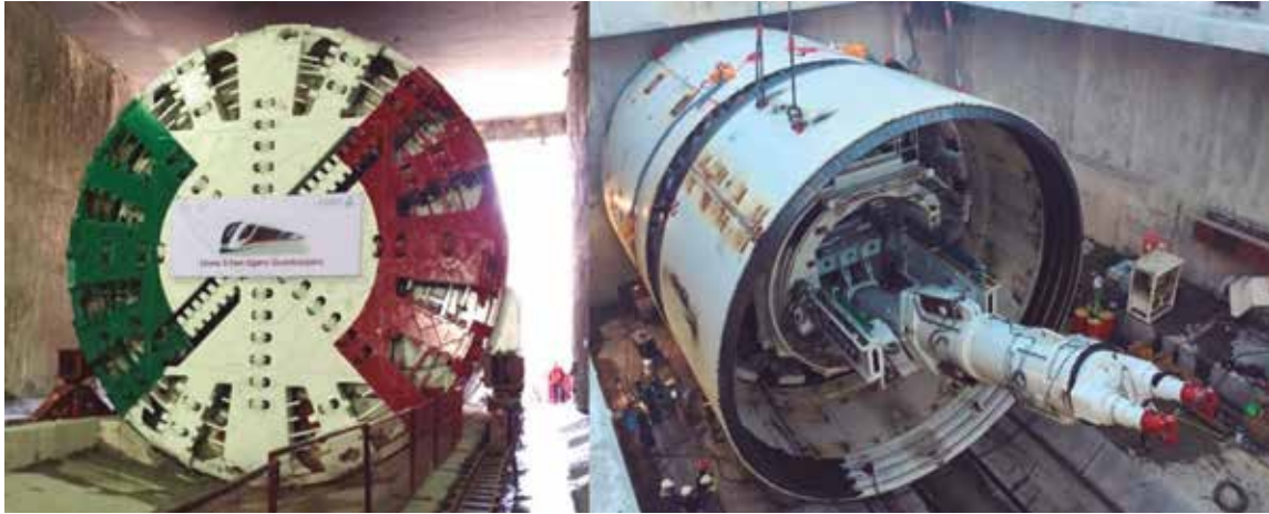
Fig. 2. Tuneladora tipo EPB empleada en la construcción del túnel
