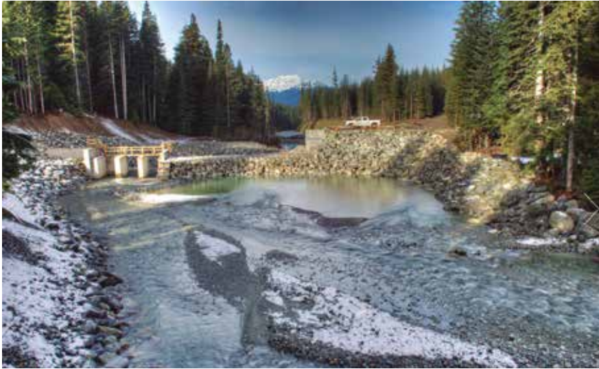
Imagen superior_ Construcción del azud de la minicentral de la estación de Whistler Blackcomb. Imagen de www.ledcor.com
