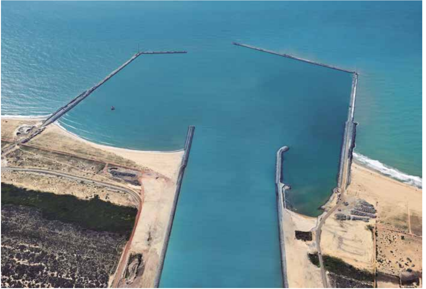
Terminal TX-2 del Puerto de Açú (Acciona)
