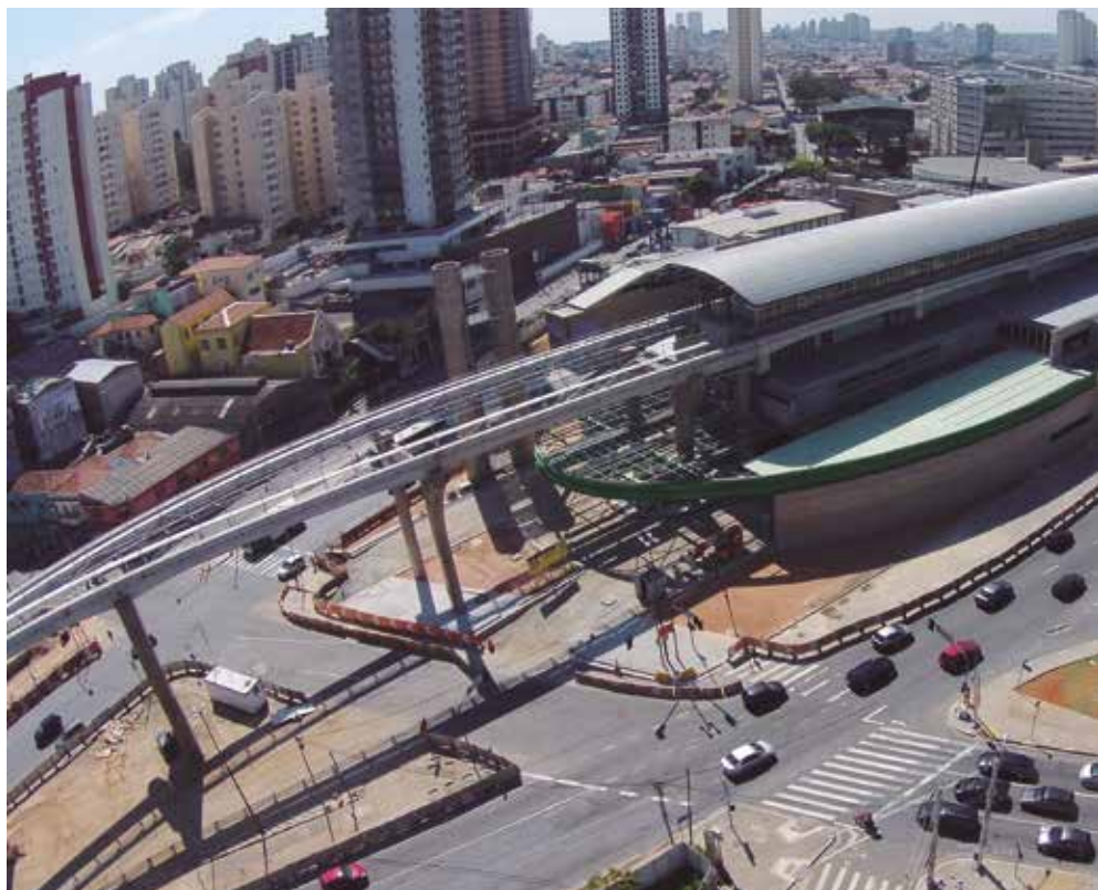
Estación de Vila Prudente, Metro de São Paulo (Sacyr)
